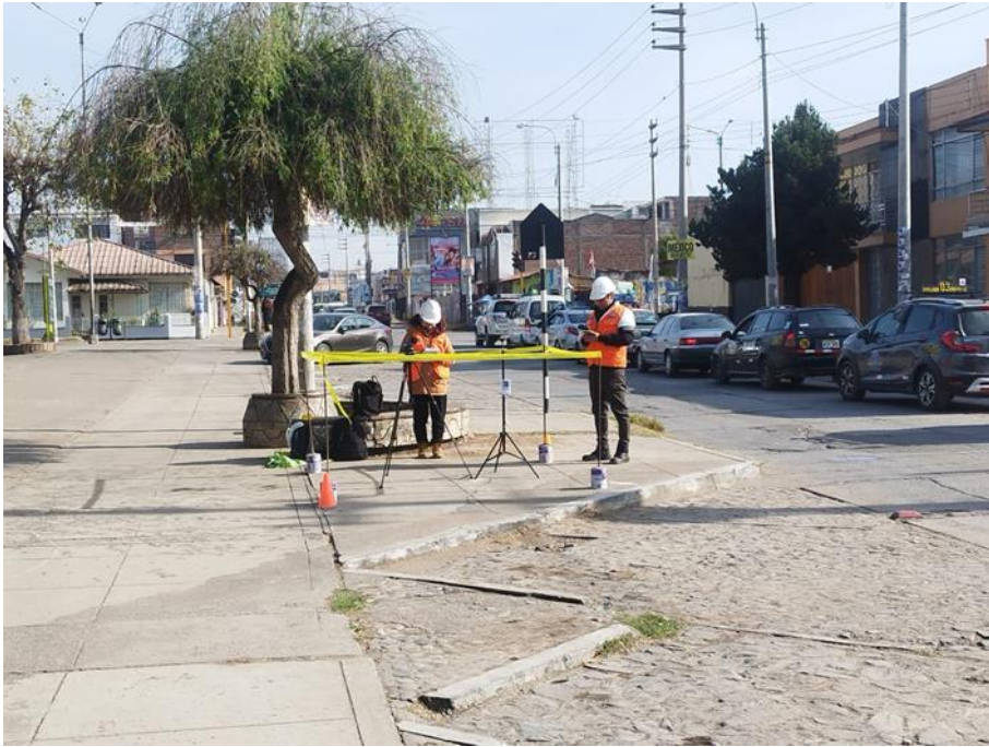
Fotografía panorámica del PMR-3
