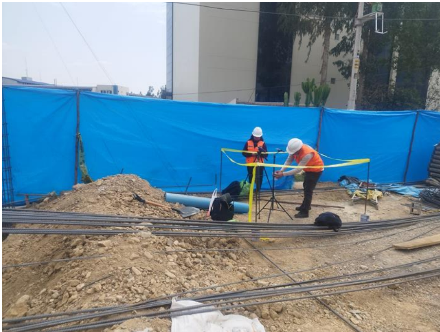
Fotografía panorámica del PMR-4
