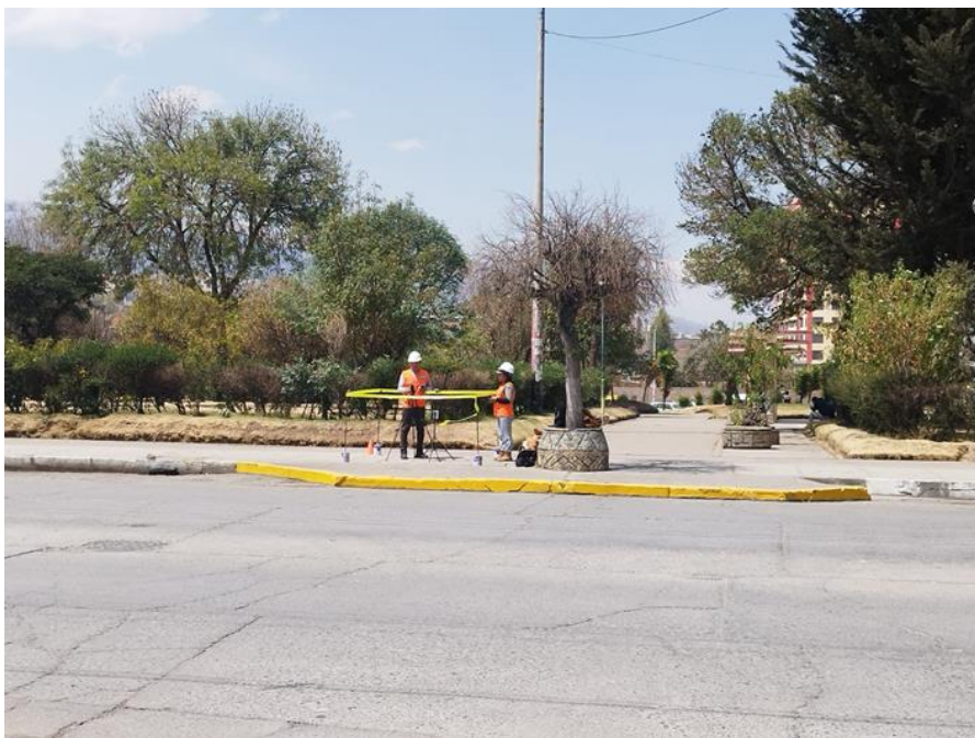
Fotografía panorámica del PMR-2
