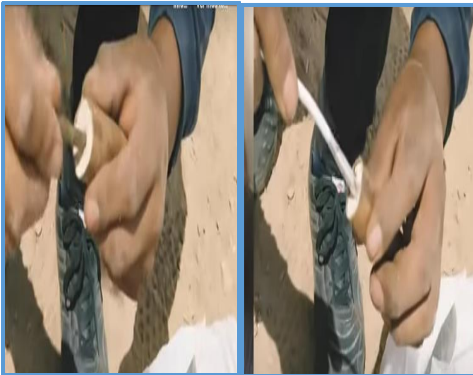
Figura 14. Realizando el hueco con punzón de madera e introduciendo la mecha armada en la dinamita
