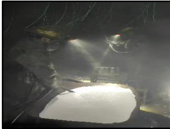
Figura 15. Elaboración del Anfo Tomada del Manual práctico de voladura Exsa, 2019
