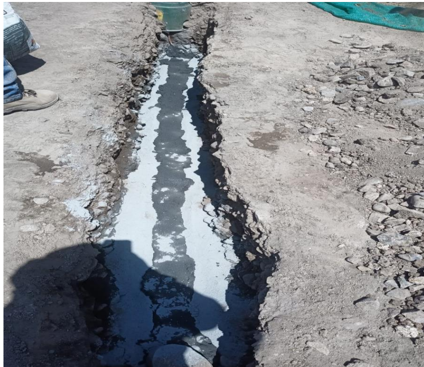
Figura 24. Mantenimiento correctivo de SPAT – instalación de contrapeso
