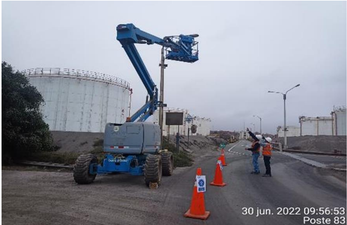
Figura 19. Mantenimiento preventivo de luminarias de alumbrado público con manlift
