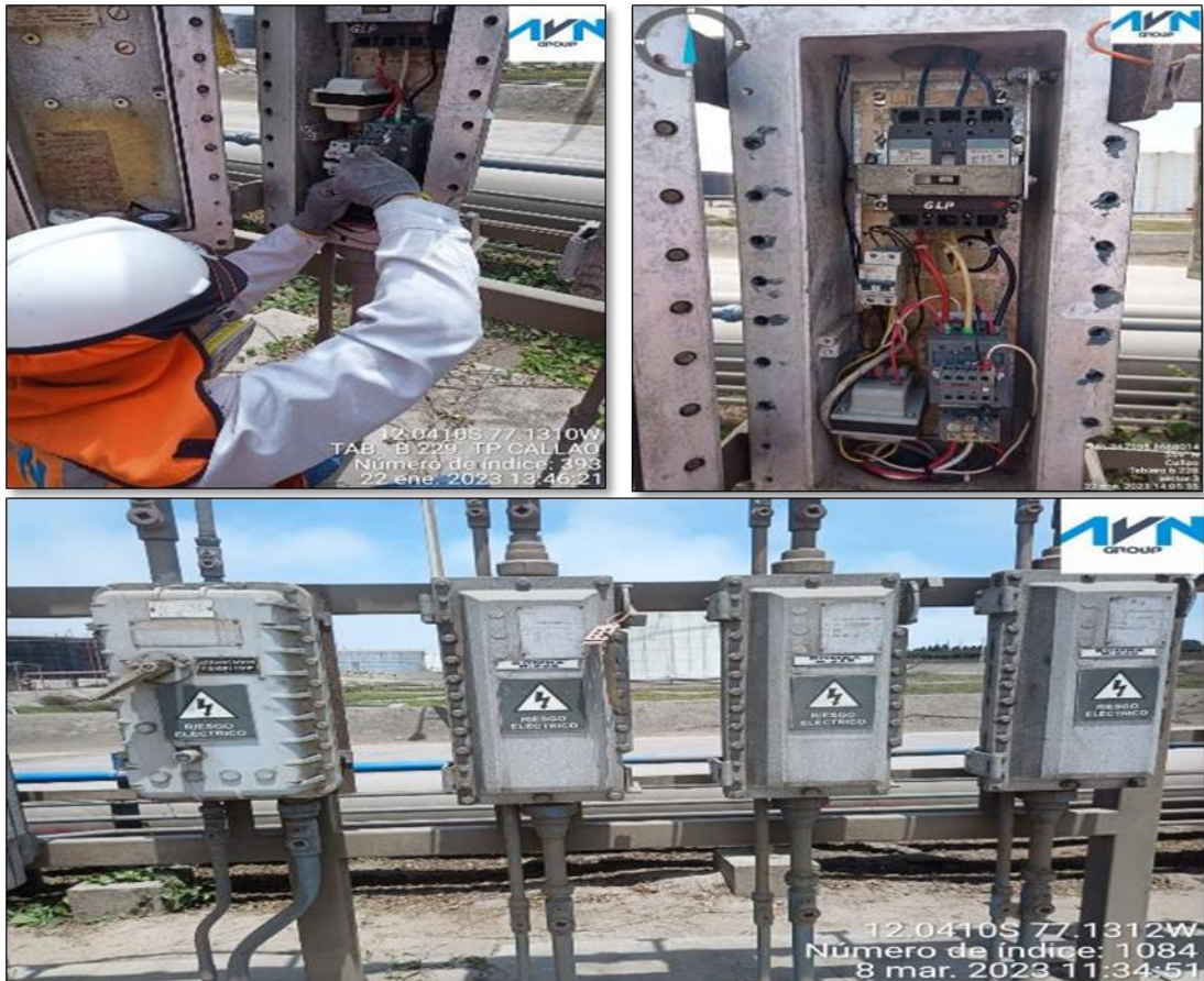
Figura 20. Mantenimiento preventivo de tableros eléctricos a prueba de explosión
