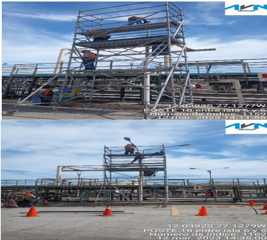
Figura 18. Instalación de luminarias y pastorales en postes de alumbrado – islas de despacho
