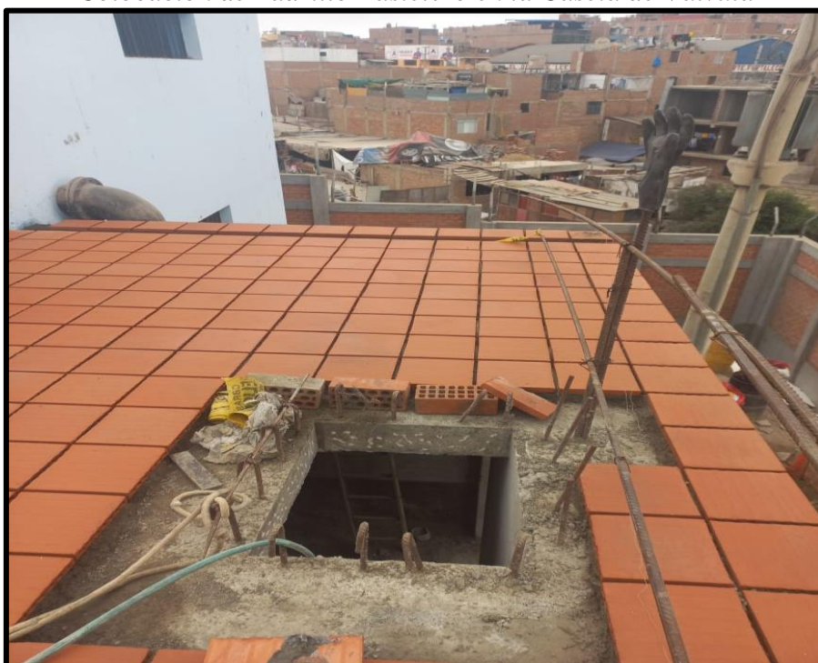
Figura 117 Colocación de Ladrillo Pastelero en la Caseta de Válvula
