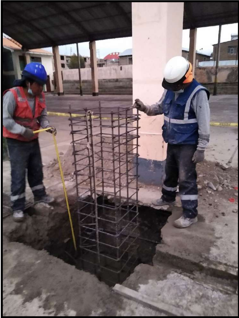
Figura 163. Nivelación de Canastilla de columna.
