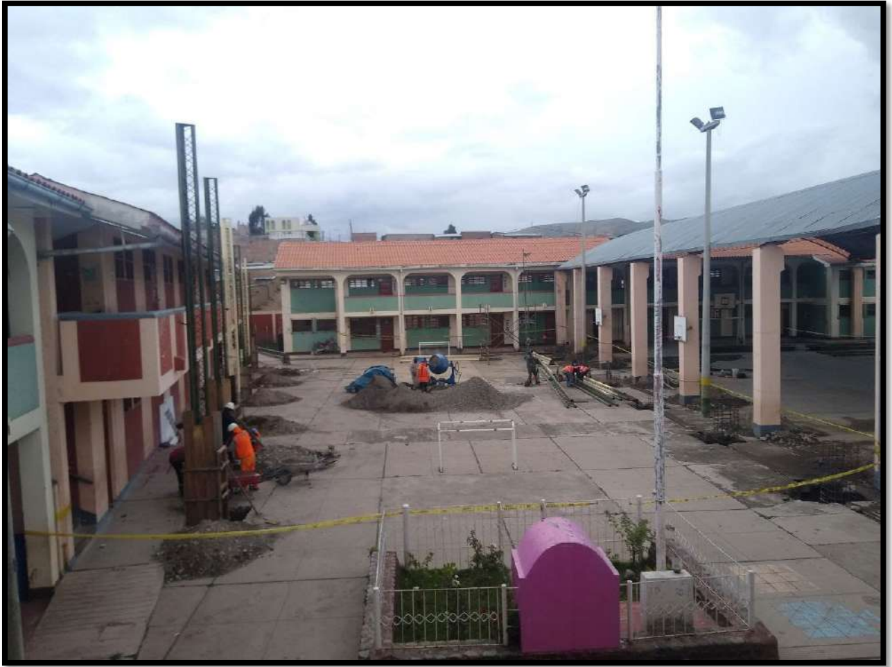
Figura 168. Izaje de columnas lado izquierdo.
