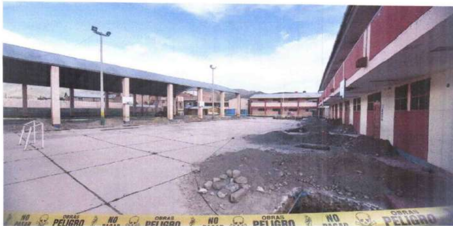
FOTOGRAFIA N° 02: . Imagen de la obra, GMT 16:25:11, miércoles 02 de marzo del 2022
