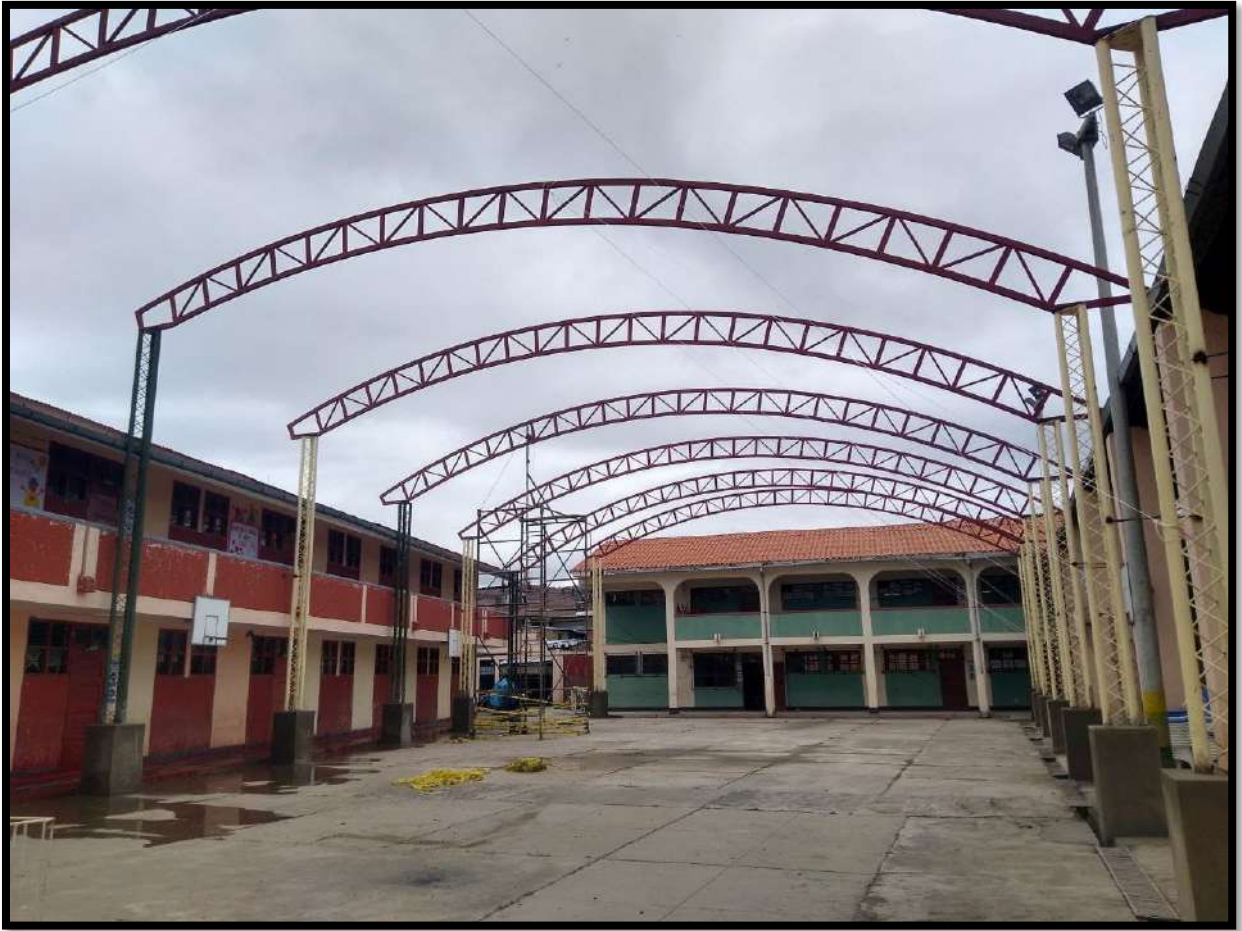
Figura 170. Izaje de vigas metálicas.
