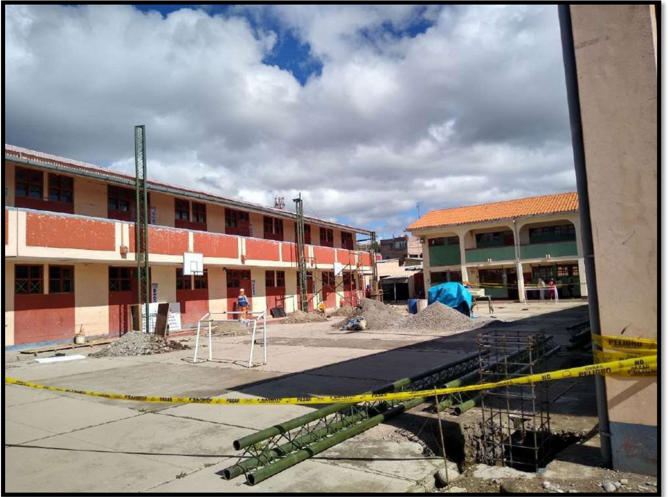
Figura 167. Izaje de columnas.
