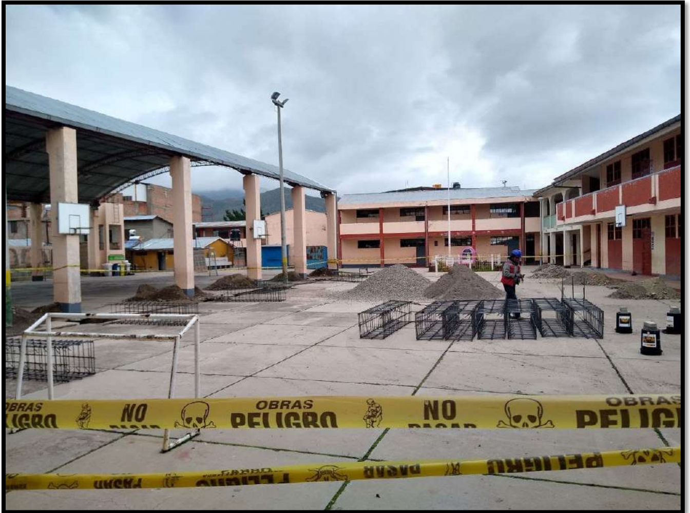
Figura 160. Colocación de columna metálica.
