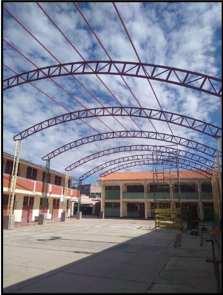
Figura 171. Colocación de arriostres.
