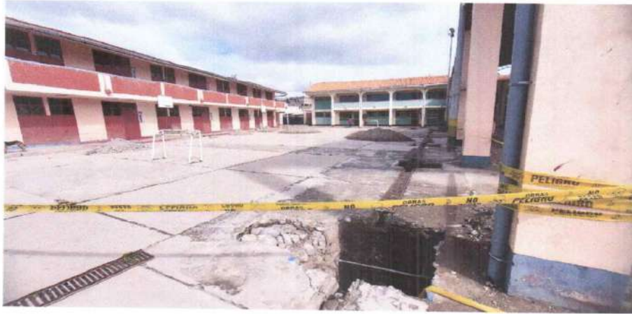
FOTOGRAFIA N° 01: . Imagen de la obra, GMT 09:13:23, miércoles 02 de marzo del 2022.
