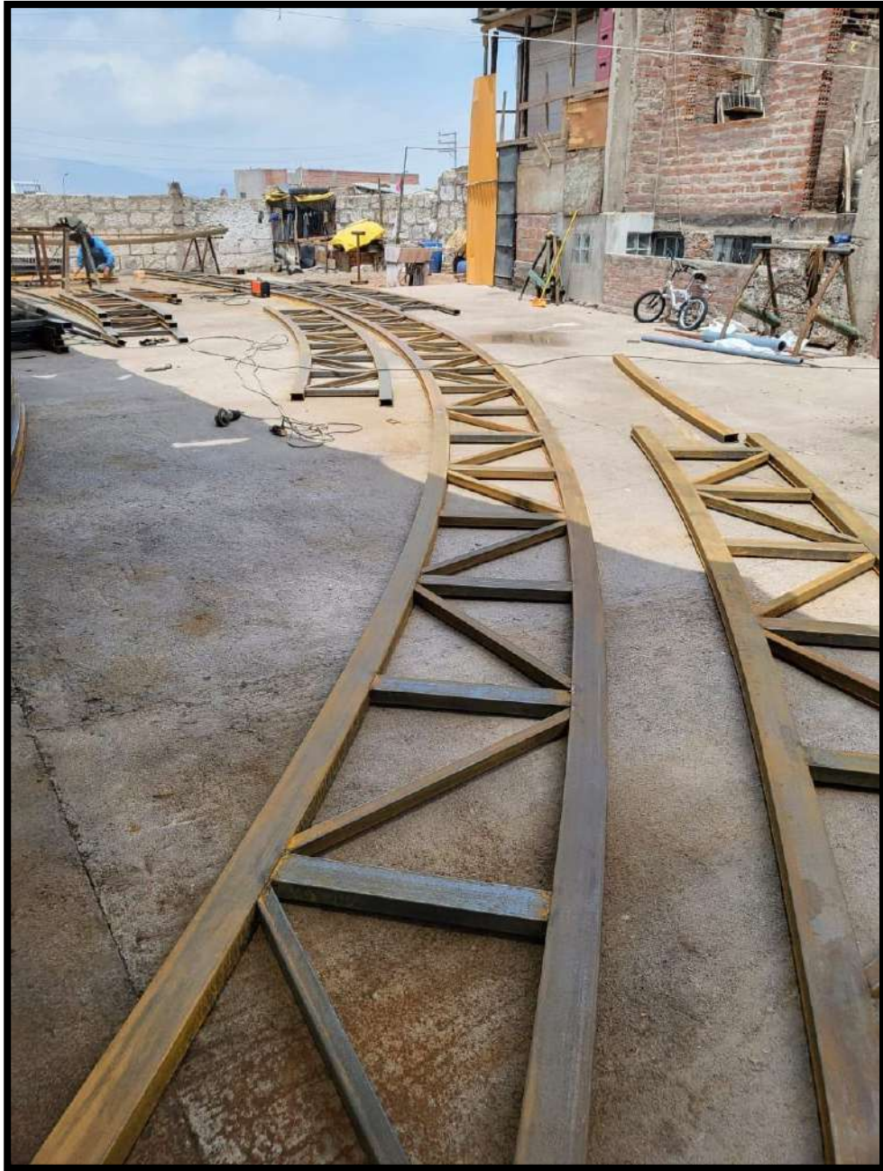
Figura 164. Vigas de estructura metálica.
