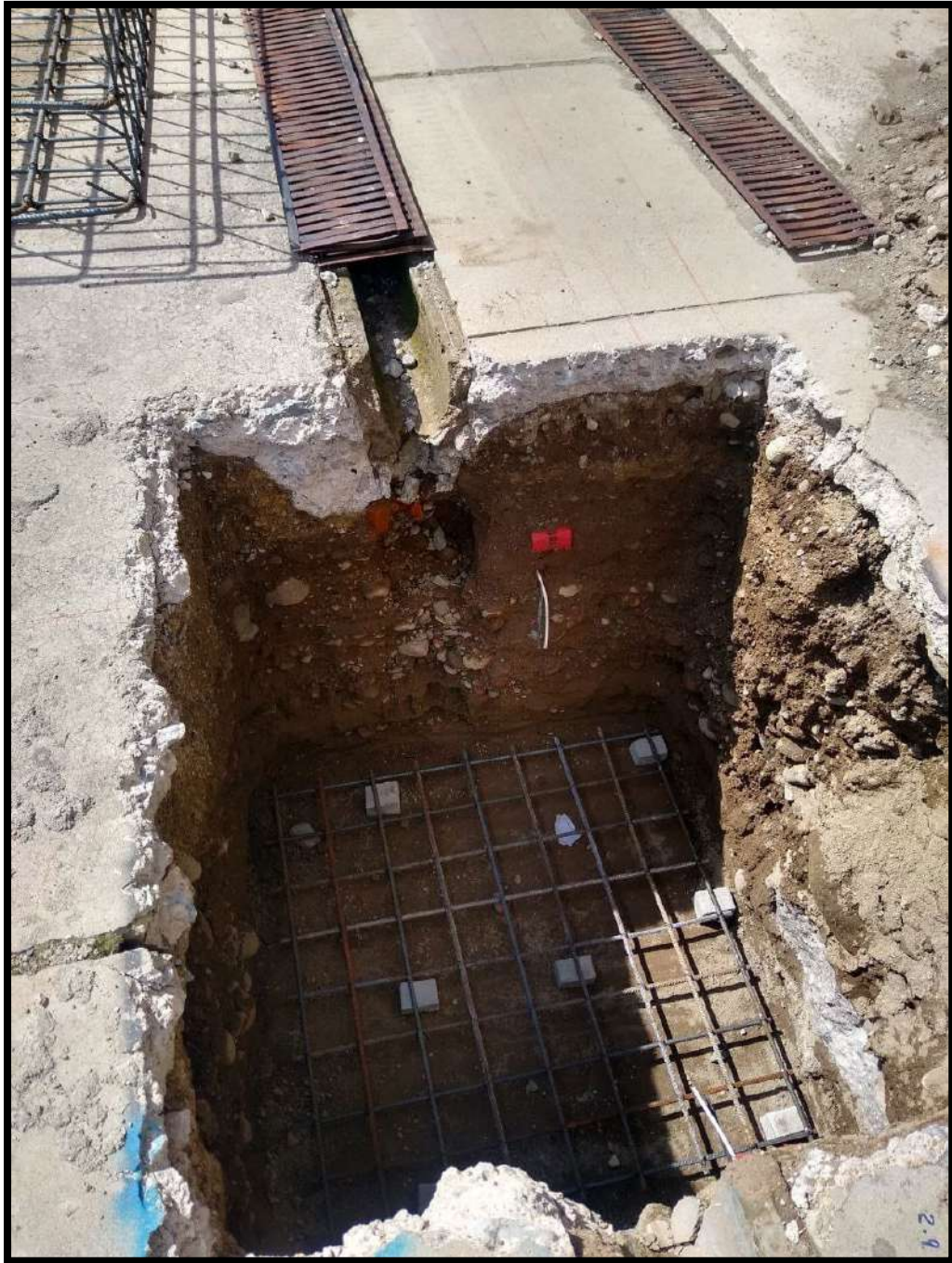
Figura 159. Zapata Aislada - Visita a Obra.
