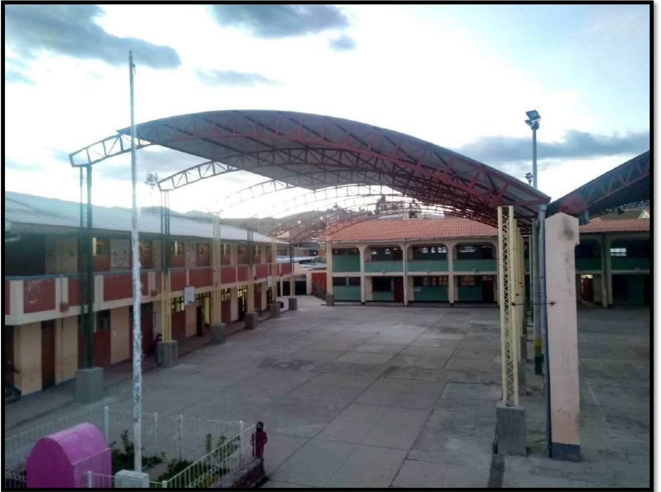
Figura 172. Colocación de planchas metálicas.
