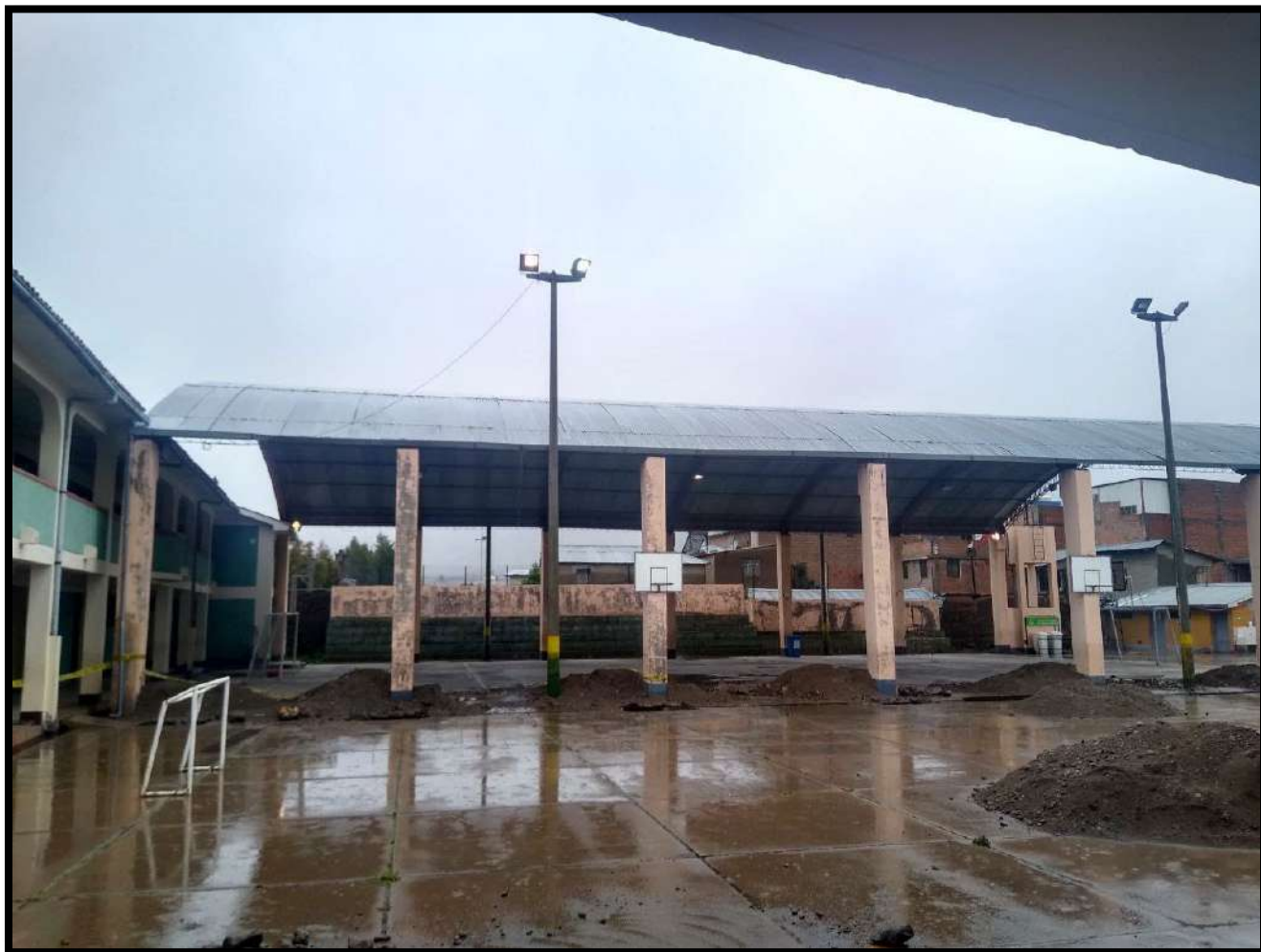
Figura 158, Visita a Obra Precipitaciones Pluviales.
