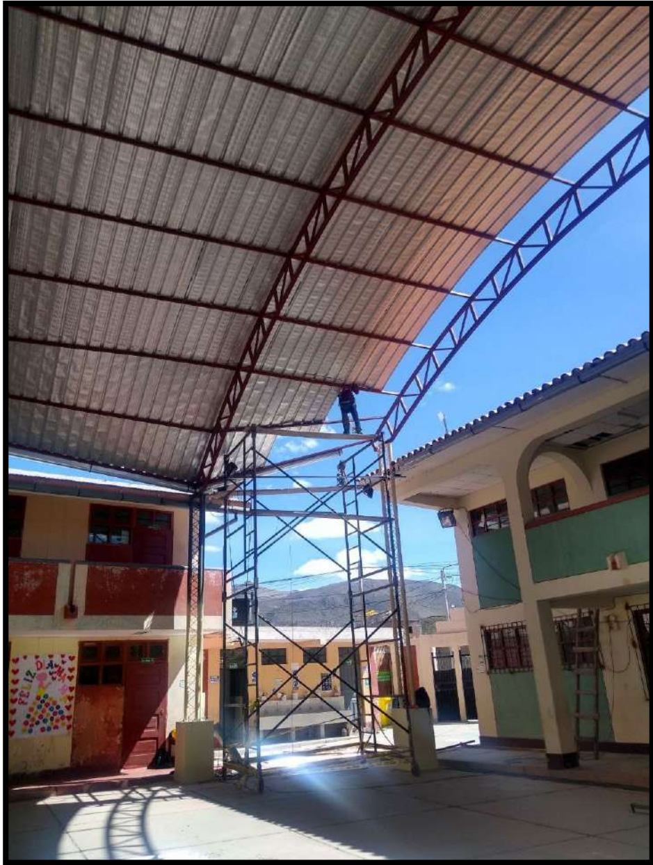
Figura 173. Colocación de planchas metálicas.
