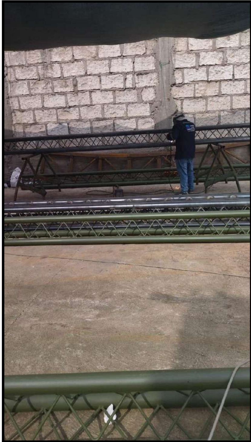
Figura 165. Armado de columnas metálicas.
