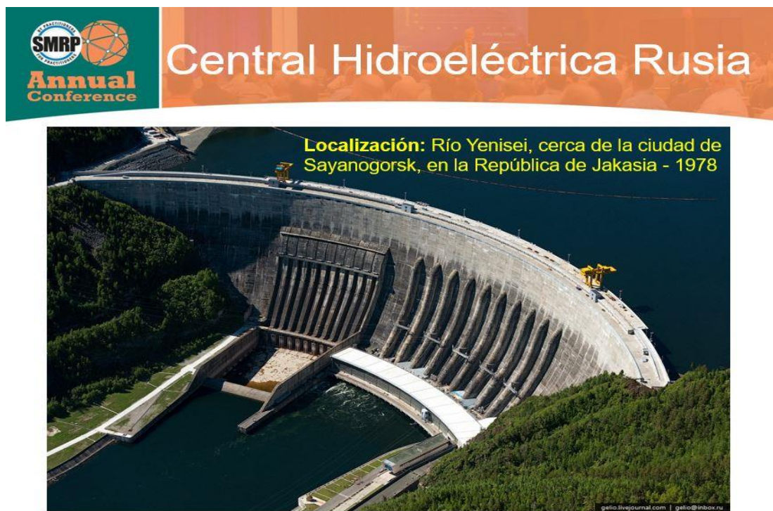
Figura 04: Central Hidroeléctrica Rusia-1978 6.4 GW de Potencia. Fuente: Connecting Asset Management, SMRP Annual Conference, 2014
