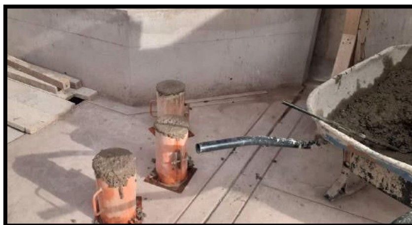
Imagen 42. Elaboración de briquetas para pruebas de compresión del concreto.
