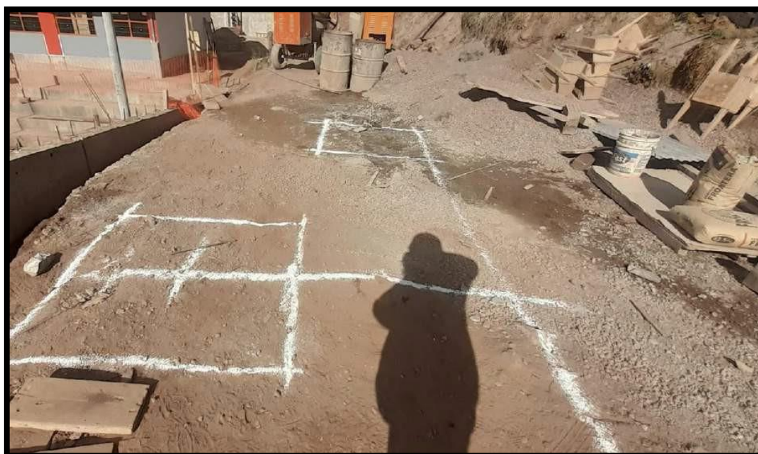
Imagen 33. Verificación del trazo de estructuras previo inicio de actividades.
