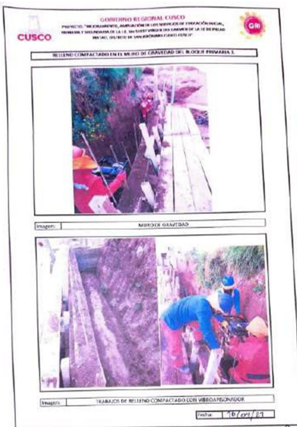
Imagen 55 panel fotográfico del proceso de compactación en MG -01
