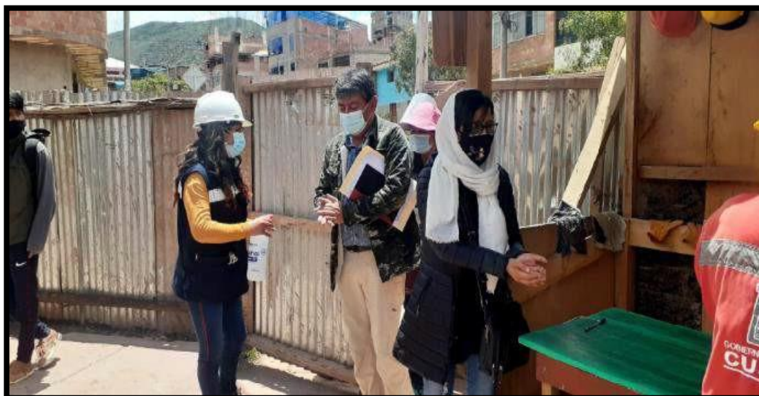
Imagen 32. Verificación de cumplimiento de protocolos sanitarios y de seguridad en obra.
