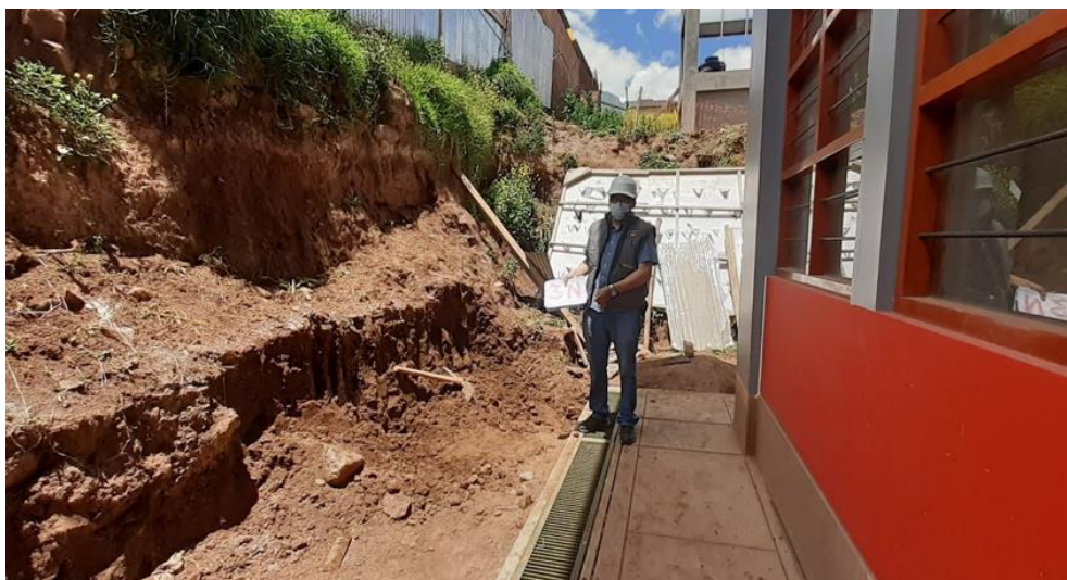
Imagen 70 Supervisor en área del muro de Gravedad 01
