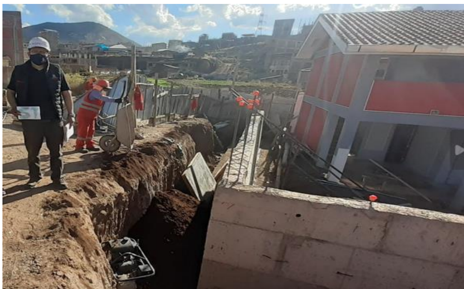
Imagen 84 Vaciado y encofrado del MC-03
