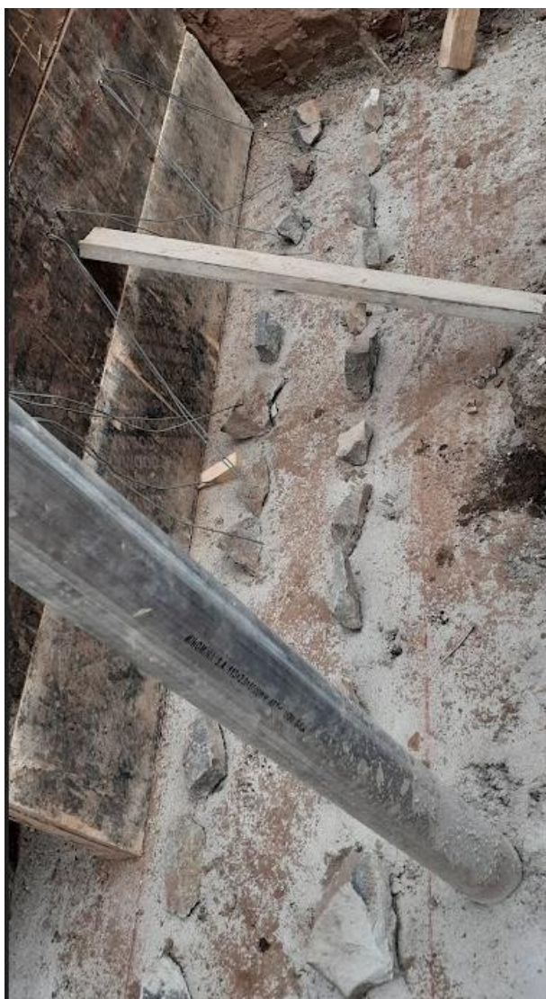
Imagen 71 Zapatas y encofrado de pantalla en Muro de Gravedad 01
