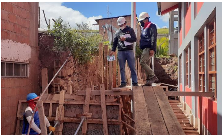
Imagen 73 Excavaciones en MC- 06
