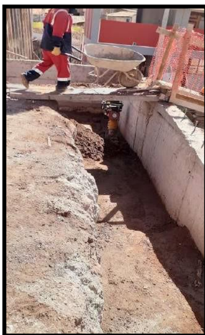
Imagen 36. Relleno compactado con material propio en muros de contención.
