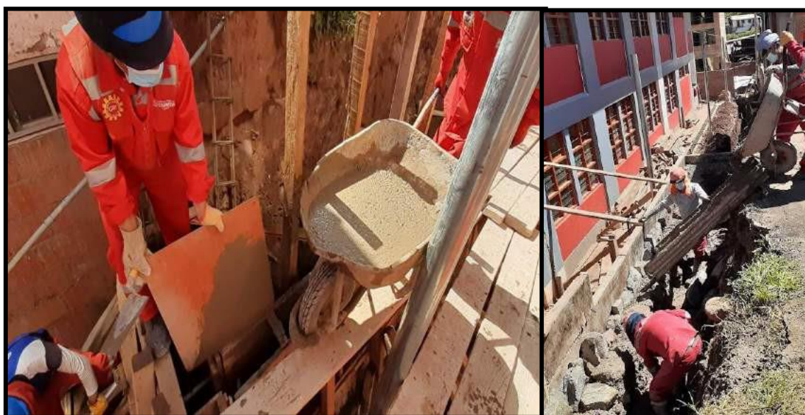
Imagen 39. Vaciado de concreto f'c=210 \text{ kg/cm}^2 elaborado en obra.
