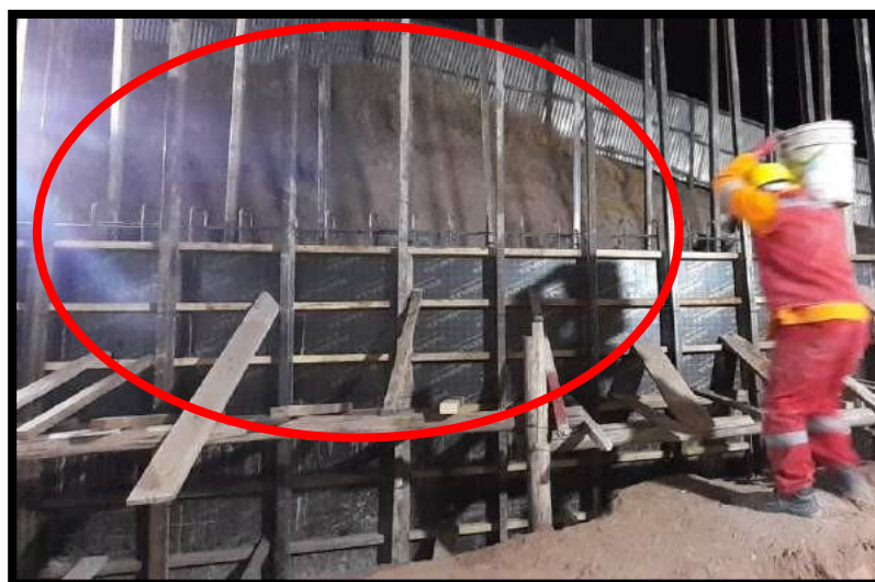
Imagen 38. Verificación de vaciado de concreto y encofrado de estructuras.
