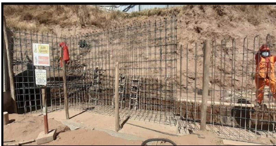
Imagen 37. Verificación de armado de acero según planos del proyecto.
