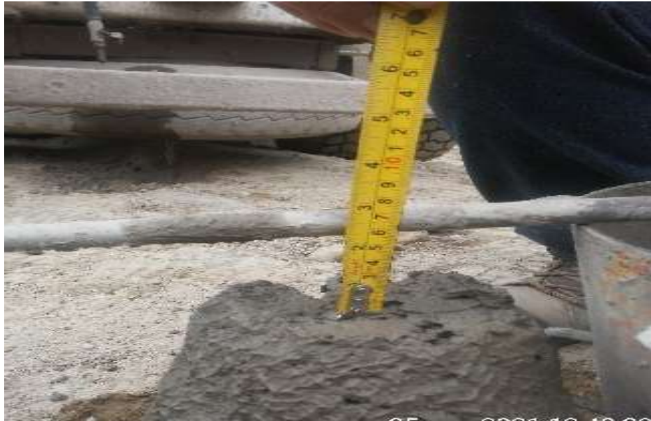
Figura 43. Verificación de consistencia de concreto.
