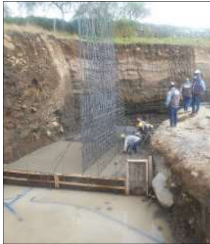
Figura 69. Uso de motobombas
