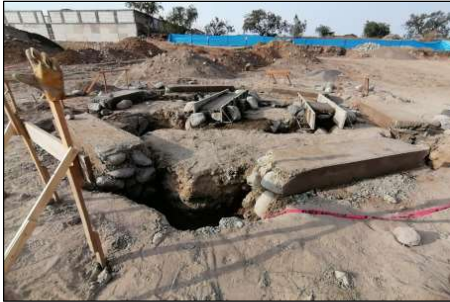
Figura 29. Cimientos corridos en módulos de áreas abiertas.
