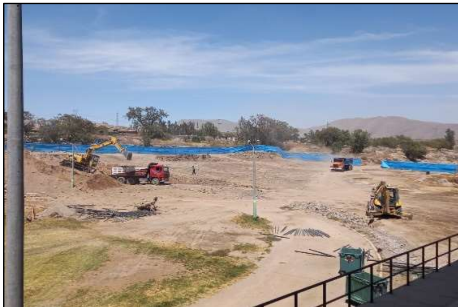
Figura 23. Eliminación de material excedente.
