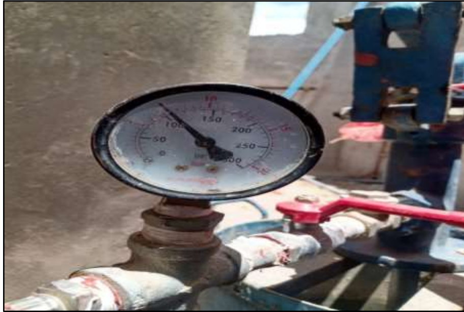
Figura 65. Control de pruebas hidráulicas.
