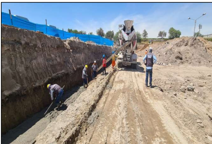
Figura 36. Control de vaciado de solado.
