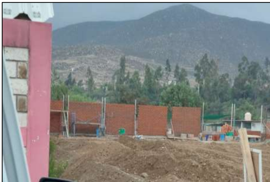
Figura 60. Muro de tabiquería.
