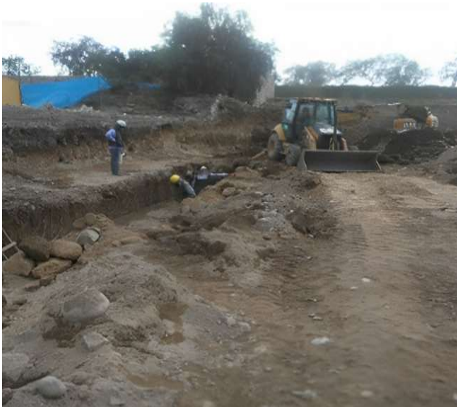
Figura 31. Sobrecimientos en módulos de áreas abiertas.
