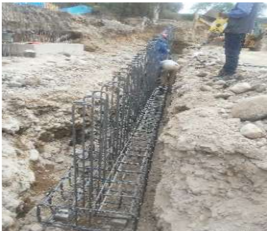
Figura 42. Verificación de espaciamiento de aceros.
