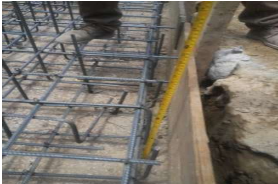
Figura 41. Verificación de altura de zapatas.
