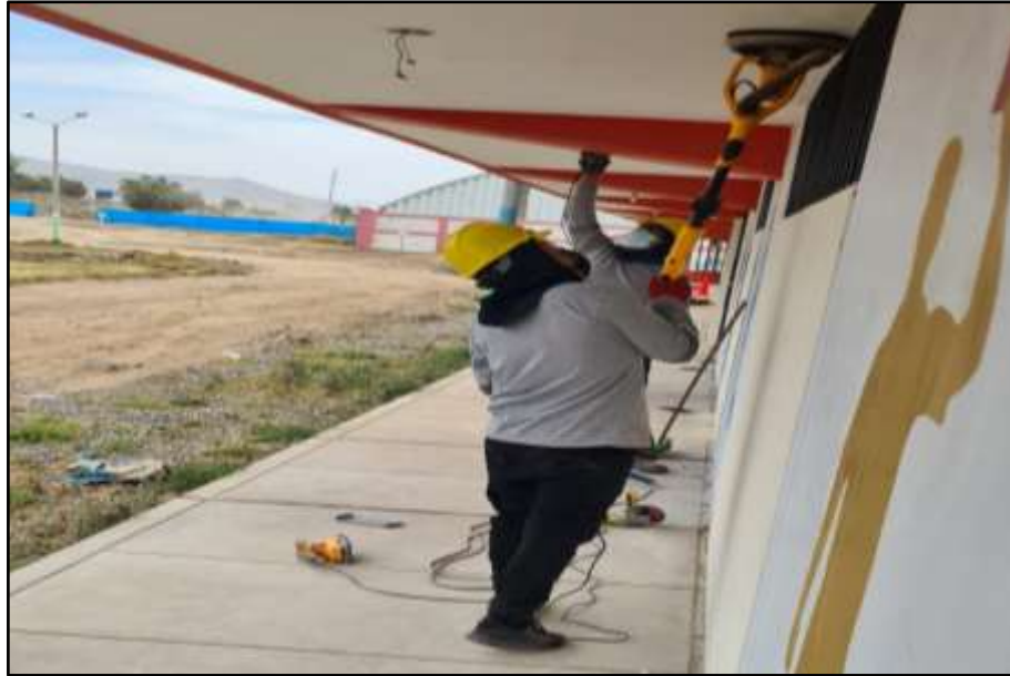
Figura 17. Escarificación de muros de tribuna.
