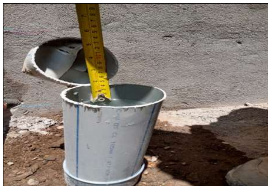
Figura 64. Verificación de instalaciones sanitarias.
