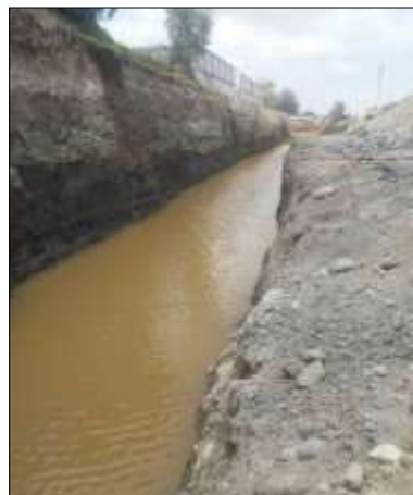
Figura 68. Empozamiento de agua
