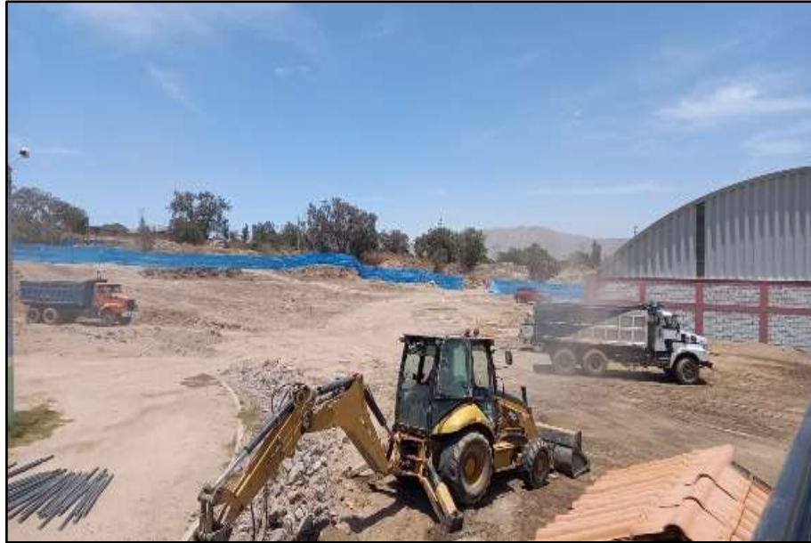
Figura 13. Demolición de sardineles con maquinaria.
