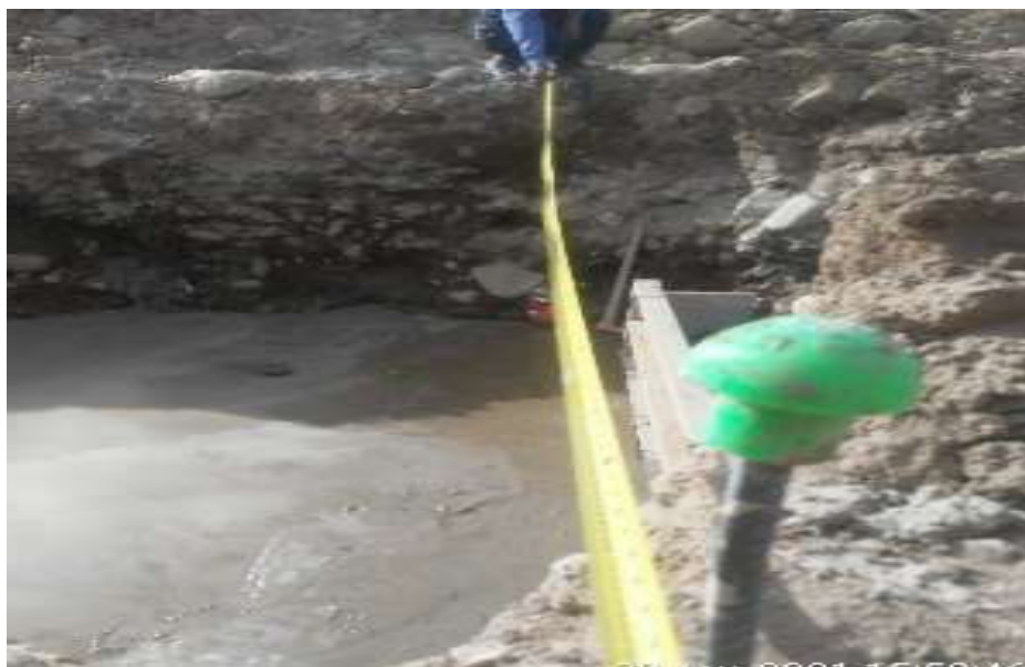
Figura 26. Verificación de medidas de excavación de zapatas.
