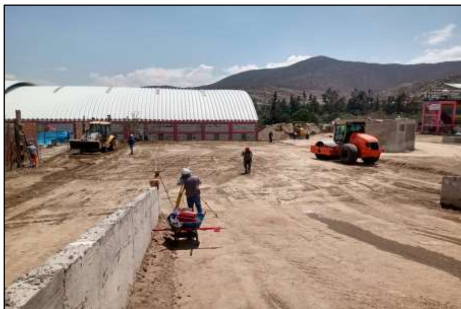
Figura 56. Compactación y nivelación de áreas abiertas.
