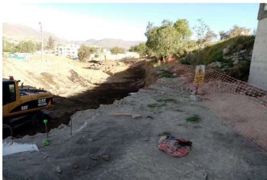
Figura 20. Excavación de cimientos y zapatas.
