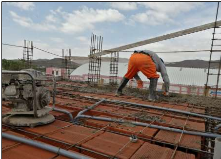
Figura 53. Concreto en losas aligeradas.
