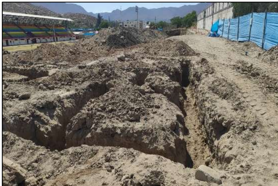
Figura 27. Verificación de compatibilidad en cimientos.
