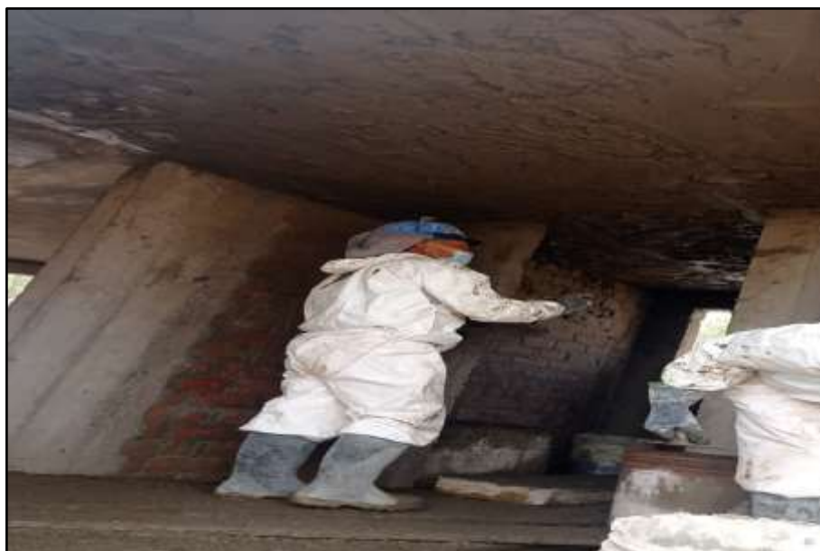
Figura 58. Verificación de tarrajeo en cielorraso.
