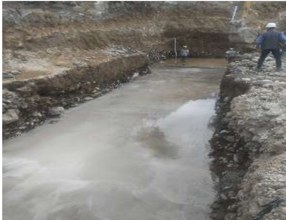
Figura 47. Verificación de vaciado de concreto en zapatas corridas.
