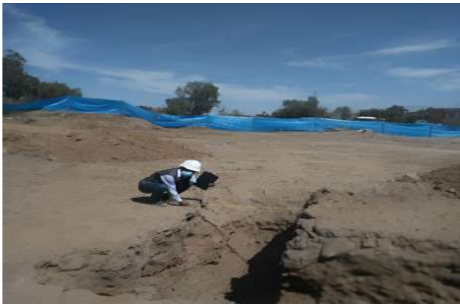
Figura 25. Verificación de medidas de excavación.
