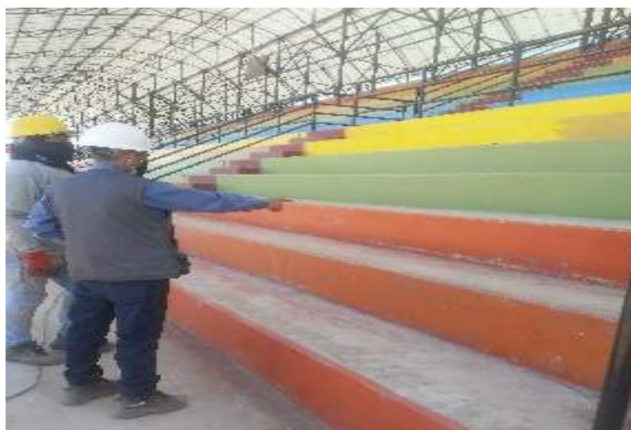
Figura 16. Escarificación gradas de tribuna.
