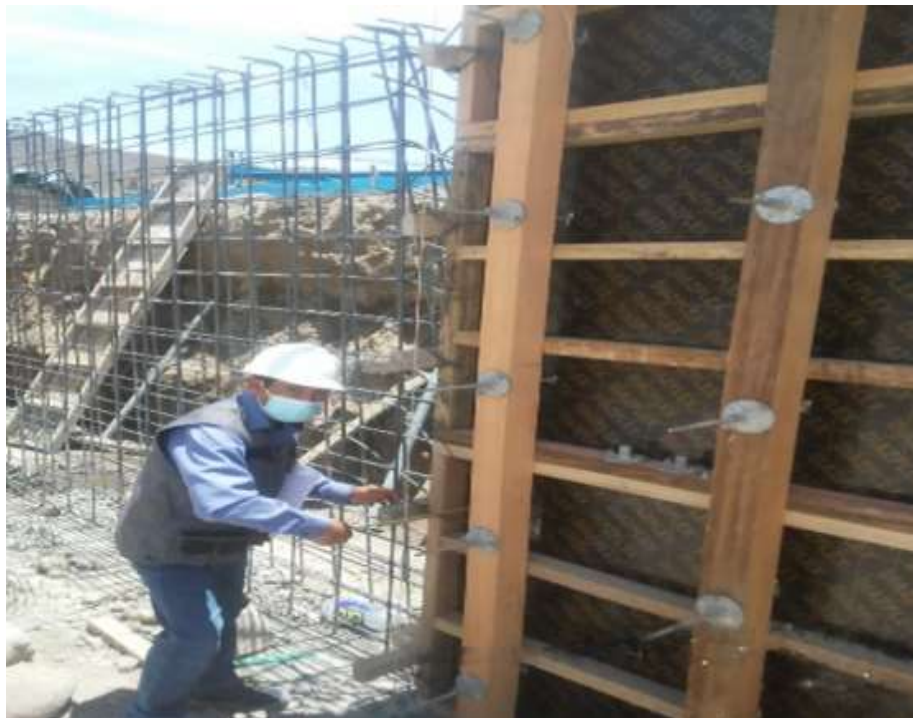
Figura 44. Verificación de nivelación en encofrados.
