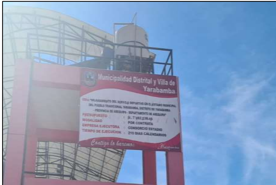
Figura 3. Cartel de la obra.
