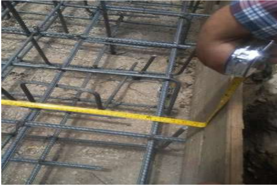
Figura 39. Control de recubrimiento en zapatas.
