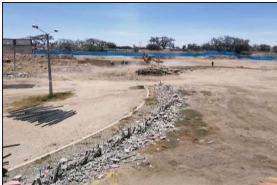
Figura 12. Demolición de sardineles.
