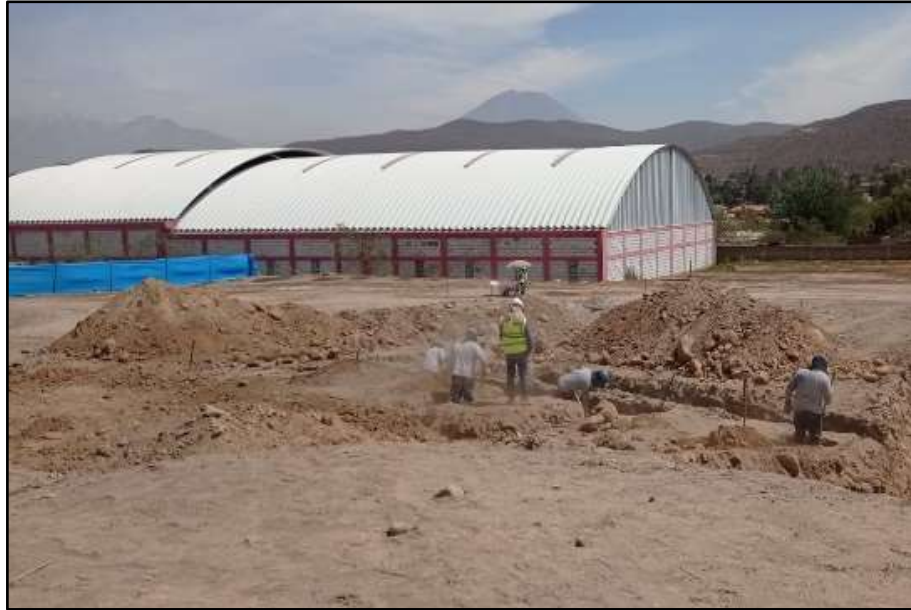
Figura 21. Excavación de cimientos y zapatas.
