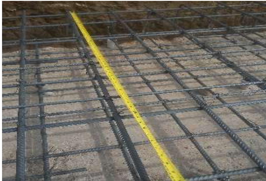
Figura 38. Control de espaciado de varillas en zapatas.
