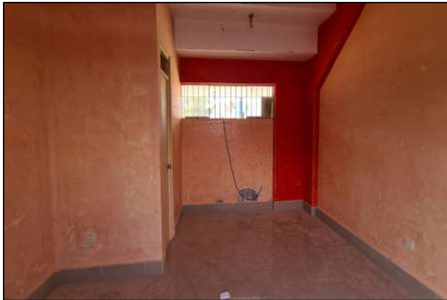
Figura 18. Escarificación de muros interiores.
