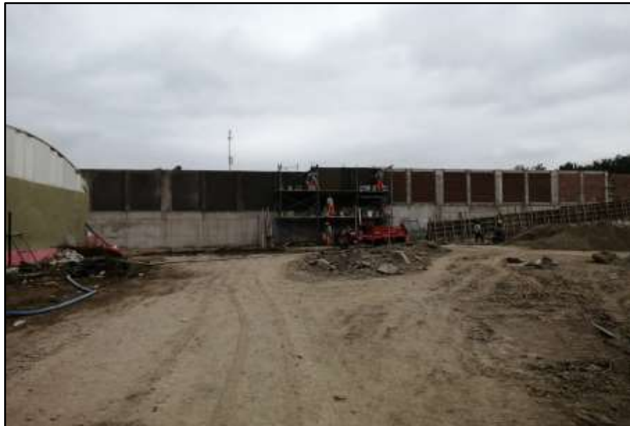
Figura 62. Tarrajeo en cerco perimétrico.
