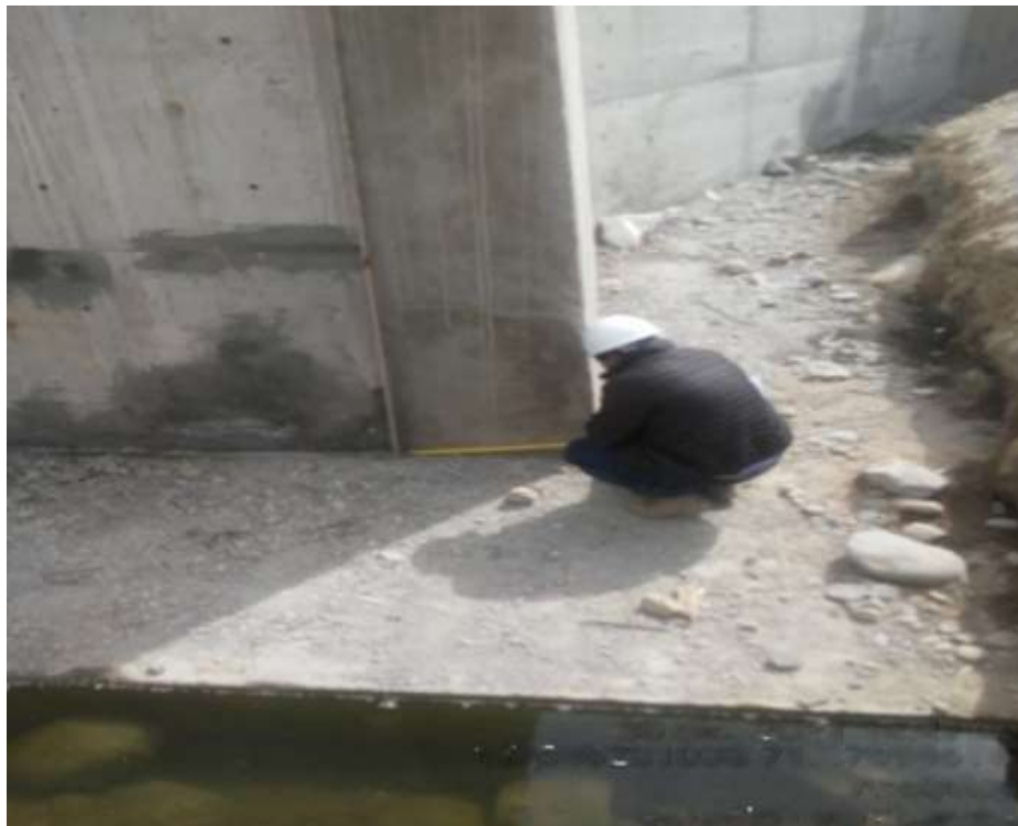
Figura 50. Verificación de dimensiones en columnas
