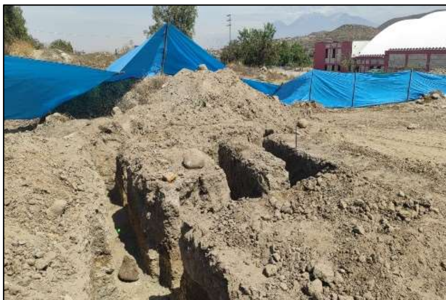
Figura 28. Verificación de compatibilidad en cimientos.
