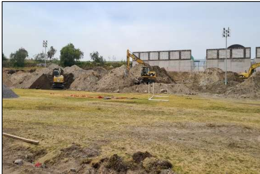
Figura 22. Control de excavación masiva.
