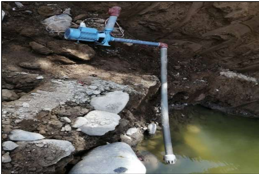
Figura 34. Bombeo de agua.
