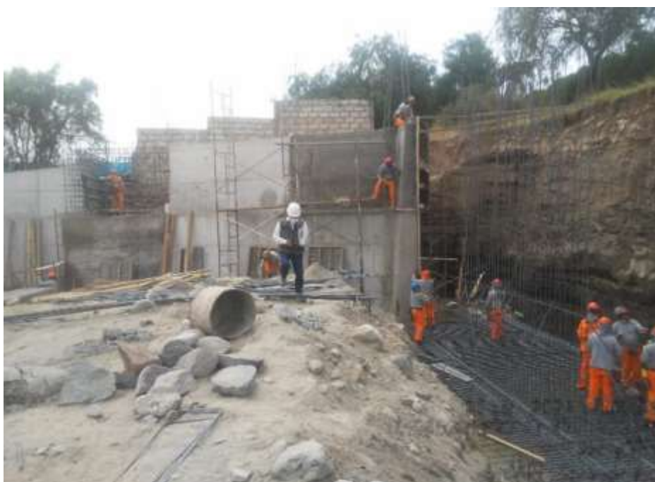
Figura 46. Verificación de desencofrado
