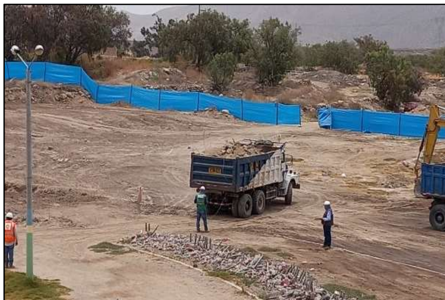
Figura 19. Eliminación de material excedente.
