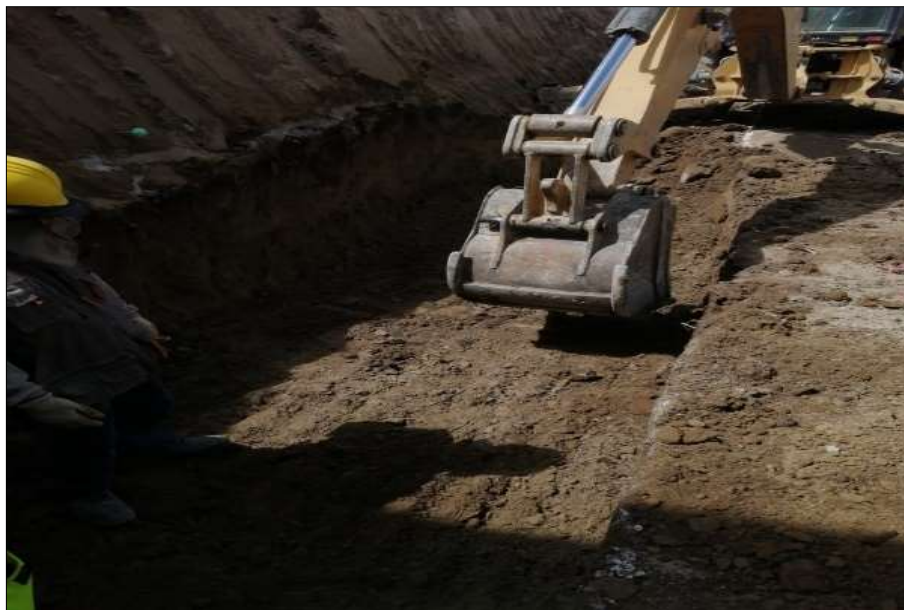
Figura 35. Nivelación de zapatas.
