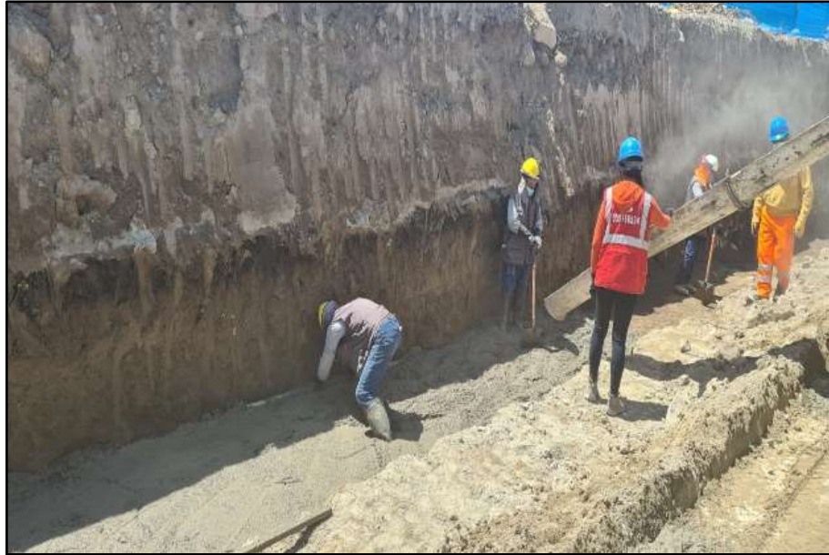
Figura 37. Control de vaciado de solado.
