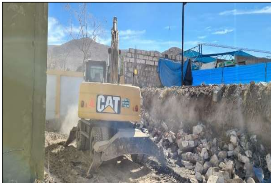
Figura 14. Demolición de muros con maquinaria.
