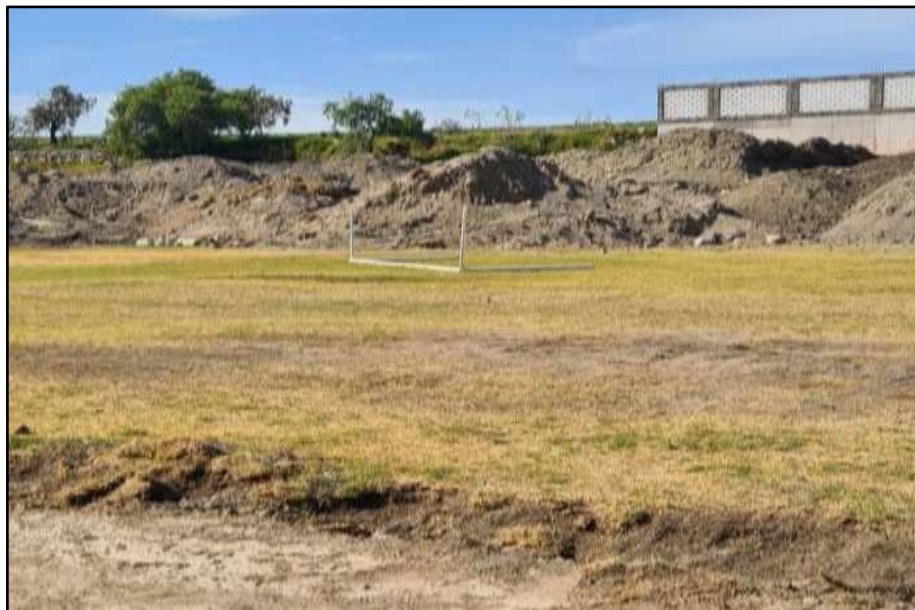
Figura 15. Desmontaje de arco.
