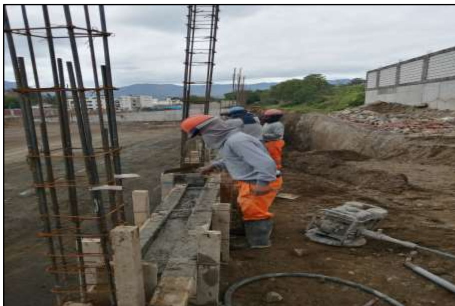
Figura 52. Encofrado y vaciado de concreto.
