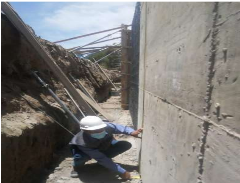
Figura 45. Verificación de nivel muro de contención.
