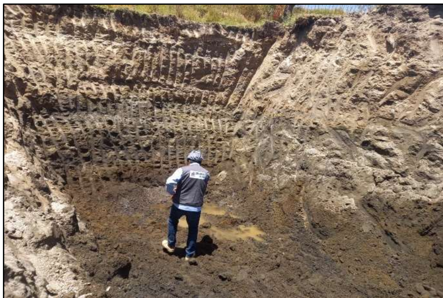
Figura 32. Verificación de capa freática.
