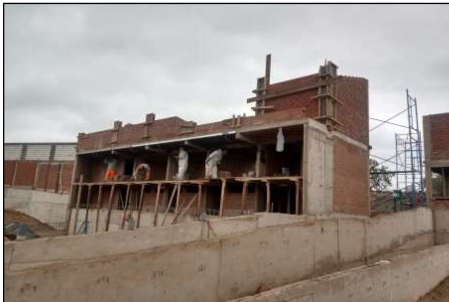
Figura 57. Trabajos de obras civiles.
