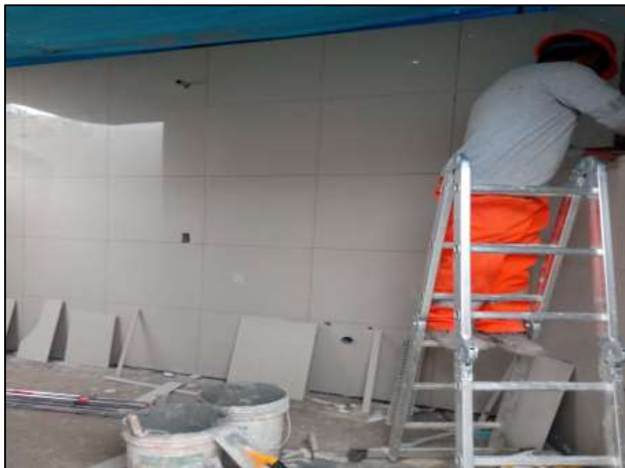
Figura 59. Trabajos de enchape.
