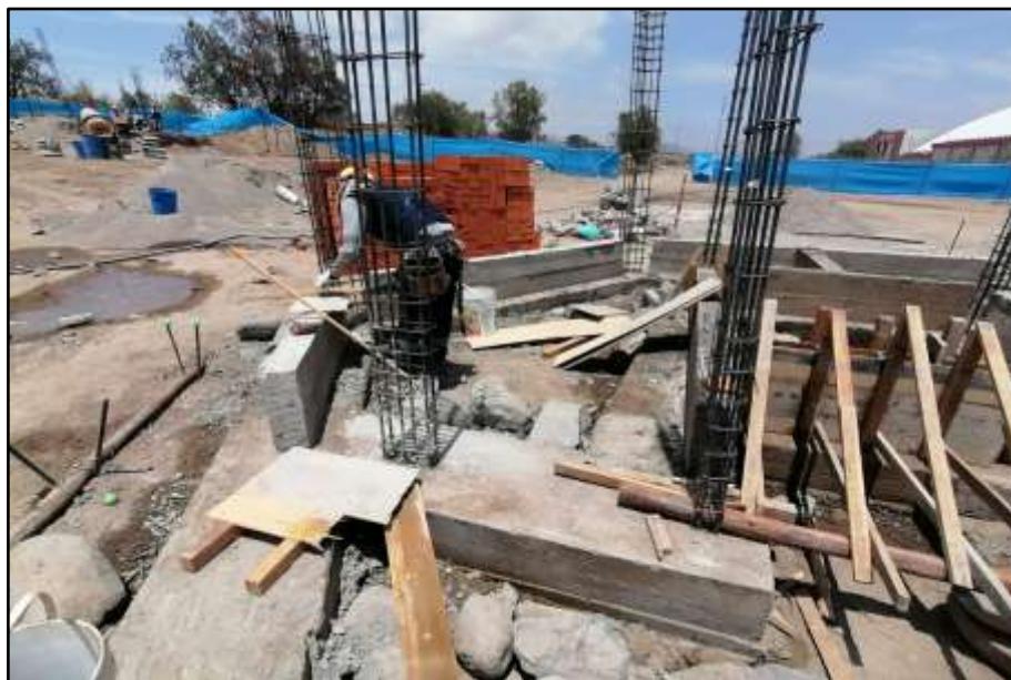
Figura 30. Sobrecimientos en módulos de áreas abiertas.
