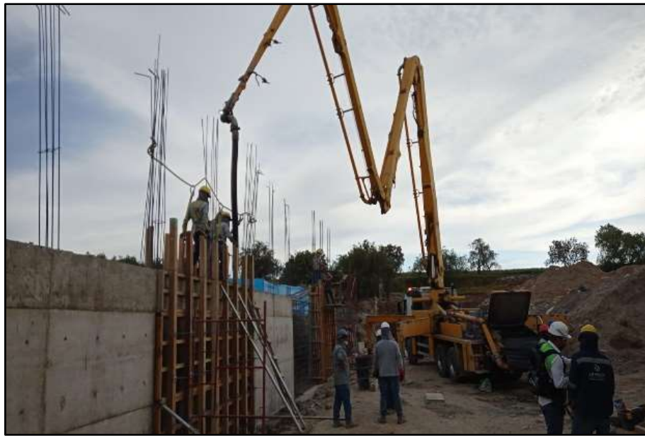
Figura 49. Control de vaciado de concreto.
