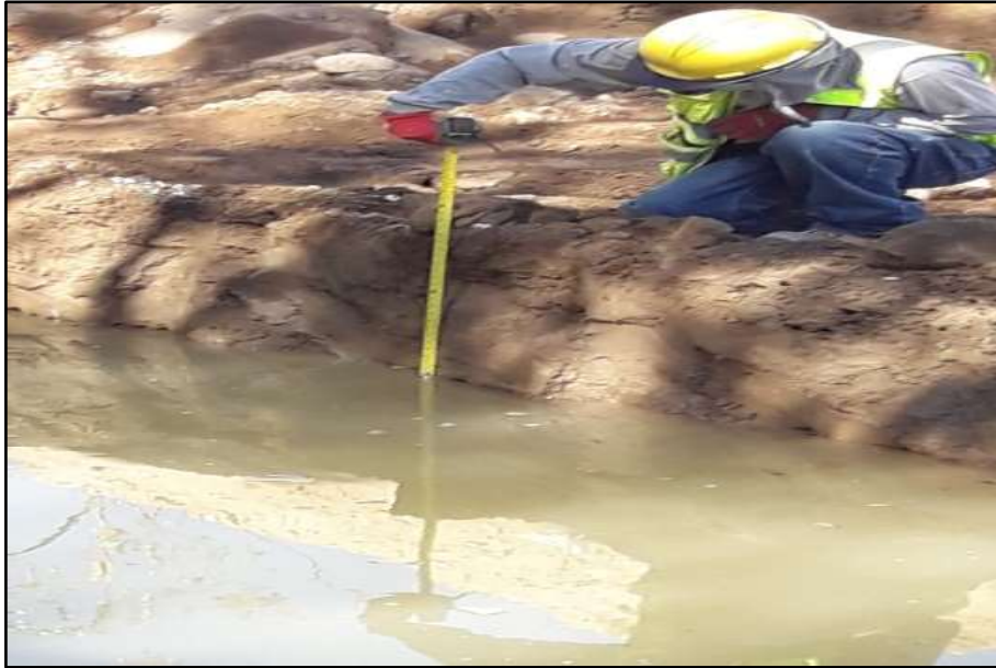
Figura 33. Verificación de Medición de filtración.
