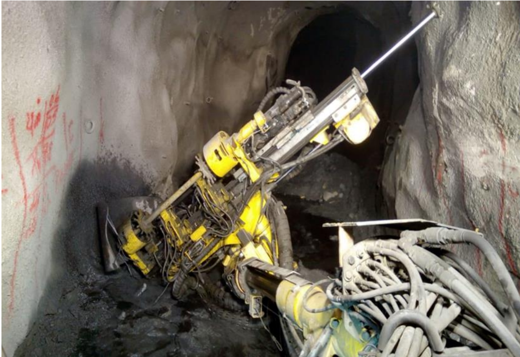
Control de posicionamiento en equipos de perforación, chimenea slot.
