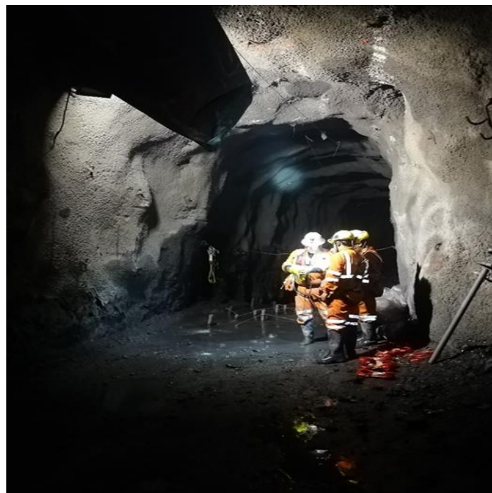
Figura 8. Inspección del IPERC de la chimenea slot, veta Split 658 Tomada del área de Planeamiento
