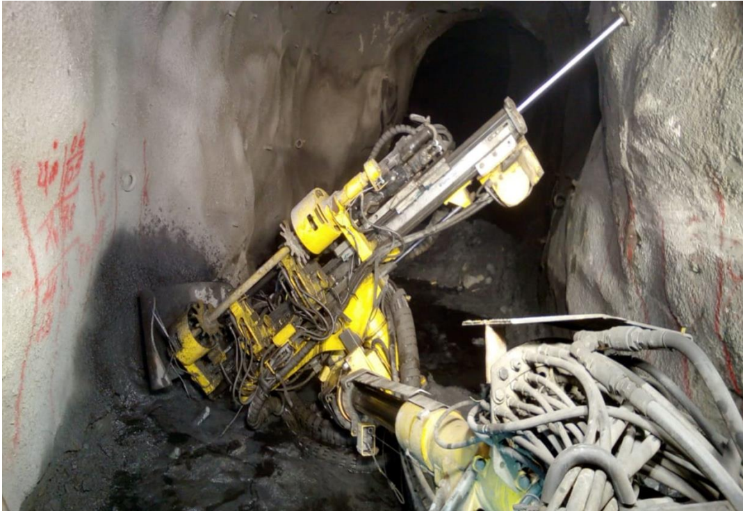
Figura 12. Control de posicionamiento en equipos de perforación, chimenea slot
