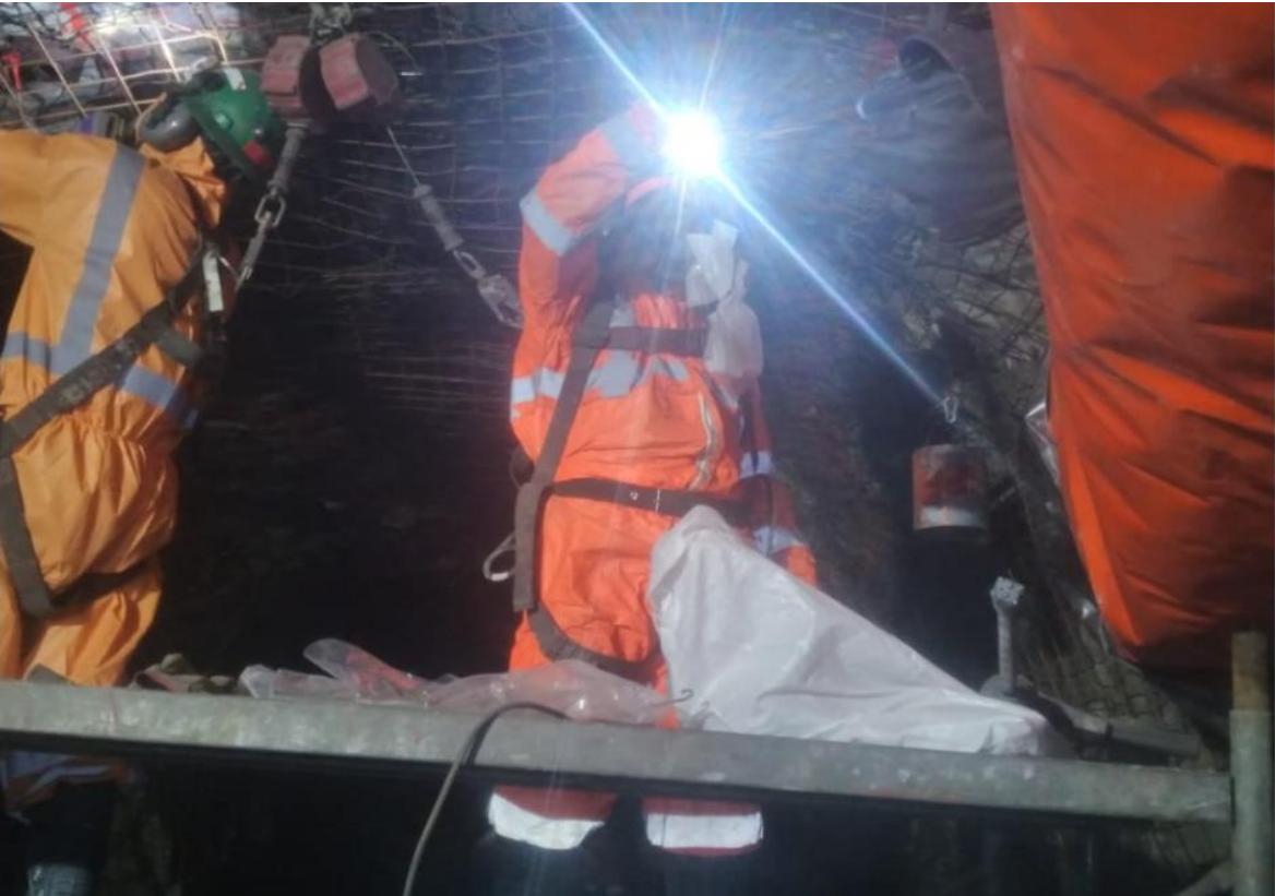
Anexo 13. Punto de Anclaje desde una malla electrosoldada
