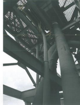
Foto 06, Tubería de descarga montaje al 100%.
