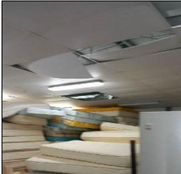
Figura 26: Vista de Estado de Baldosas de falso cielo raso
