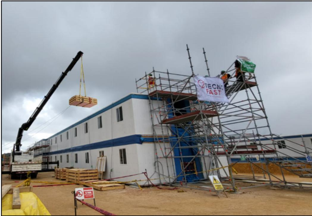
*Figura 83: Montaje de Casetones para Techo*
