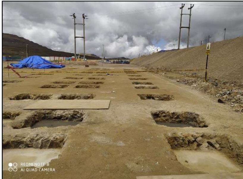
*Figura 65: Excavación de Fundaciones tipo dados*
