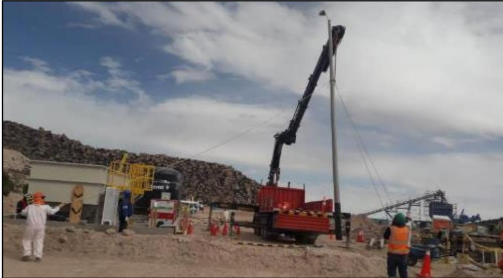
*Figura 98: Ejecución de Alumbrado exterior con postes.*
