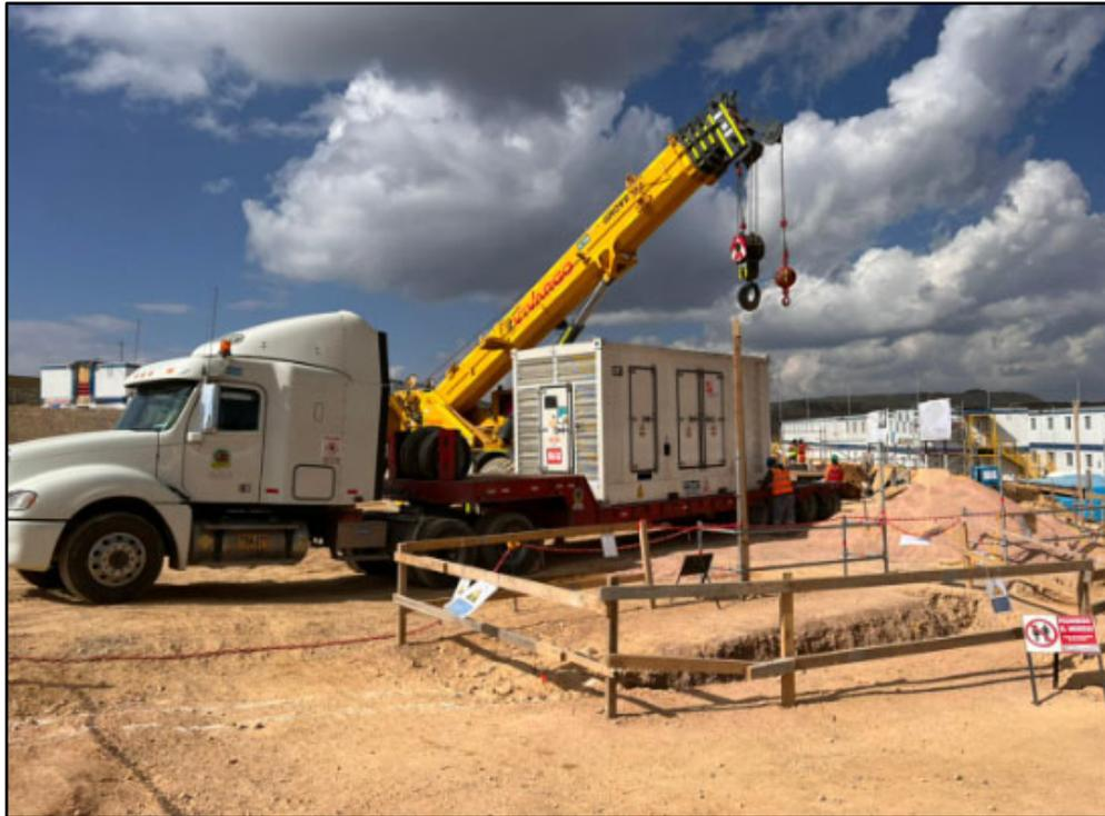
*Figura 97: Montaje de Grupos electrógenos*
