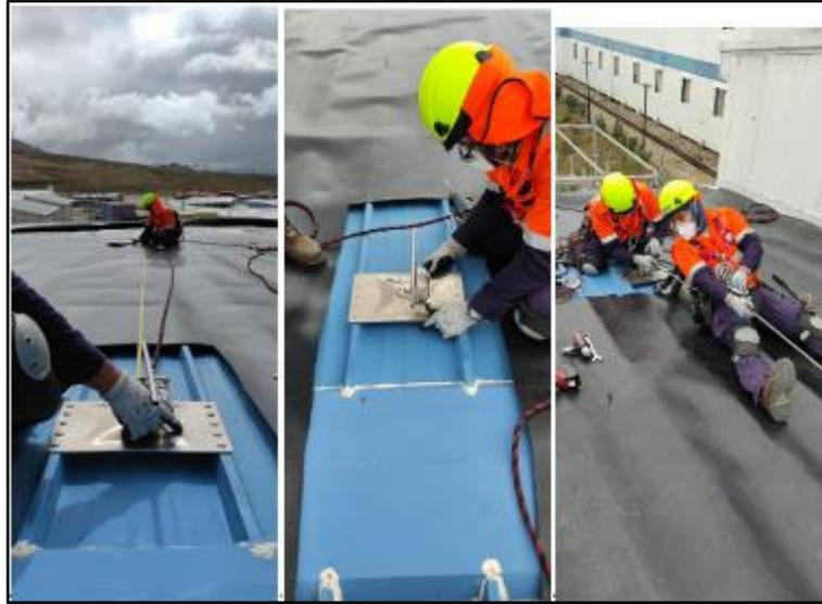
*Figura 92: Culminación de línea de vida Permanente Cocina CNC*
