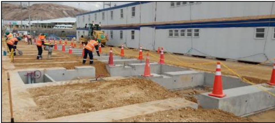
*Figura 71: relleno y compactación para montaje de módulos*
