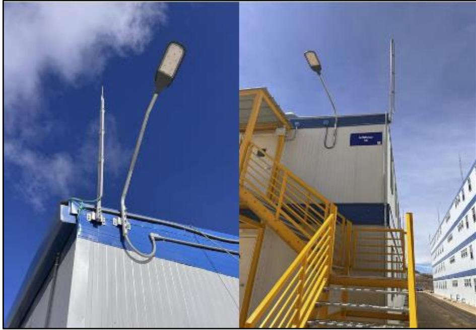
*Figura 100: Pararrayos y Luminarias Exteriores*
