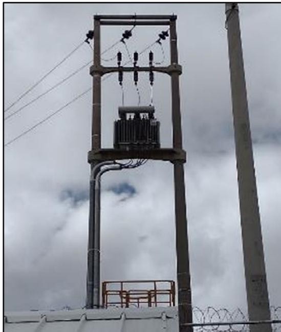
*Figura 48: Transformador con potencia solo para alimentar la planta PTAP*
