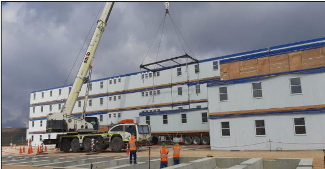
*Figura 74: Montaje de módulos 3° y 4° Nivel*
