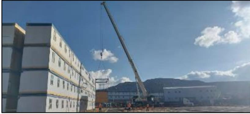
*Figura 75: Cierre de montaje de Módulos Edificio Workers*
