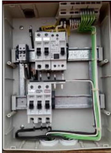
*Figura 57: Tablero de distribución típico (Edificio Supervisor)*
