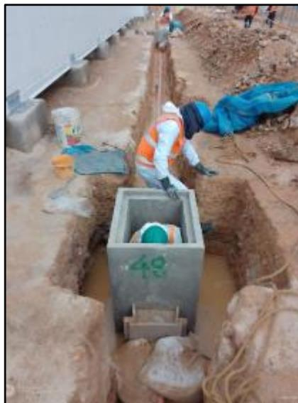
*Figura 93: Colocación de Cajas de registro*
