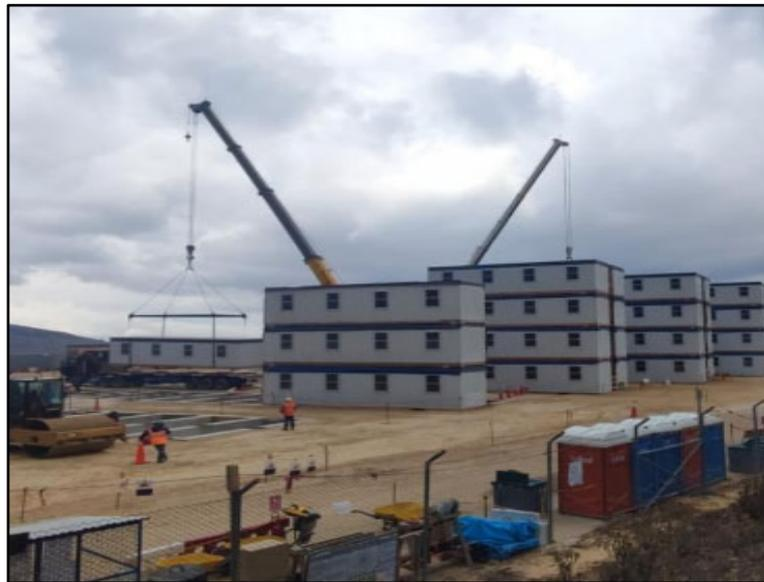
*Figura 76: Izaje en paralelo Con grúa de 90 y 130 ton*
