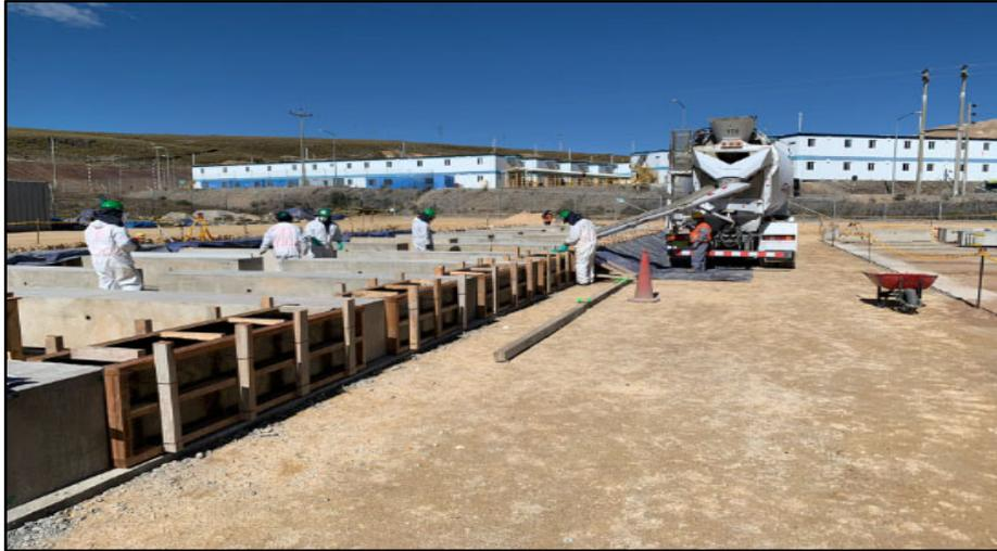
*Figura 70: Vaciado de conexiones en vigas de fundación*
