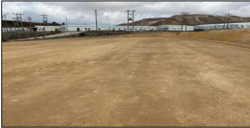
*Figura 10: Plataforma para W4 y W5 con pendiente longitudinal Excesiva*
