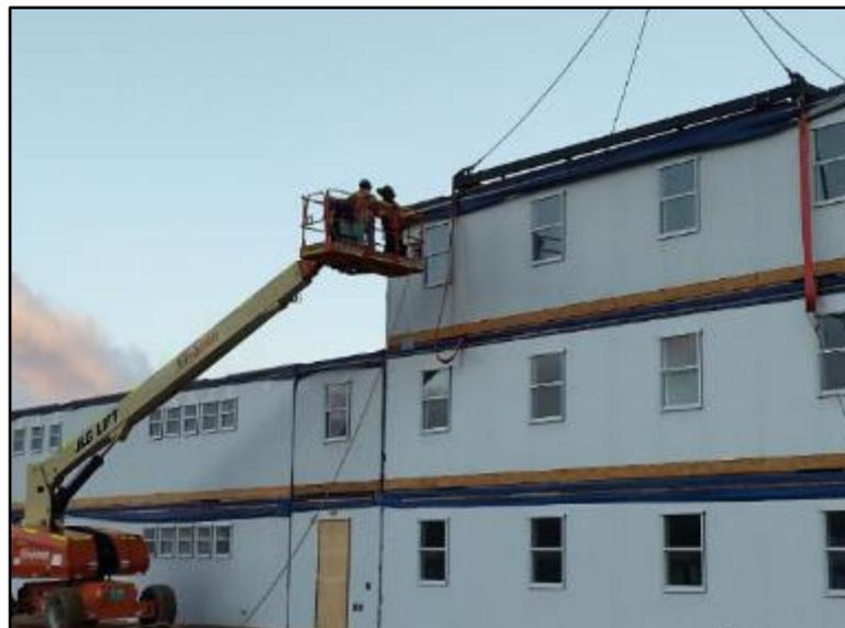
*Figura 77: Des estrobo de Eslingas para cierre de maniobra*
