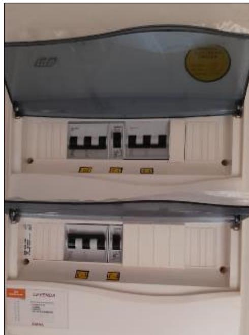
*Figura 56: Tablero de distribución típico TD-3,9,14 y 20*
