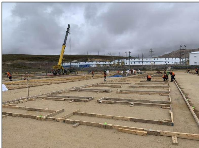
*Figura 66: Vaciado de Solados en Fundación tipo Vigas*
