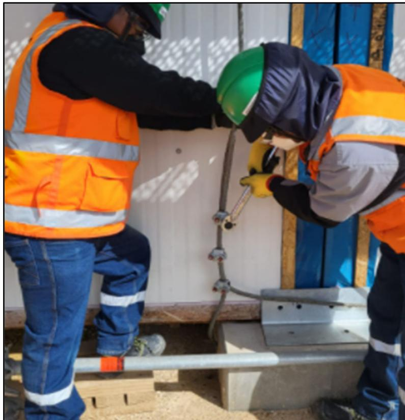
*Figura 82: Aseguramiento y colocación de línea de Vida*
