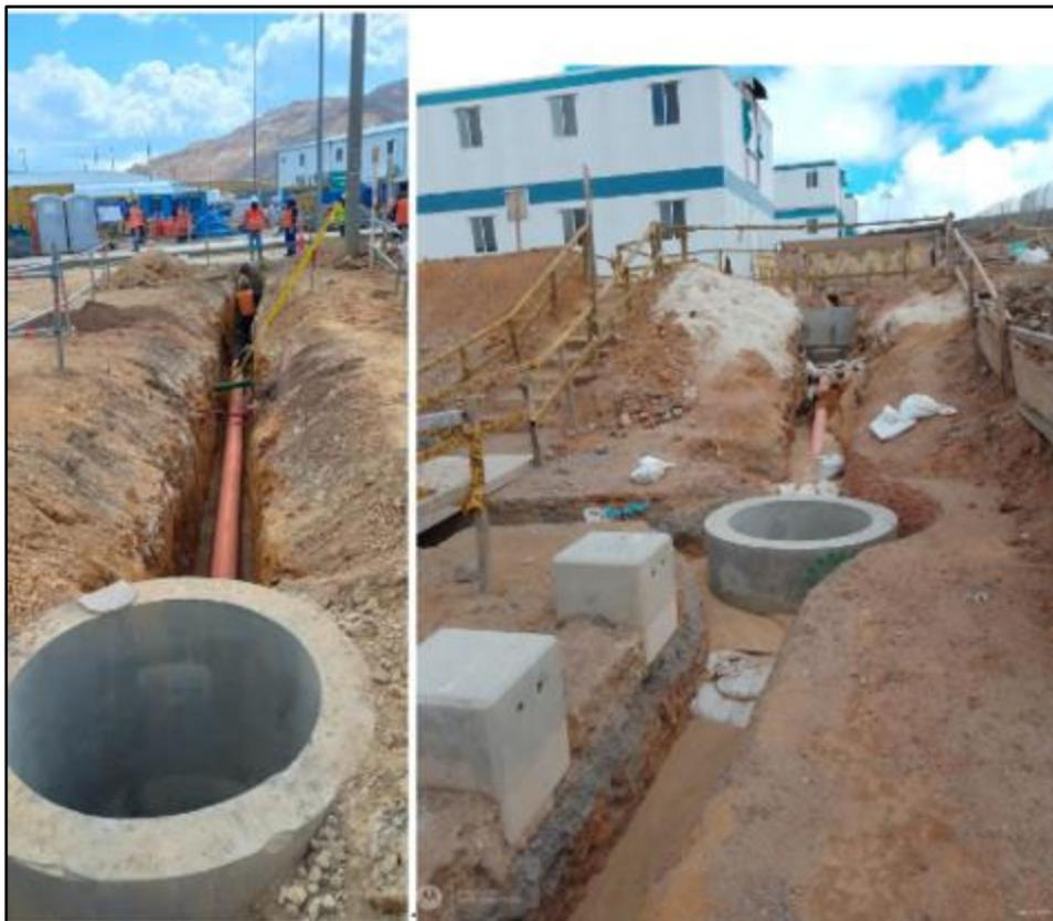
*Figura 94: Instalación de Red de desagüe exteriores*
