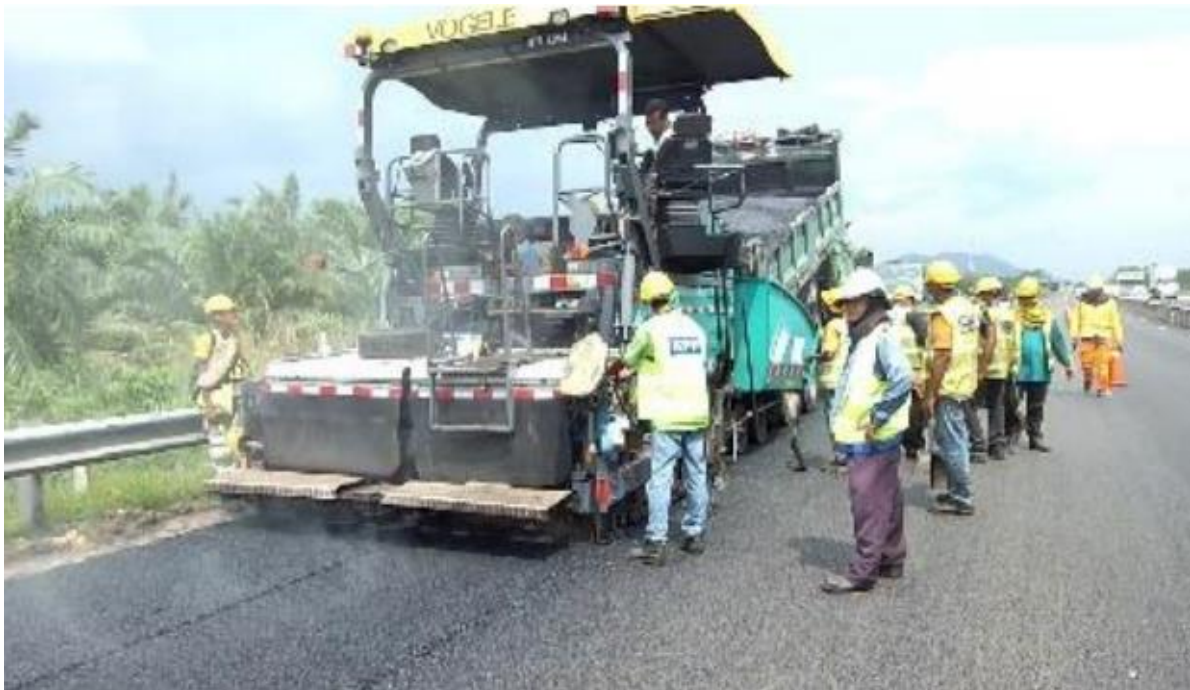
Figura 1: Ejecución de vía a base de mezcla asfáltica drenante
