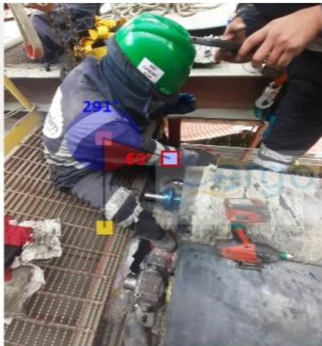
Personal de la empresa ESFAMIM MINERALS alimentador intermedio N.º 2, 3, 4, 5 y 6-CH
