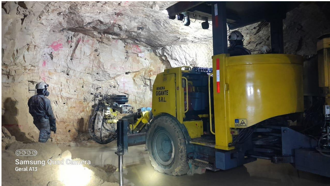
Perforación del frente del XC - 710
