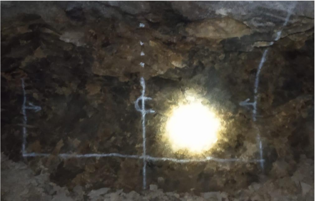
Marcado de frente por topografía
