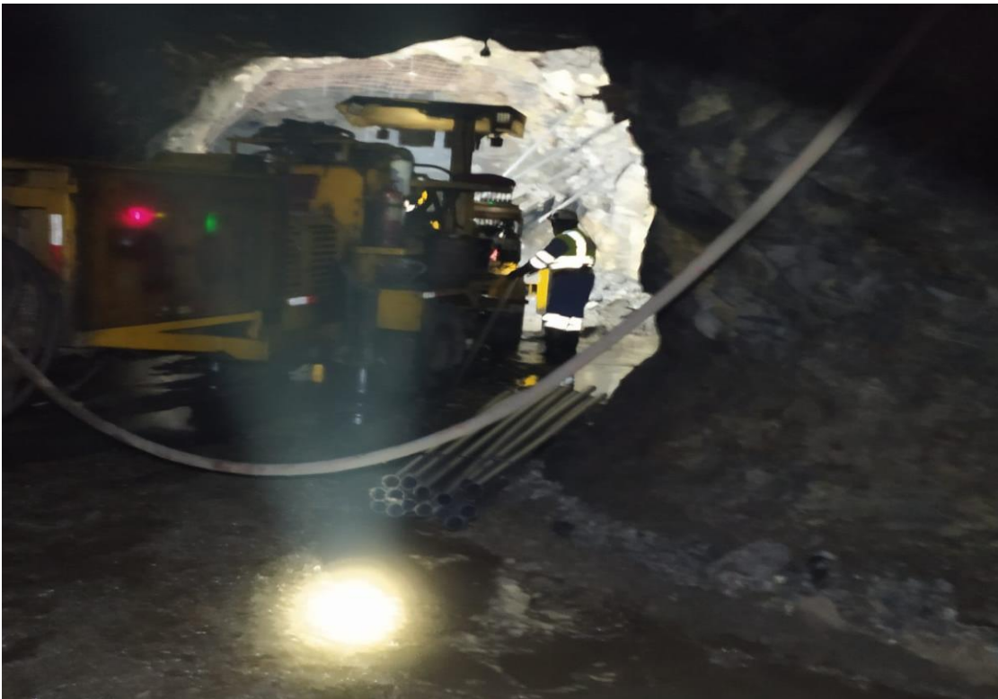
Posicionamiento del jumbo en frente de trabajo
