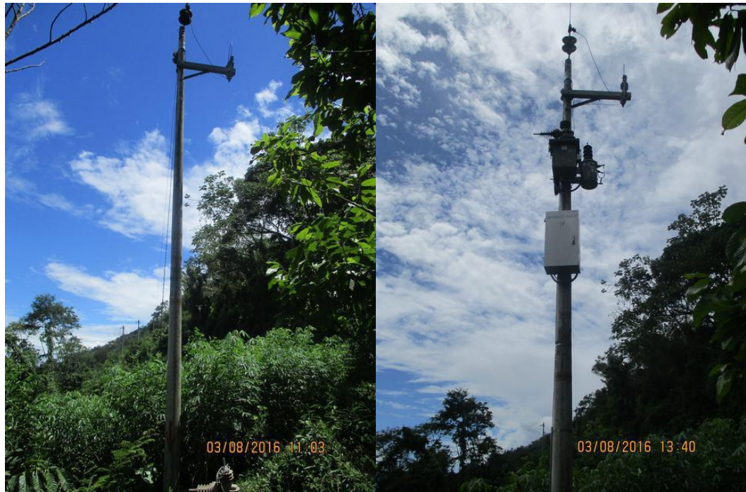
Figura 14. Comparativa antes y después de la instalación del reconector monofásico rec_002 alimentador A4029, subestación San Francisco, localidad de Monterrico
