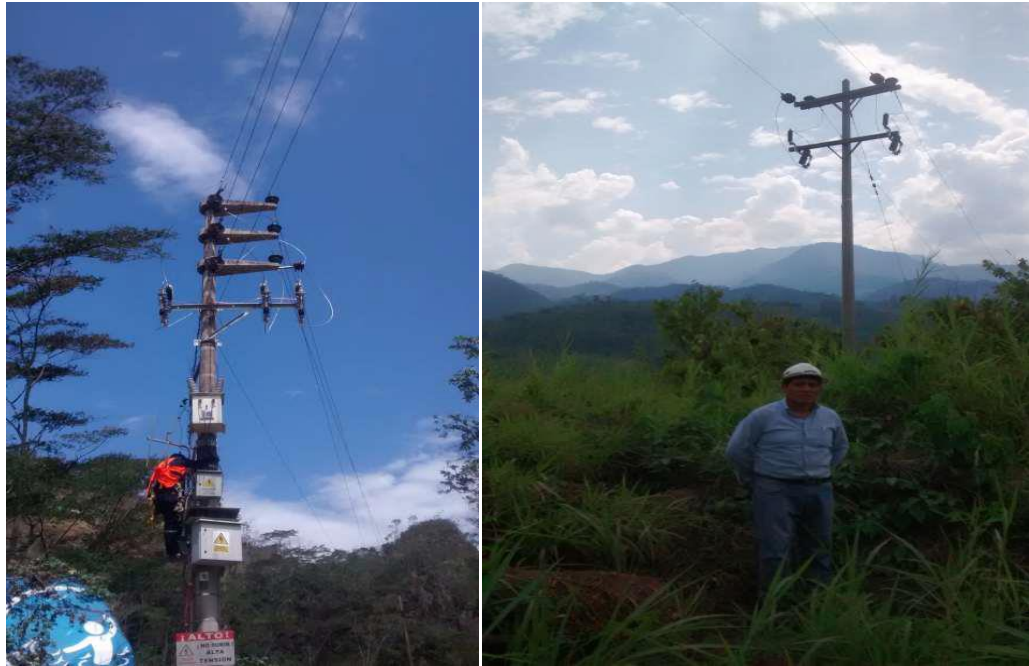
Figura 16. Comparativa antes y después de la instalación de seccionizador SECC-02 A4802
