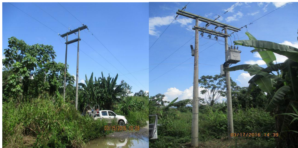
Figura 15. Comparativa antes y después del izado y presentación del reconector rec_004 alimentador A4027, subestación San Francisco, localidad de Mantaro
