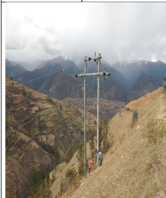
Montaje de seccionadores e indicadores de falla en derivación a Huaribamba
