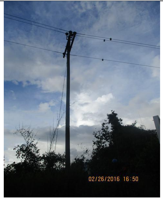
Instalación de indicadores de falla ind_003 en el alimentador A4030 servicio eléctrico San Francisco – localidad de Marintari
