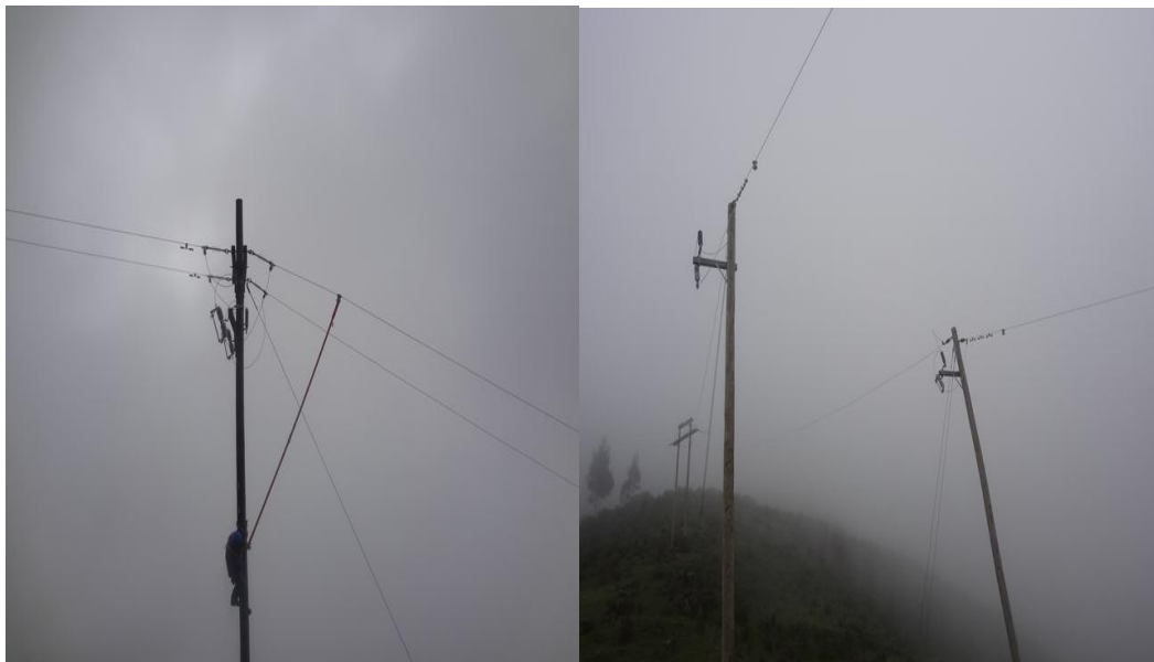
Figura 19. Comparativa antes y después del montaje de indicadores de falla alimentador A4006, subestación Ayacucho, localidad de Chungui
