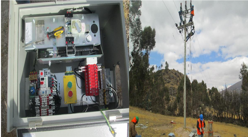
Figura 20. Antes y después de la instalación de seccionador bajo carga para maniobras de alimentadores A4113 Huancavelica norte y A4124 SER Rumichaca
