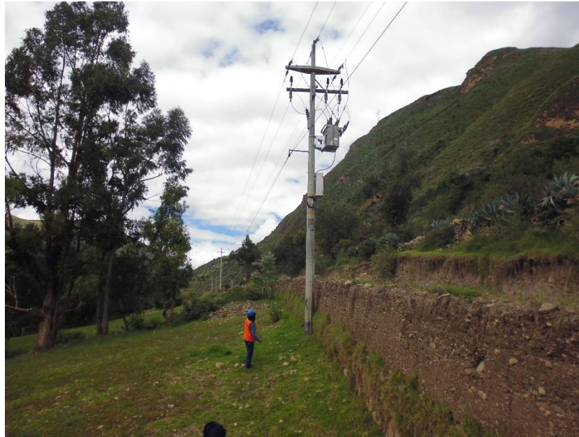
Figura 9. Diseño topológico de la estructura 15 del recloser trifásico Schneider instalado en Quinbalate a inmediaciones de Lircay
