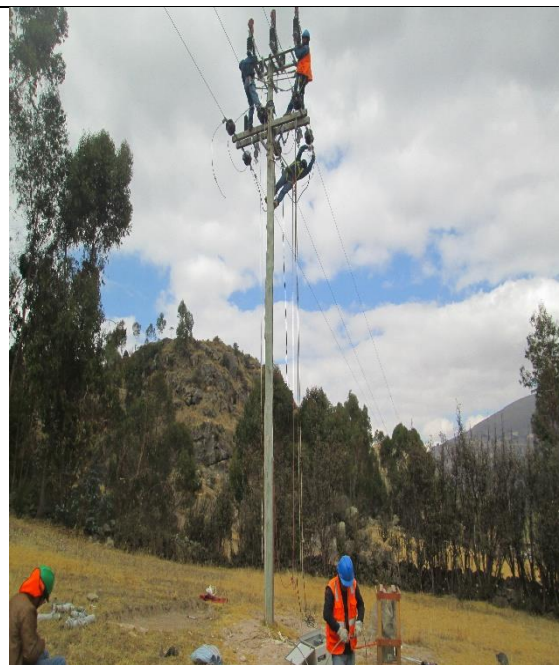
Montaje de seccionador bajo carga para maniobras de alimentadores A4113 Huancavelica norte y A4124 SER Rumichaca.
