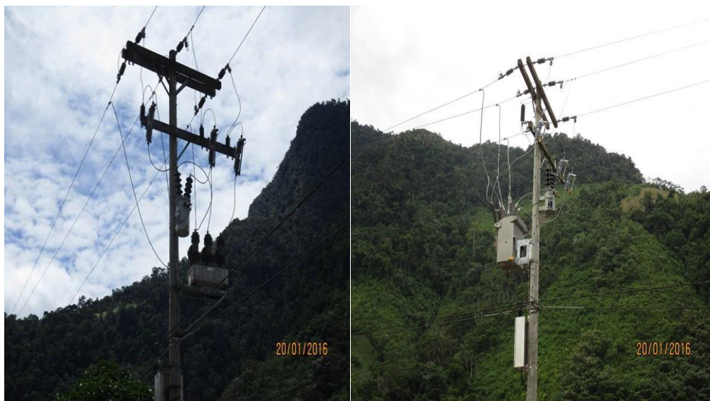
Figura 17. Comparativa antes y después de la instalación de pararrayos y seccionadores cut-out instalados en el centro poblado de Las Palmas
