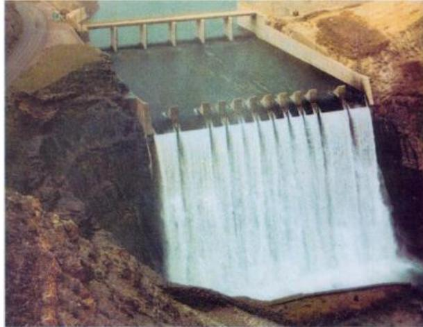
**Figura 18.** Aliviadero de demasías en el represamiento “Gallito Ciego”, Tomada de Las Obras Hidráulicas de concreto en el Perú, 2003, pág 20.
