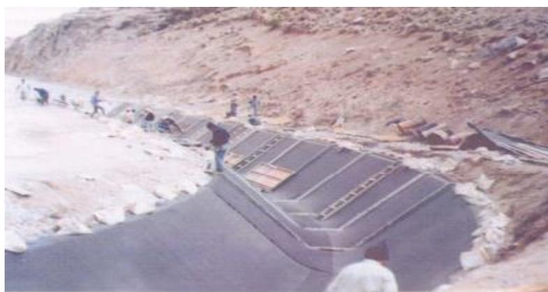
**Figura 21.** Revestimientos especiales en canales, base de concreto cubierto por la geomembrana impermeabilizante antes de la colocación de las losas, Tomada de Las Obras Hidráulicas de concreto en el Perú, 2003, pág 32.
