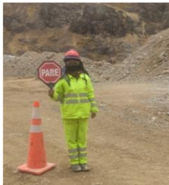
Figura 18. Fotografía del trabajador vigía en relavera A y B área de obras civiles.
