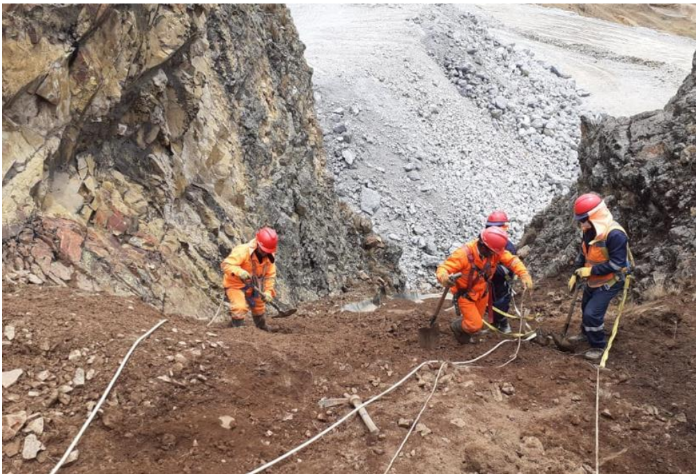
Figura 1. Fotografía de los trabajadores del área de geología.
