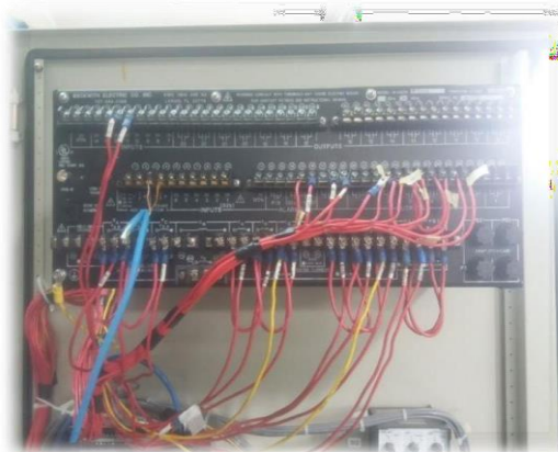
Figura 13 Conexiones del relé
