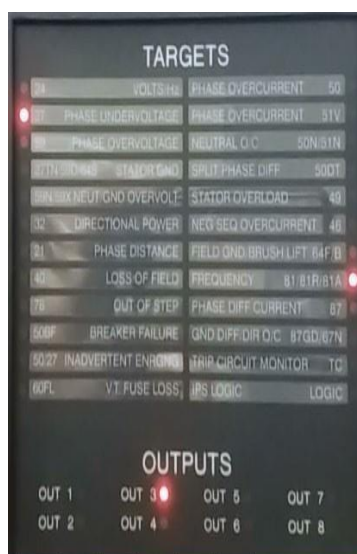
Figura 34 Baja frecuencia (Subfrecuencia) señal en relé
