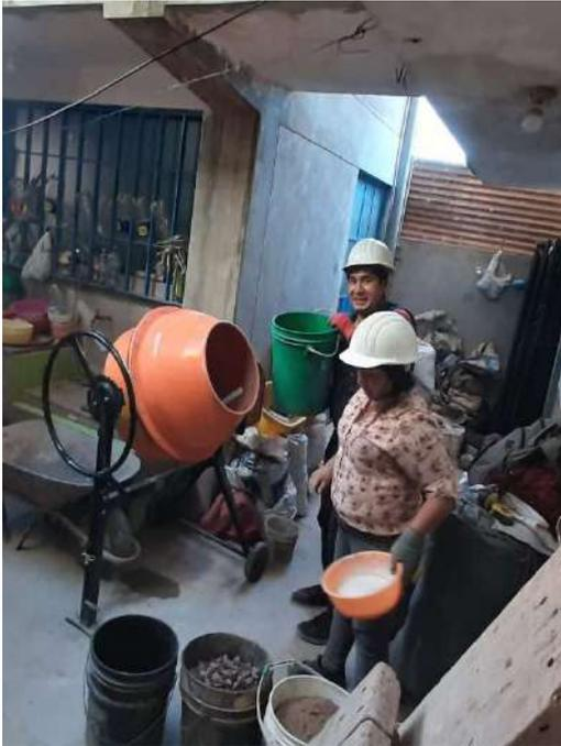
**Figura 67. Mezclado del concreto**
