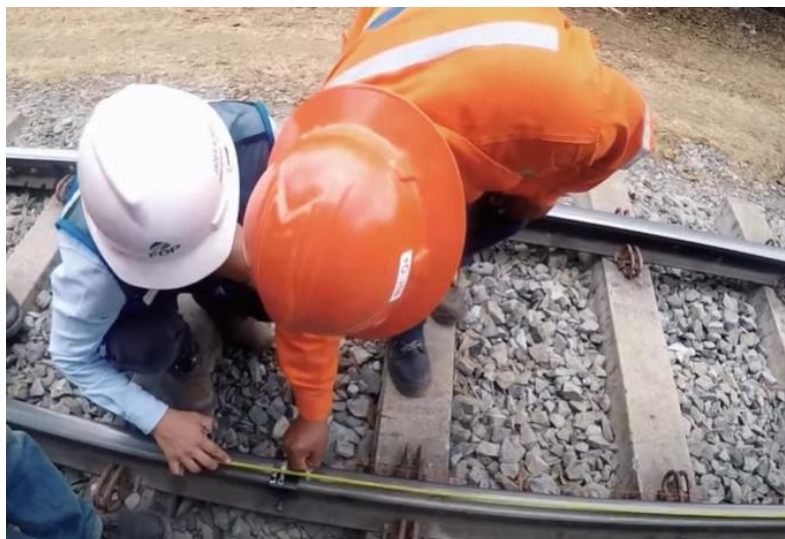
Figura 36. Identificación de las estaciones en el moño de riel
