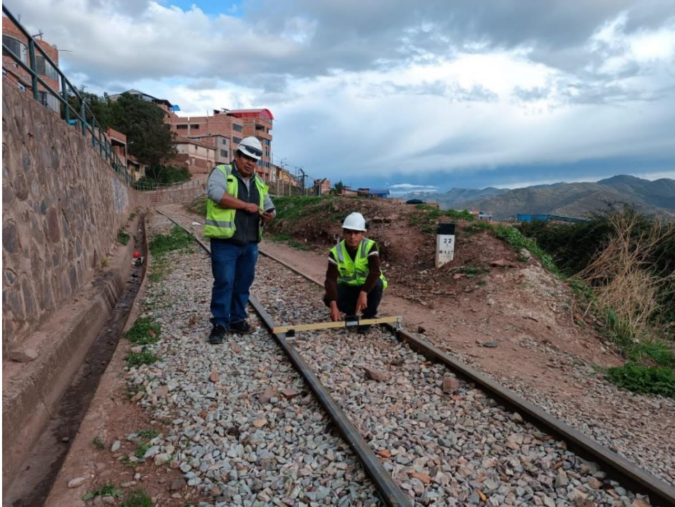
Figura 39. Utilización de la regla de nivel para riel en campo
