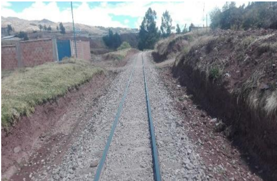
Figura 4. Fotografía de la vía con balasto limpio
