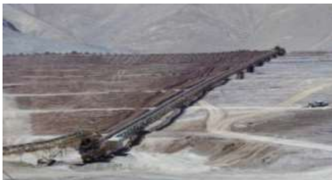
Figura 6. Depósito de Relaves Filtrados. Tomado de “Guía Técnica de Operación y Control de depósito de relaves”, 2017.
