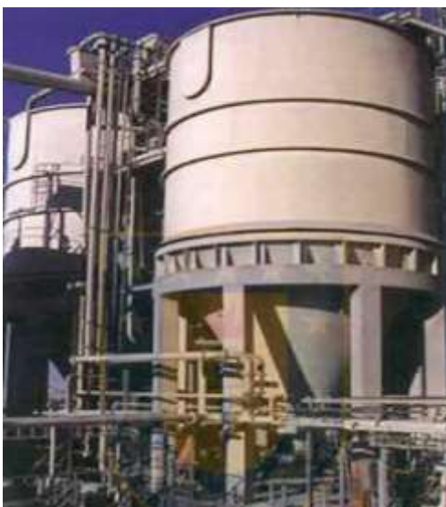
Figura 7. Vista de un espesador de pasta Tomado de “Guía de Operación y control de depósito de relaves”, 2017.
