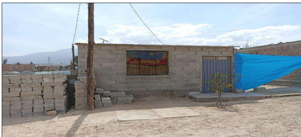
Figura 217. Vivienda analizada N°26 en la Asociación Apipa Sector XV, distrito de Cerro Colorado.
