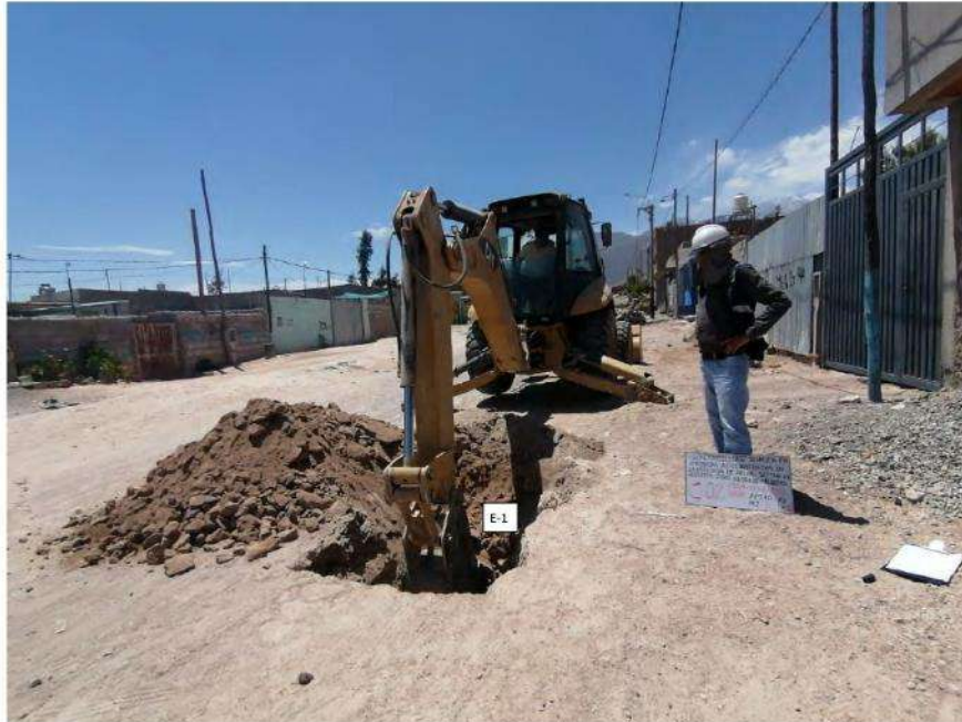
Ilustración 7: Calicata N°2 C-2
