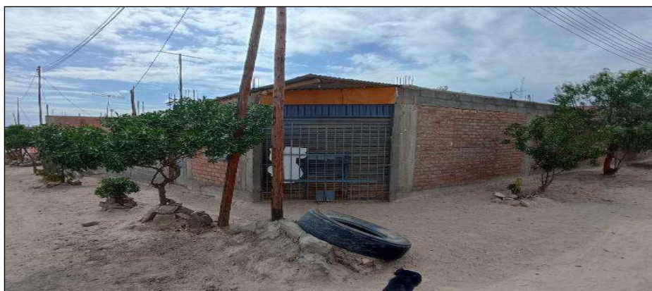
Figura 214. Vivienda analizada N°25 en la Asociación Apipa Sector XV, distrito de Cerro Colorado.
