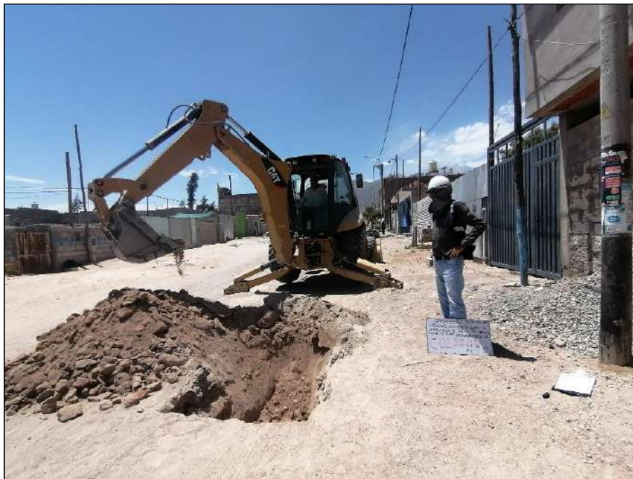
Figura 23. Muestras de la calicata C - 2, en la Asociación de APIPA sector XV, distrito de Cerro Colorado.
