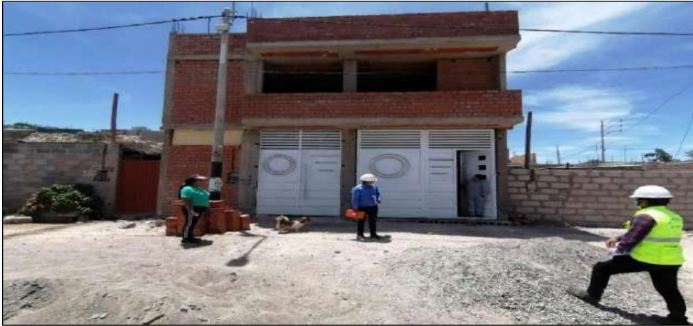
Figura 150. Vivienda analizada N° 05 en la Asociación Apipa Sector XV, distrito de Cerro Colorado.
