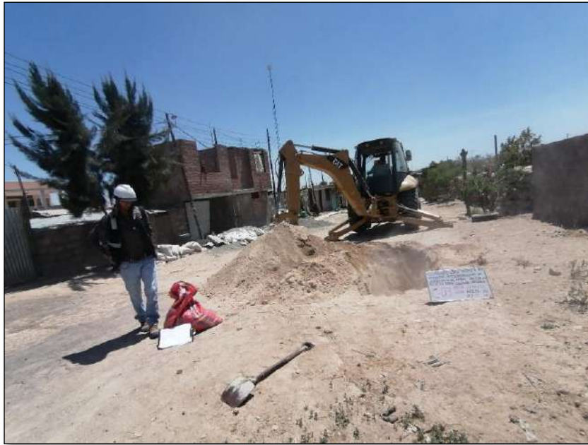
Figura 26. Muestras de la calicata C - 3, en la Asociación de APIPA sector XV, distrito de Cerro Colorado.
