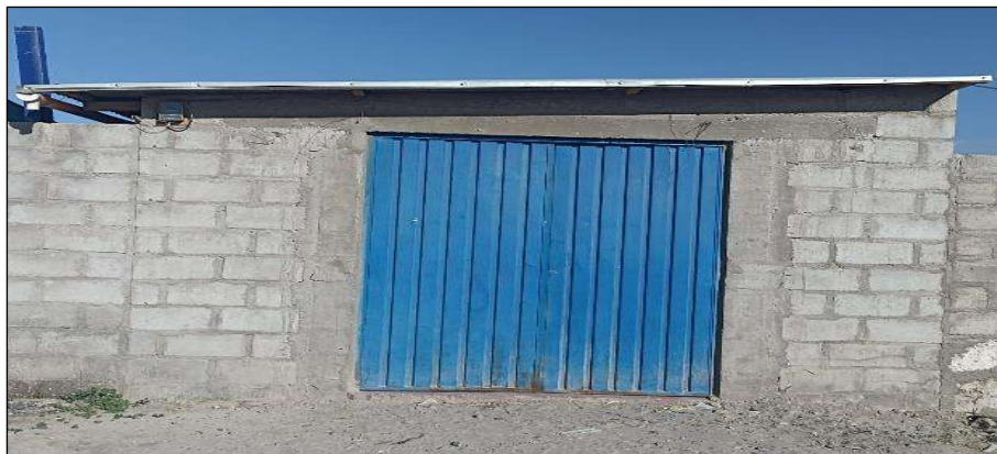
Figura 212. Vivienda analizada N°24 en la Asociación Apipa Sector XV, distrito de Cerro Colorado.
