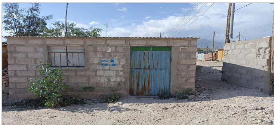
Figura 206. Vivienda analizada N°21 en la Asociación Apipa Sector XV, distrito de Cerro Colorado.
