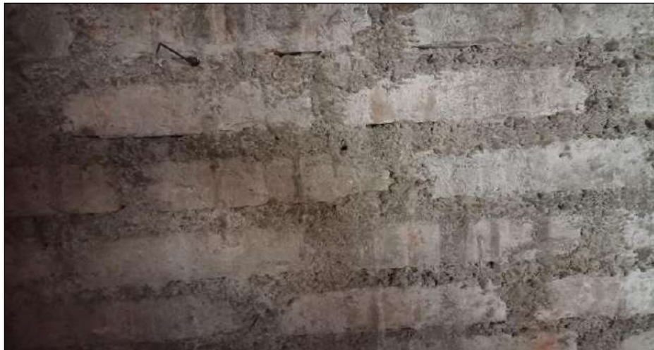
Figura 167. La unidad de albañilería es sólida artesanal.
