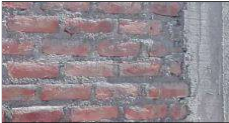
Figura 193. Muros sin rasgos de eflorescencia.
