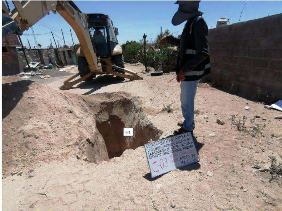
Ilustración 9: Calicata N°3 C-3
