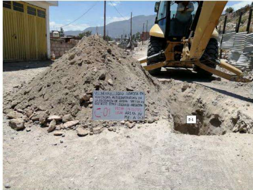
Ilustración 5: Calicata N°1 C-1
