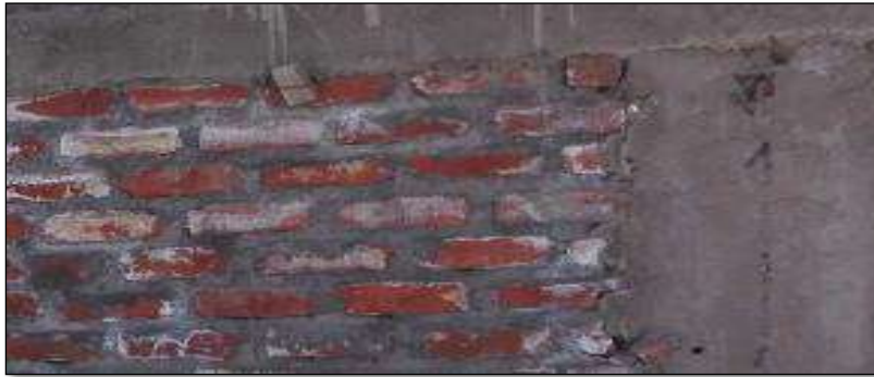
Figura 186. La unidad de albañilería es sólida artesanal.
