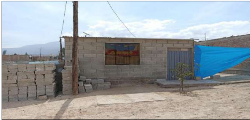
Figura 8. Vivienda de tipología de AVNCDF, en la manzana B, de la Asociación de APIPA sector XV, distrito de Cerro Colorado.
