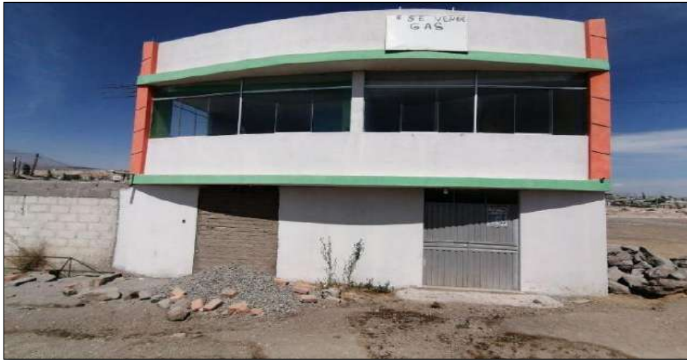
Figura 165. Vivienda analizada N° 09 en la Asociación Apipa Sector XV, distrito de Cerro Colorado.
