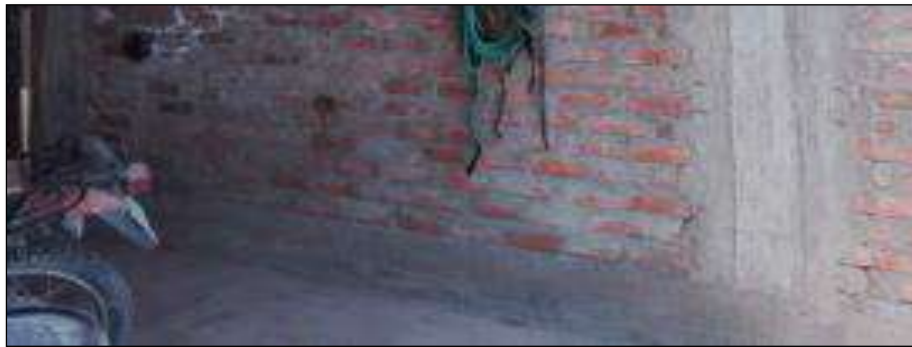
Figura 191. Espesor de la junta y la unidad de albañilería son solida artesanal.
