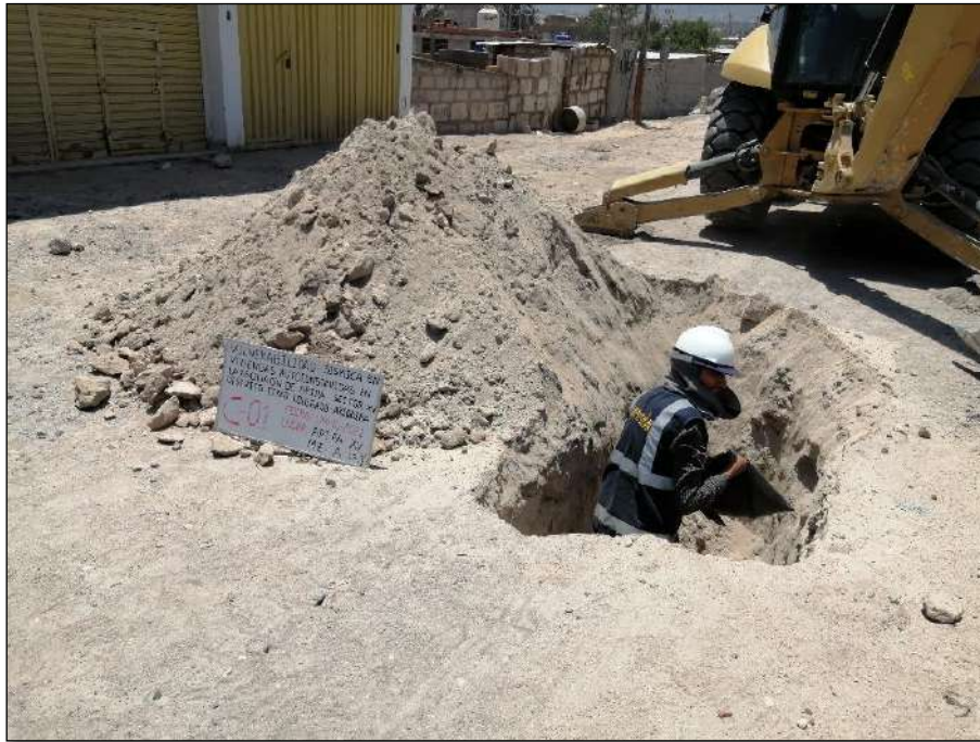
Figura 22. Muestras de la calicata C - 1, en la Asociación de APIPA sector XV, distrito de Cerro Colorado.
