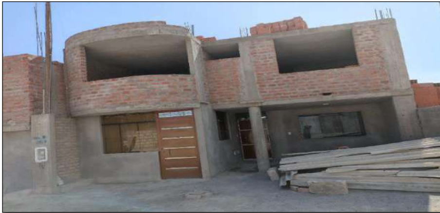
Figura 134. Vivienda analizada N° 01 en la Asociación Apipa Sector XV, distrito de Cerro Colorado.
