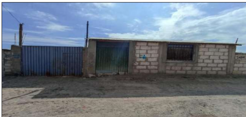
Figura 7. Vivienda de tipología de AVCDF, en la manzana B, de la Asociación de APIPA sector XV, distrito de Cerro Colorado.
