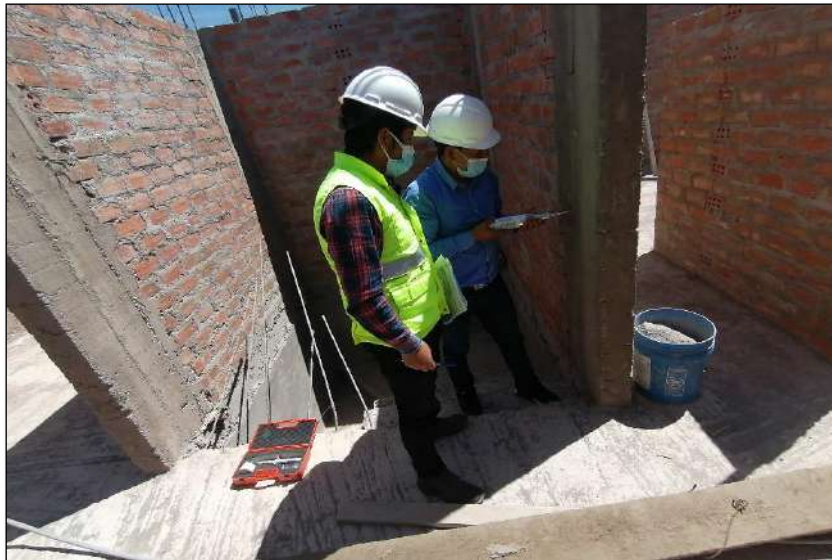
Figura 18. Ensayo del esclerómetro vivienda 1, en la Asociación de APIPA sector XV, distrito de Cerro Colorado.
