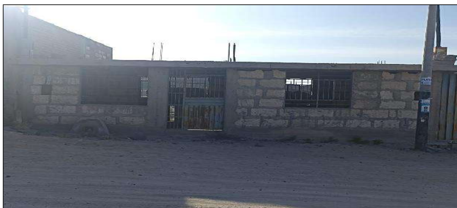
Figura 224. Vivienda analizada N°29 en la Asociación Apipa Sector XV, distrito de Cerro Colorado.
