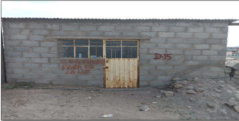
Figura 236. Vivienda analizada N°34 en la Asociación Apipa Sector XV, Distrito de Cerro Colorado.
