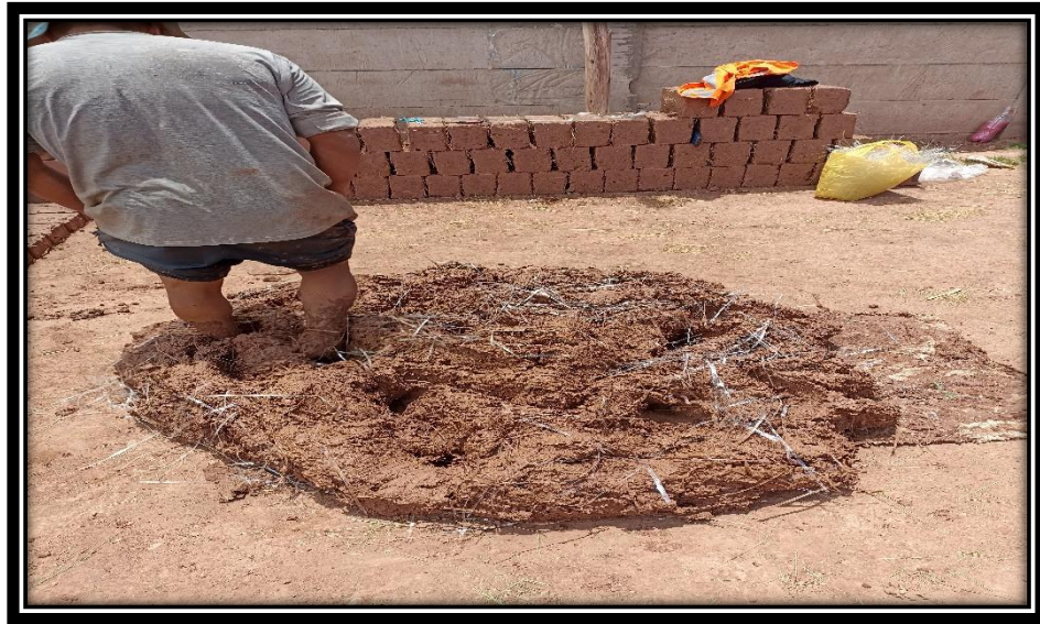
Figura 42. Preparación del adobe con el 3 % de tiras de PET.
