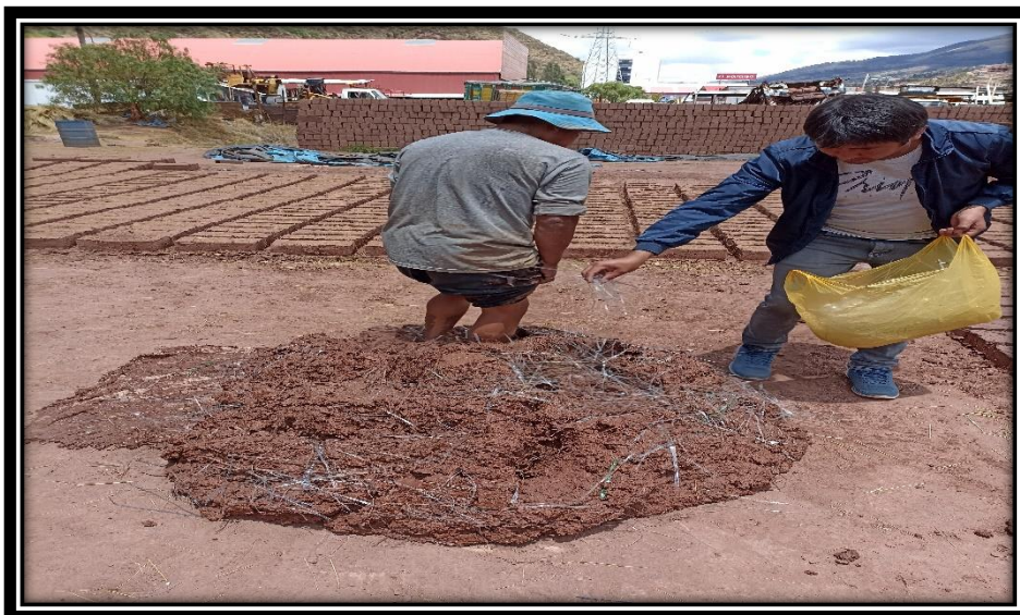
Figura 35. Mezcla del adobe con el 1 % de tiras de PET.
