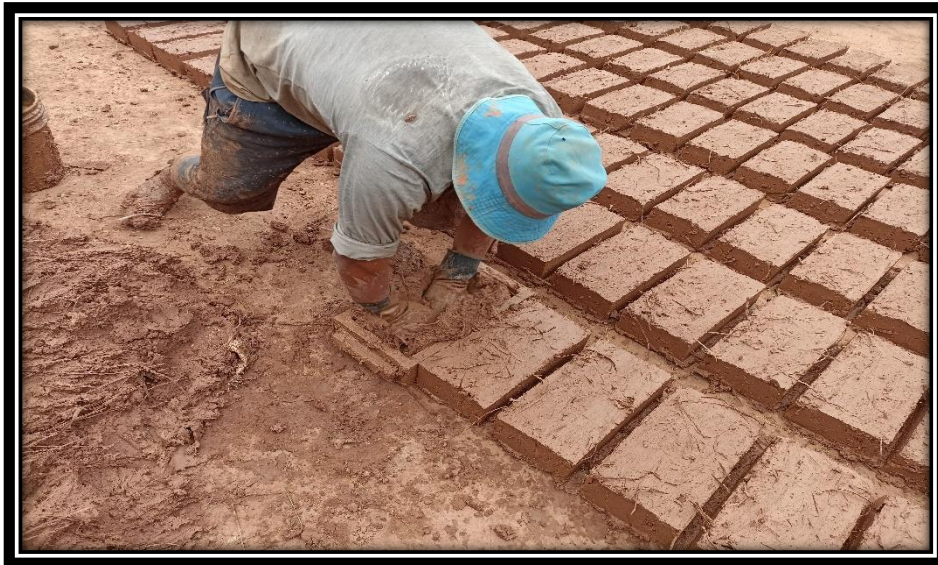
Figura 40. Elaboración de los adobes con el 2 % de tiras de PET.
