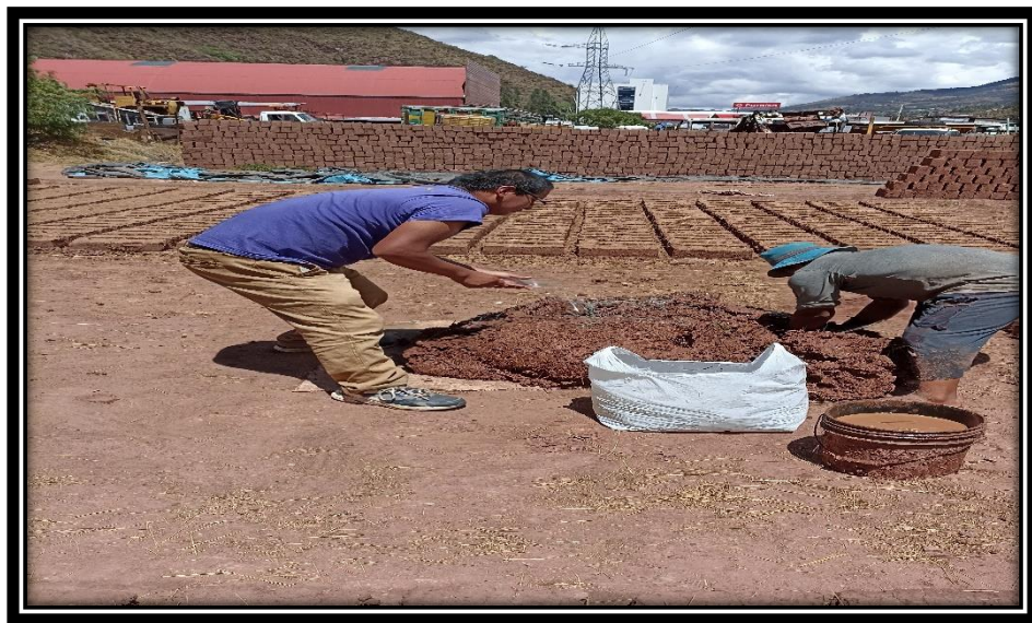
Figura 43. Mezcla del adobe con el 3 % de tiras de PET.
