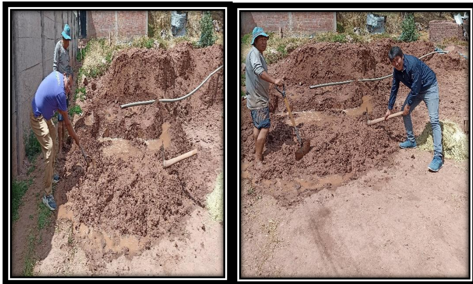
Figura 30. Elaboración de la mezcla de barro.
