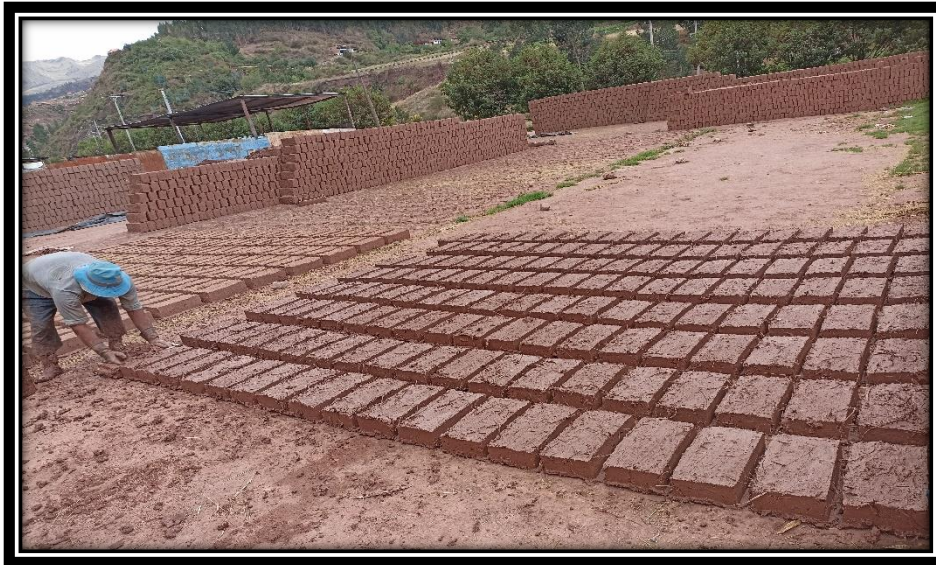
Figura 41. Secado de los adobes con el 2 % de tiras de PET.
