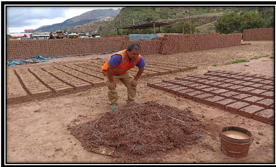
Figura 38. Preparación del adobe con el 2 % de tiras de PET.
