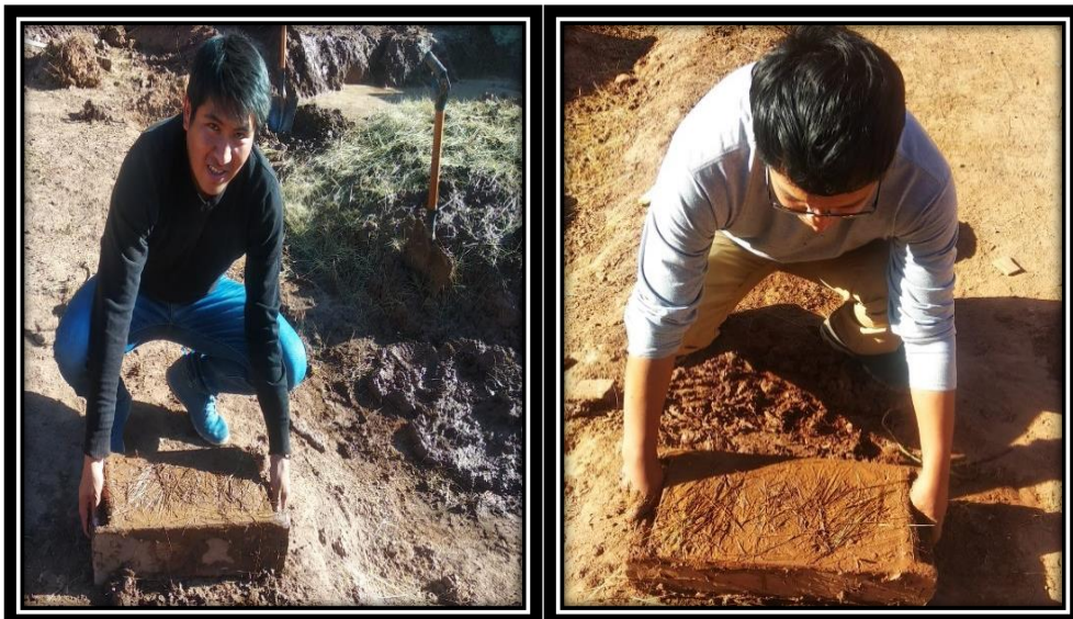
Figura 32. Fabricación de adobe control (con paja).
