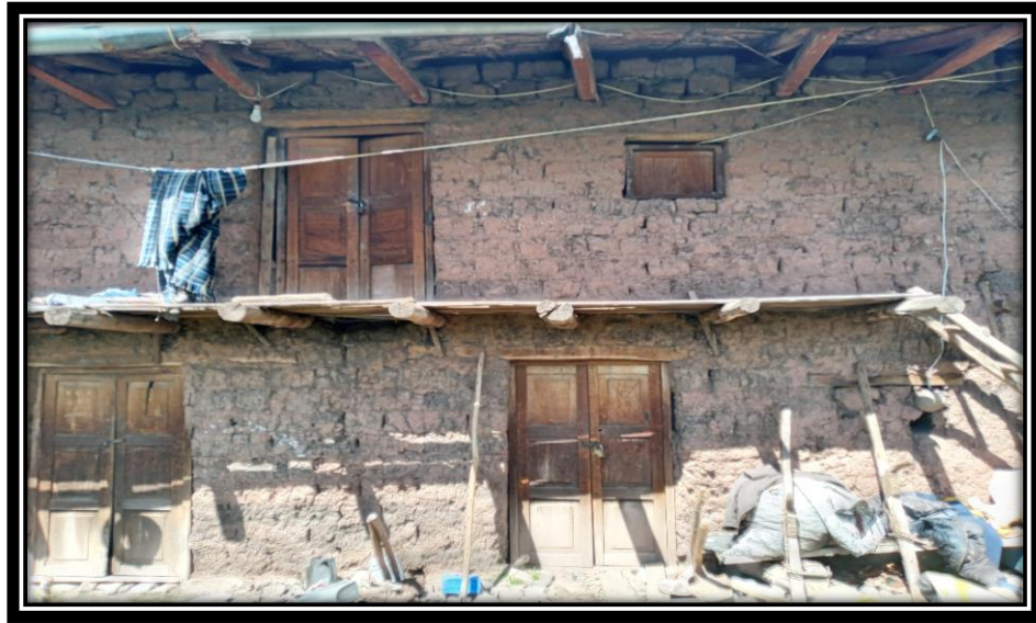
Figura 2. Vivienda de adobe sin protección de estucado de yeso o tarrajeo de cemento.
