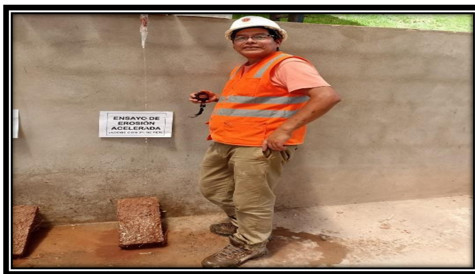
Figura 9. Erosión acelerada del adobe.
