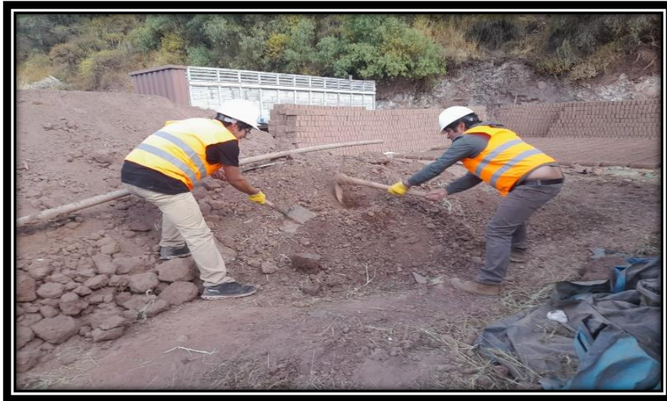
Figura 29. Selección para humedecer la tierra por 24 horas.
