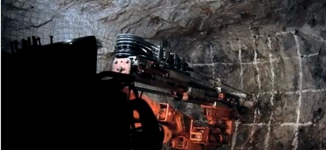
Figura 12. Perforación de frente de avance en la unidad minera Huarón
