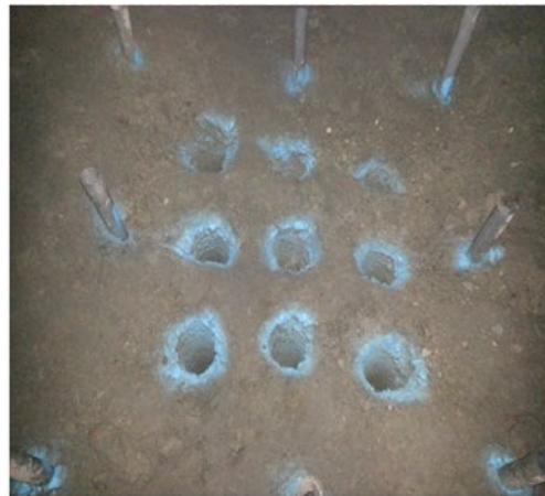
Proceso de perforación con la nueva malla
