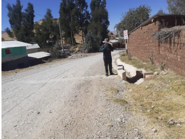
Fotografía 3. Inicio de cuneta, progresiva 0+135, julio de 2023.
