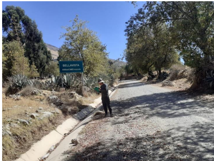
Fotografía 6. Progresiva 0+454, que se encuentra poco saturada de sedimentos, julio de 2023. Nota: Elaboración propia.
