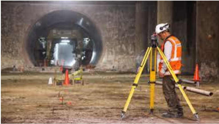
Imagen 2: Nivel de Ingeniero para altimetría subterránea.
