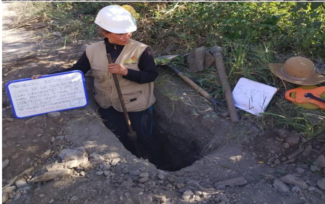
Fotografía N°1: Extracción de las muestras de suelo de la subrasante
