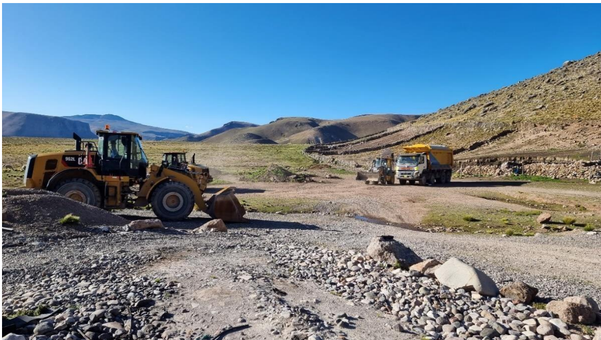
Figura 7. Equipos en espera de mantenimiento
