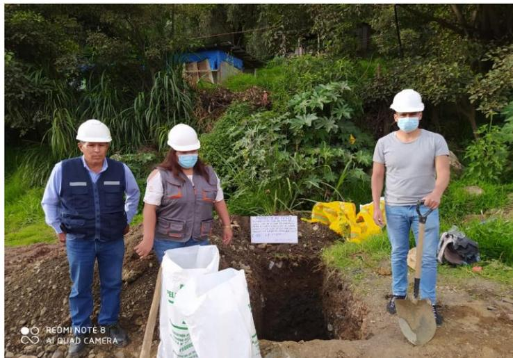
**Figura 28. Calicata C1, KM 3+879, según ASTM D 420 y MTC E 101 (UTM - 13.63256663346755 Norte, -72.9007749878841 este)**
