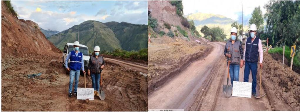
**Figura 22. Localización de zonas críticas y reconocimiento para la apertura de las calicatas, km 03+464, según ASTM D 420 y MTC E 101 (UTM -13.632132112106024 Norte, -72.90552559522882 este)**
