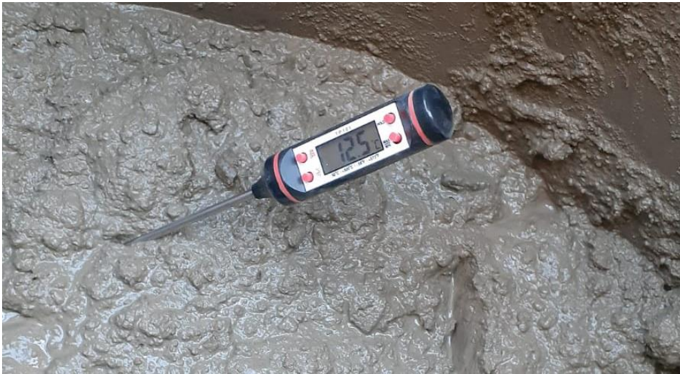
FOTOGRAFÍA 01: MEDICION DE TEMPERATURA DEL CONCRETO
