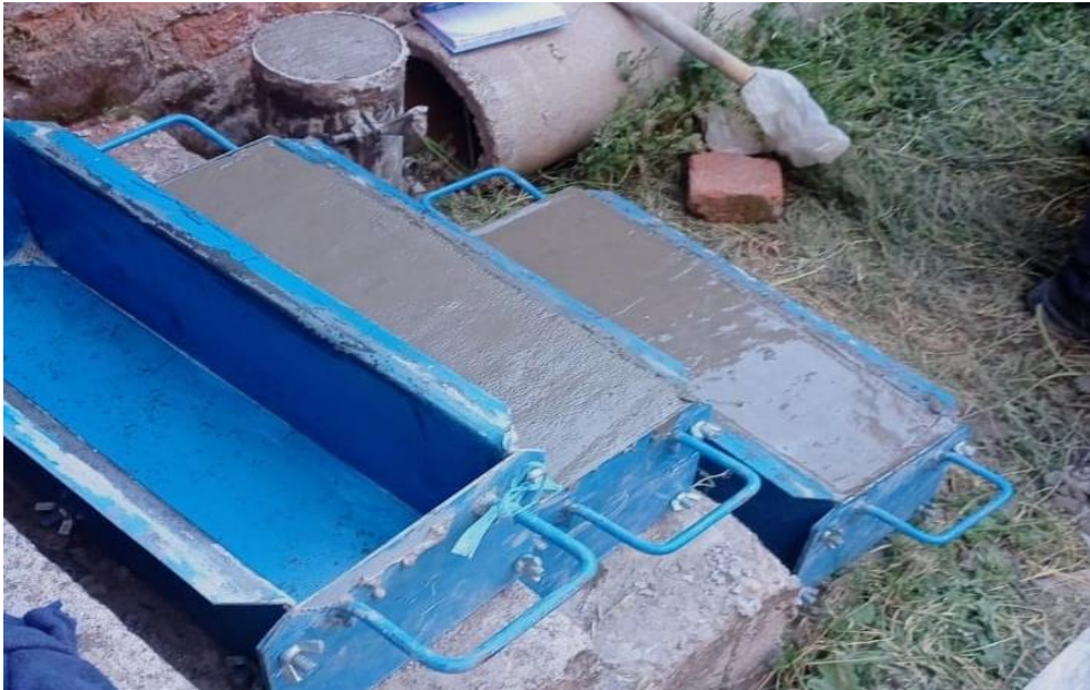
FOTOGRAFÍA 03: VACIADO DE VIGAS PARA LA PRUEBA DE FLEXIÓN.
