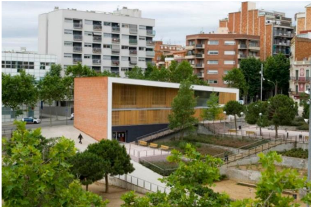
Figura 107. Acceso principal Nota. Vista del acceso principal Extraída en ArchDaily
