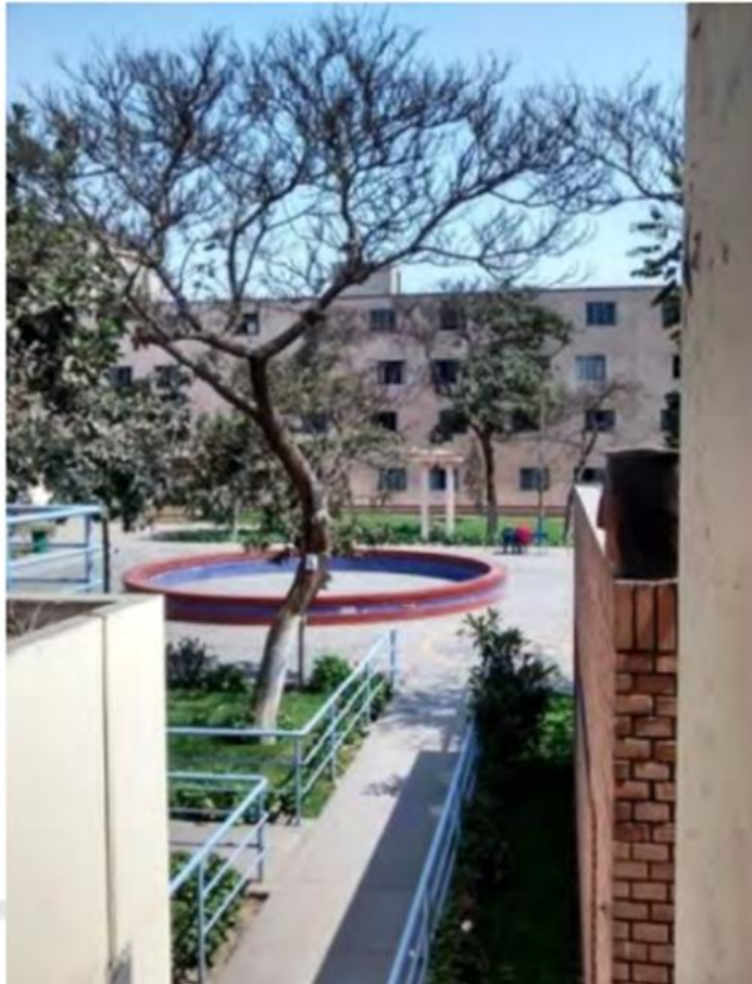
Figura 121. Vista del interior del albergue Nota. Vista del patio central del albergue. Extraída de Sánchez (178)
