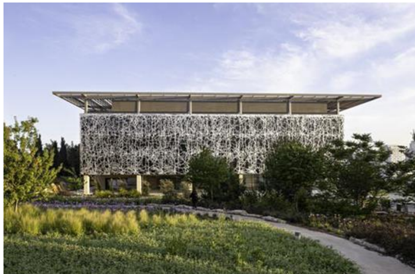
Figura 45. Centro de Ciencias del Cerebro Edmond y Safra Nota. Fachada principal del Centro de Ciencias del cerebro Edmond y Safra Extraído de ArchDaily.pe
