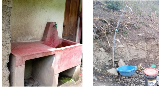
Figuras 7 Módulo Municipalidad de Yanatile - Instalaciones adecuadas
