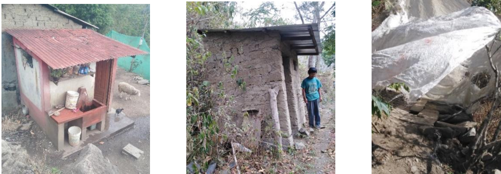
Figuras 8. Módulo Municipalidad de Yanatile – Módulo GORE Cusco – SS. HH Adecuado
