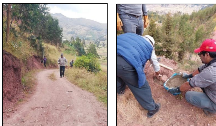
Figuras 59. Trabajos de campo.
