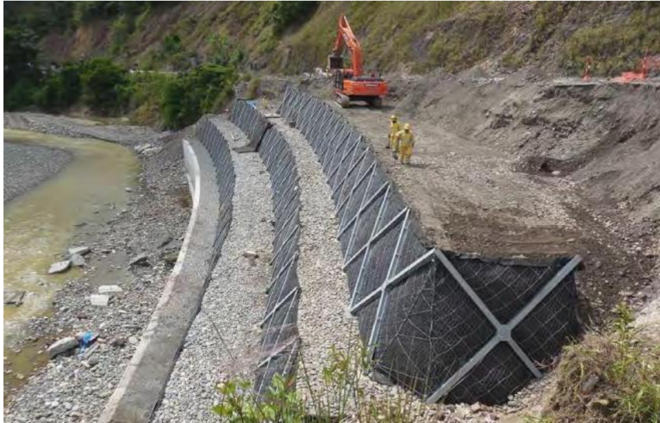
Figura 27 Geomanta colocada sobre cada uno de los andenes de ErdoX
