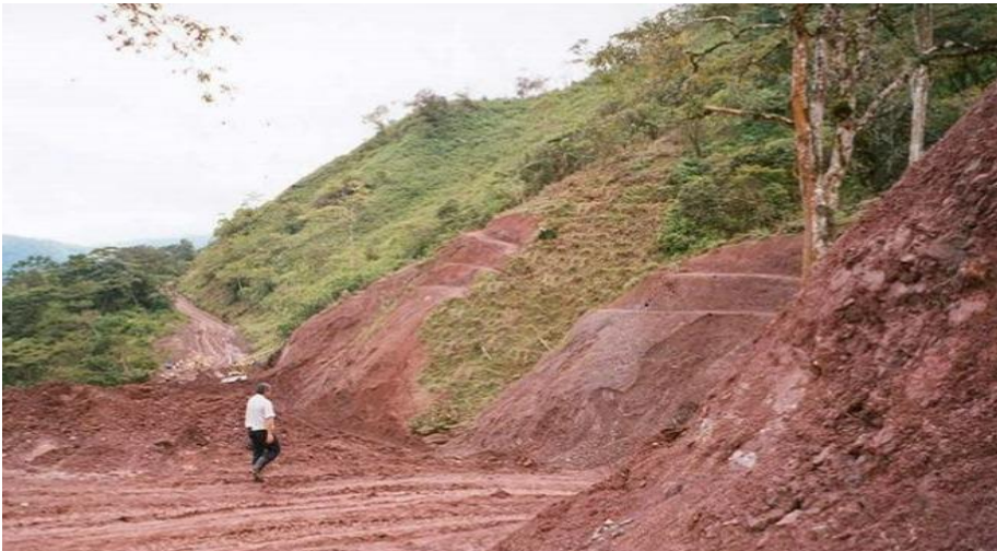
Talud de corte
