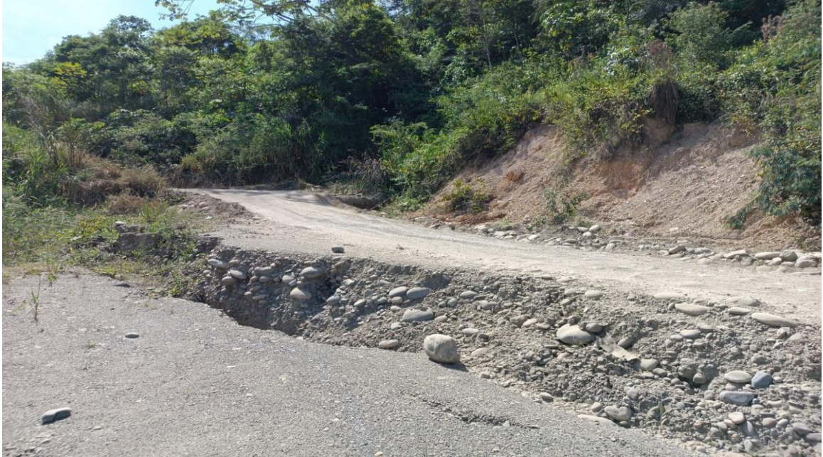
Figura 32: Carretera CU-566: PE-28B Chirumpiari – San Carlos.
