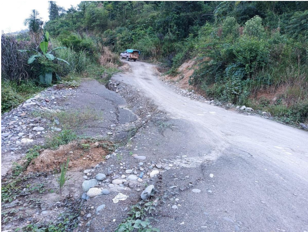
Fotografía 04: Presencia de falla por hundimiento
