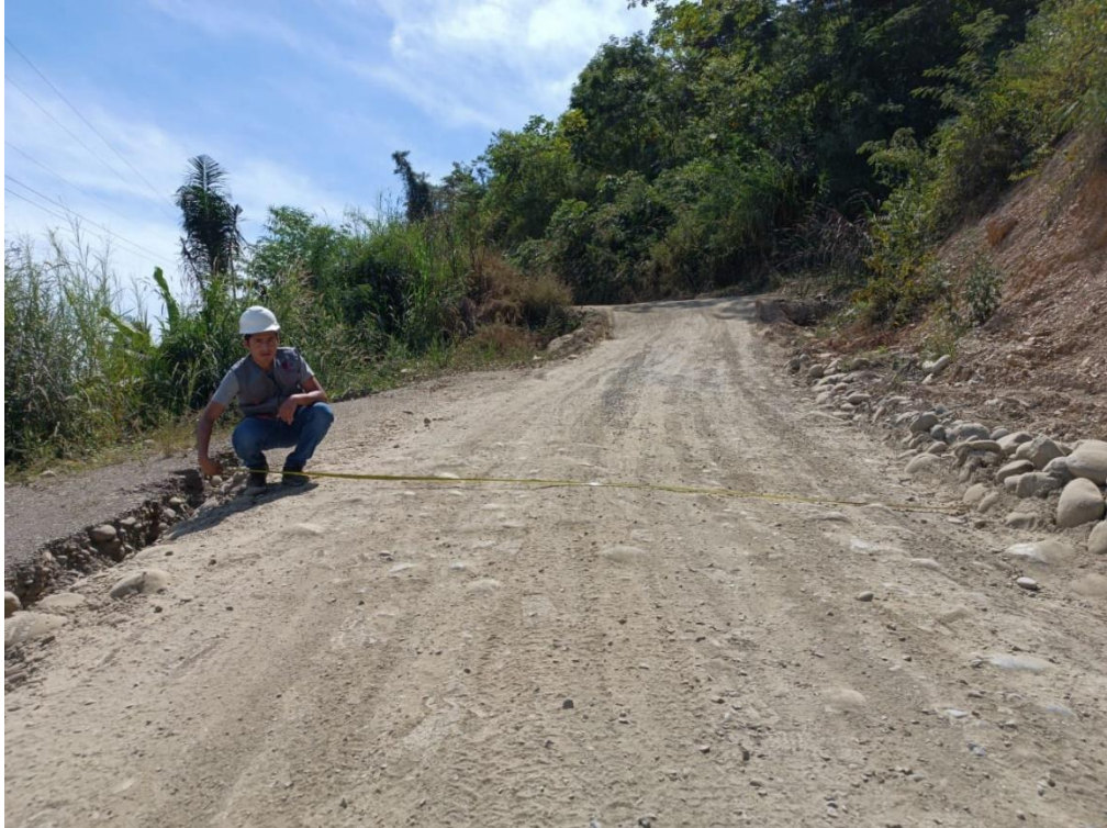
Fotografía 02: Medida del ancho de la plataforma.
