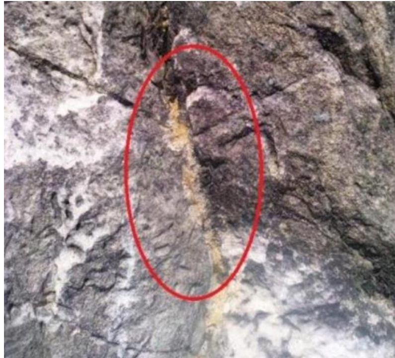
Figura 11 Abertura en diaclasas de 2 cm con relleno (5)
