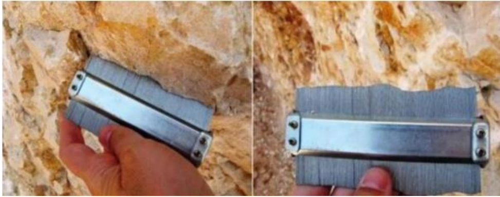
Figura 10. Clasificaciones de la rugosidad de la pared del plano de discontinuidad mediante filometro (5)
