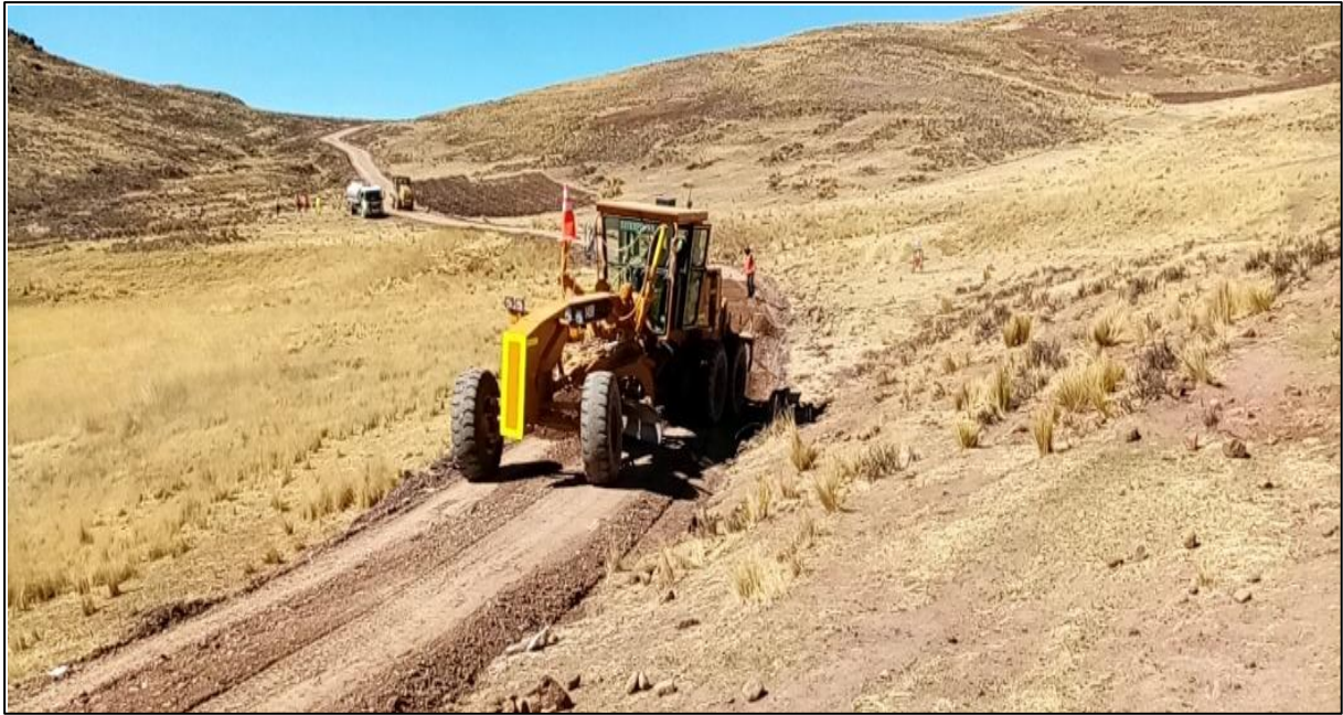
Fotografía 10. Vista de los trabajos de perfilado en la vía desde el Emp. PE 34 H - Emp. PU-852.
