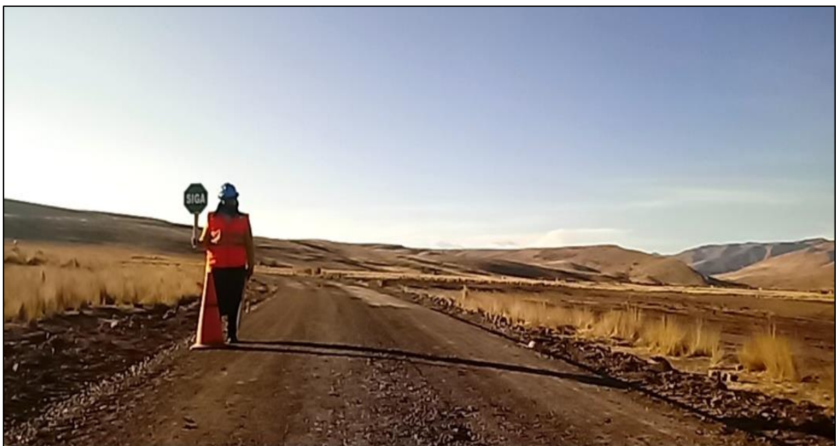
Fotografía 5. Vista de las actividades de vigilancia y control vial desde el Emp. DV Mijani - Sector Mijani.
