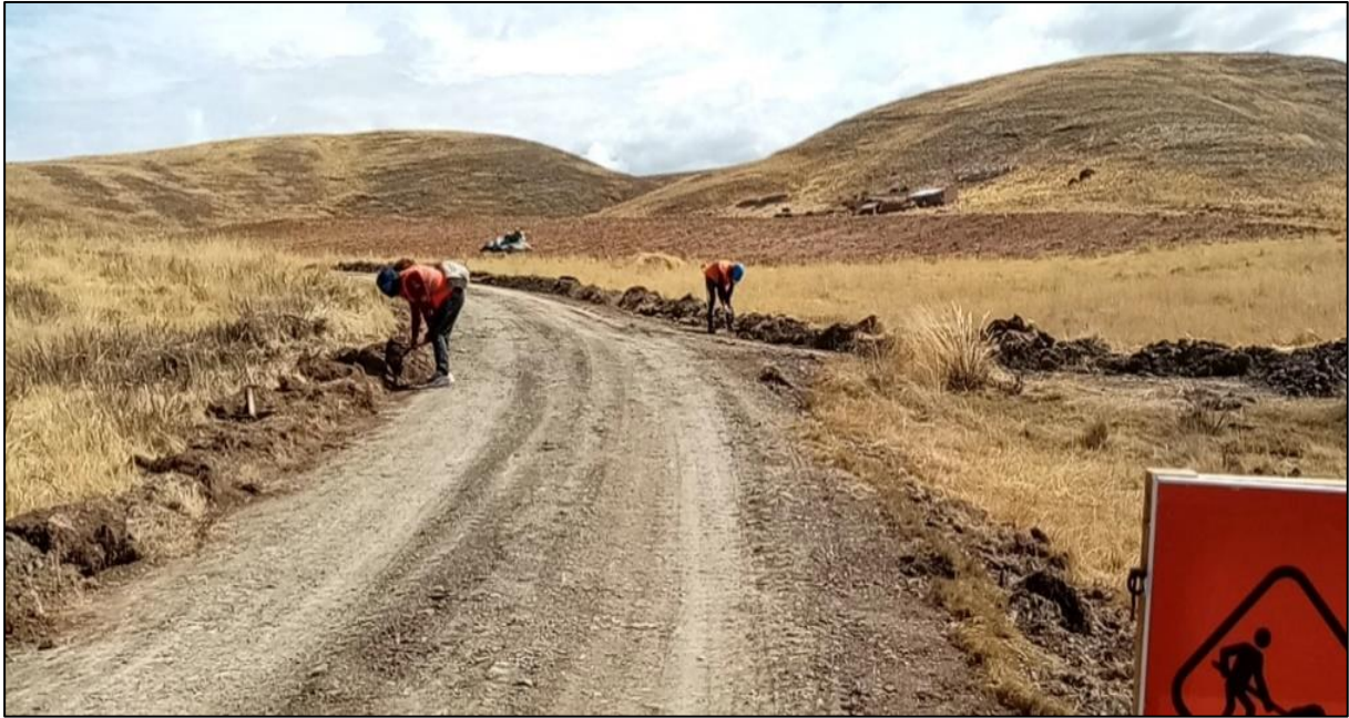
Fotografía 2. Vista de los trabajos de roce y limpieza en la vía Emp. PU 827 (San Francisco) - Taraucani.
