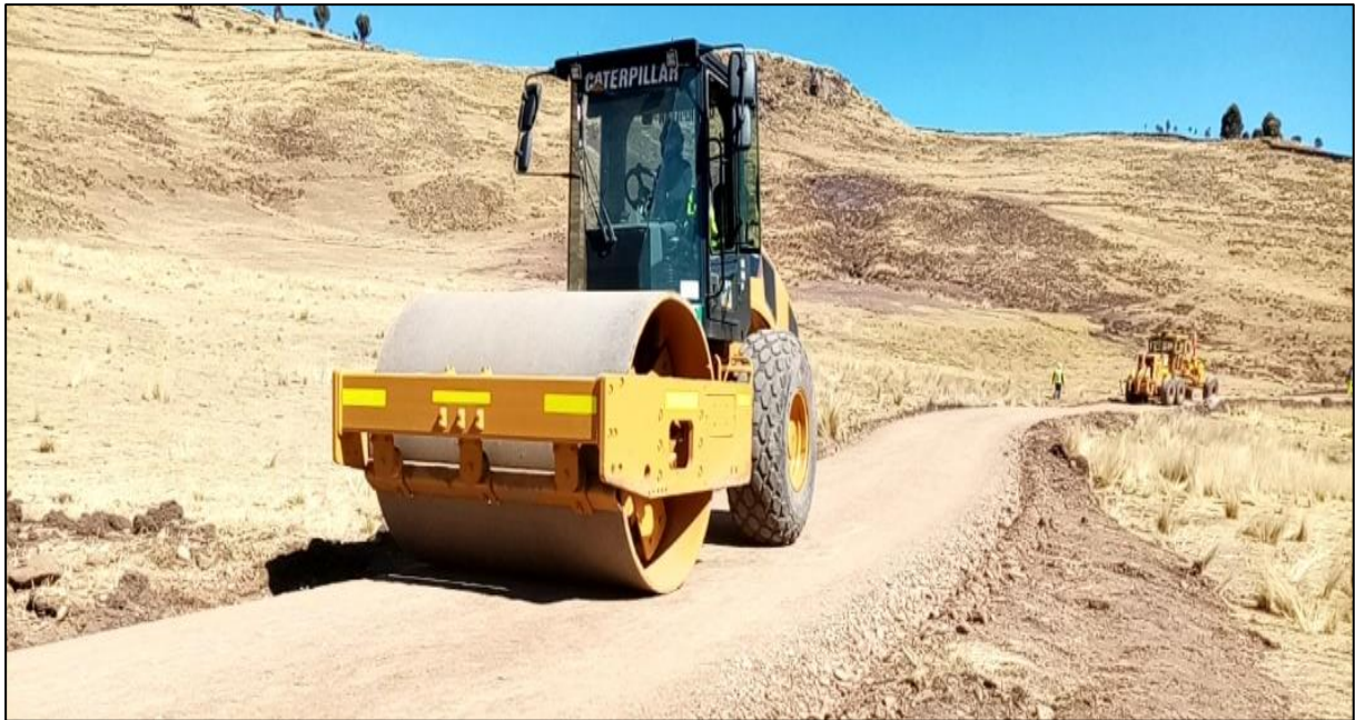
Fotografía 4. Vista del compactado de la vía Emp. PE-34H – Chamacani.
