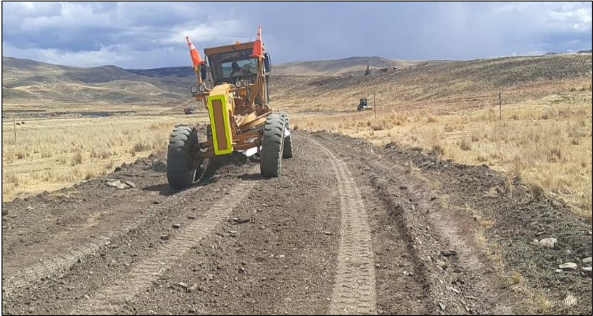
Fotografía 6. Vista de perfilado de la vía Emp. PE-34H (Quilcapunco) - Emp. PU-827 (Uyuni).
