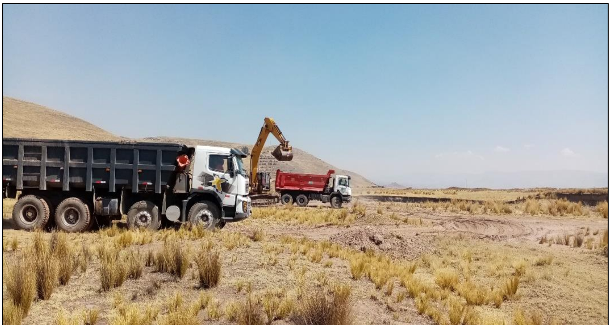
Fotografía 9. Vista del traslado de material de cantera, en la vía desde el Emp. DV Mijani - Sector Mijani
