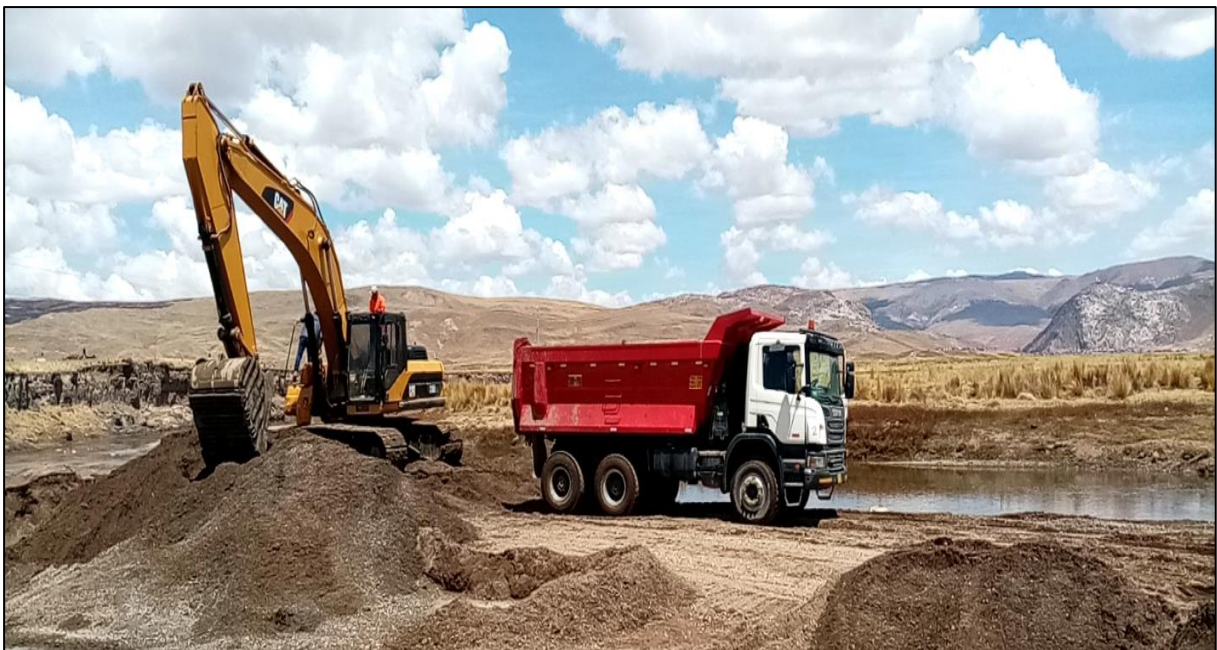
Fotografía 11. Vista del traslado de material desde cantera en la vía desde el Emp. PE-34H – Chamacani.
