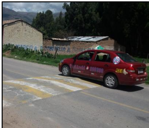
Figura 37. Fallas de la vía en la progresiva 10+127.71
