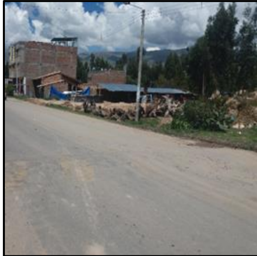
Figura 16. Fallas de la vía en la progresiva 6+669.07
