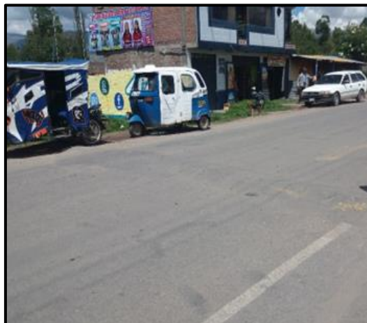
Figura 13. Fallas de la vía en la progresiva 4+315.16
