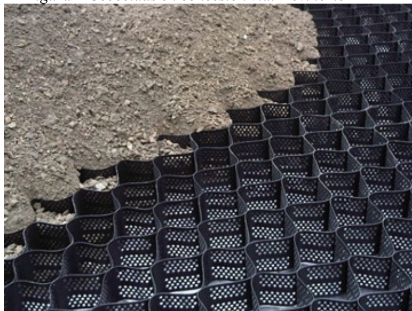
Figura 2 Geoceldas en concesión vial Devinorte
