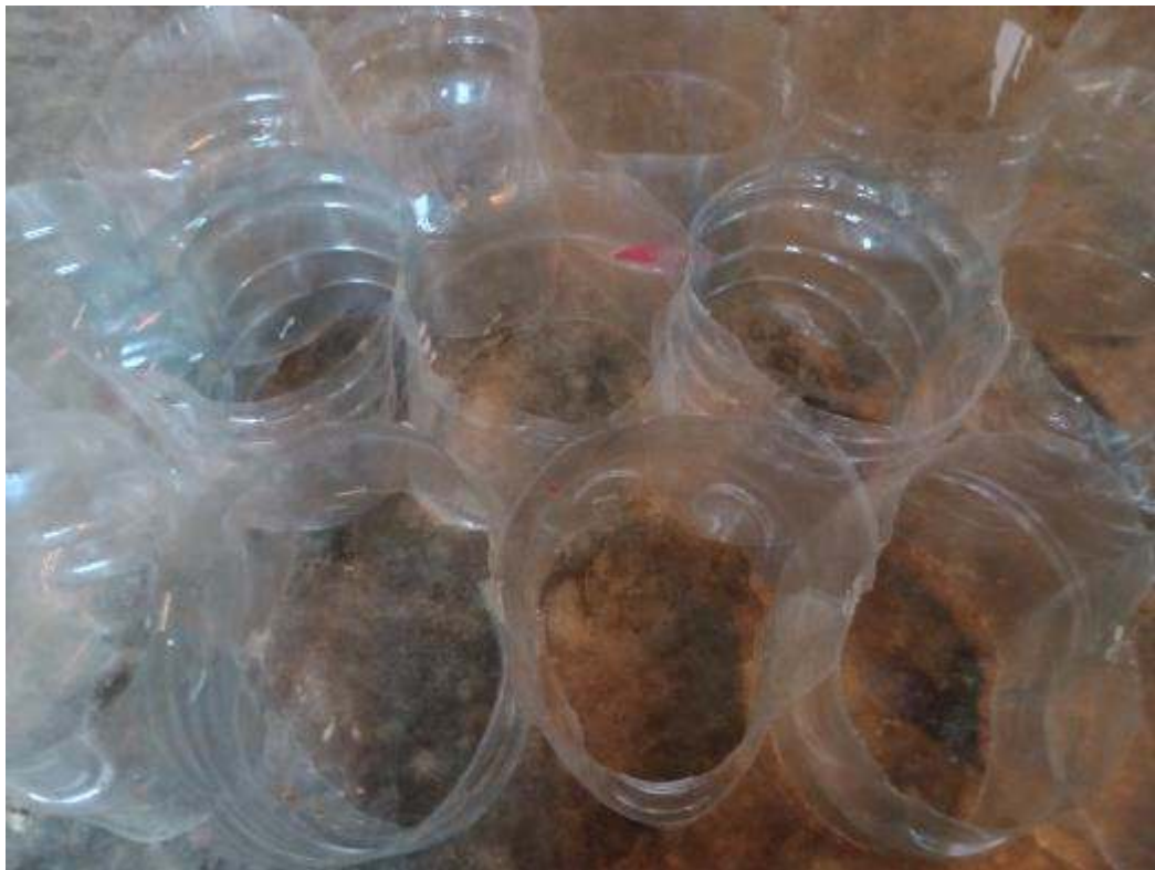
Anexo 8 Armado de geoceldas de botellas PET diámetro de 7.5cm y altura 10cm
