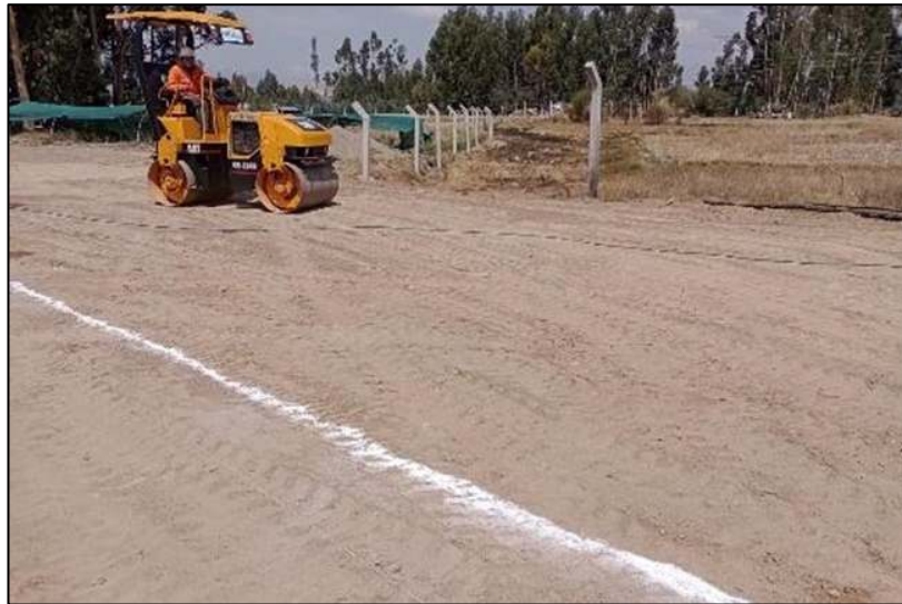
Figura 9 Compactación de plataforma con rodillo para conformación de rasante.
