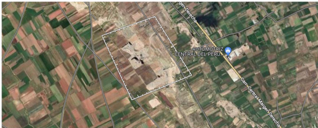
Figura 5. Planta Chancadora de agregados ubicada en Sicaya
