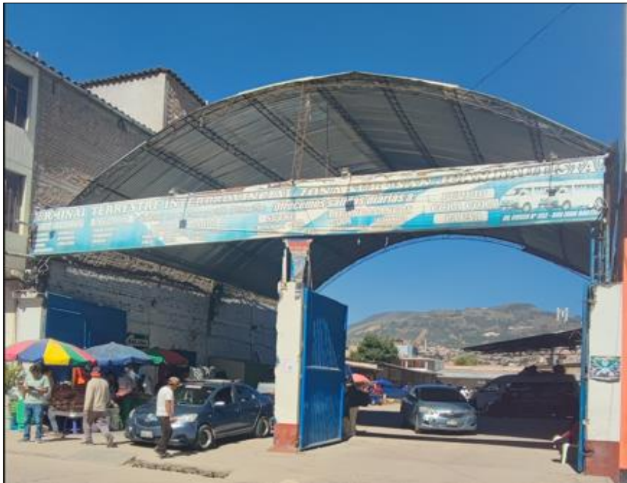
Gráfico 3. Fachada y forma del terminal terrestre.
