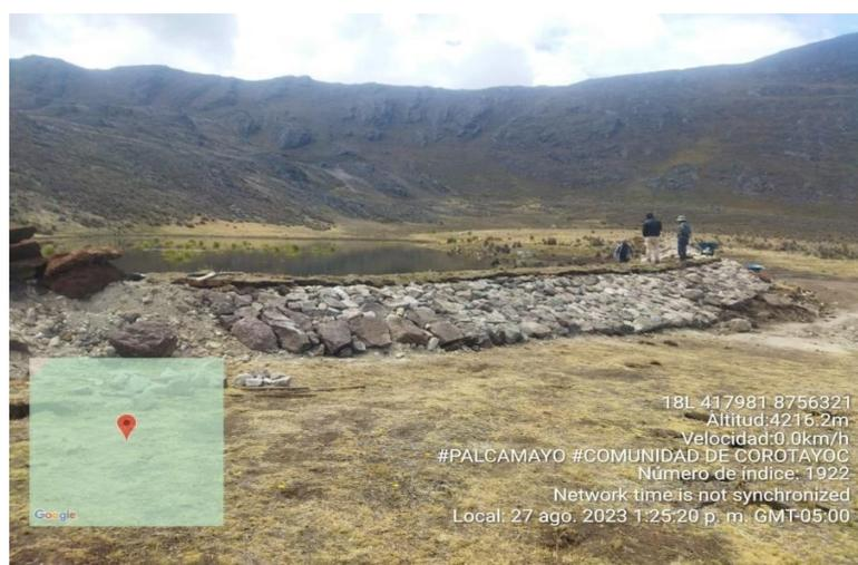
Figura 8. Dique artesanal construido en el bofedal Pukacocha.
