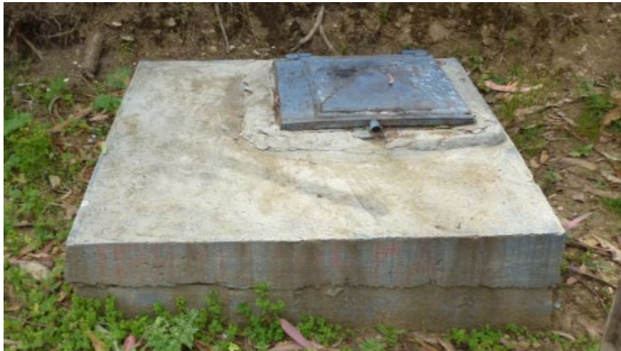
Ilustración 6: Captación antigua (en desuso) de la JASS Cullpa Alta
