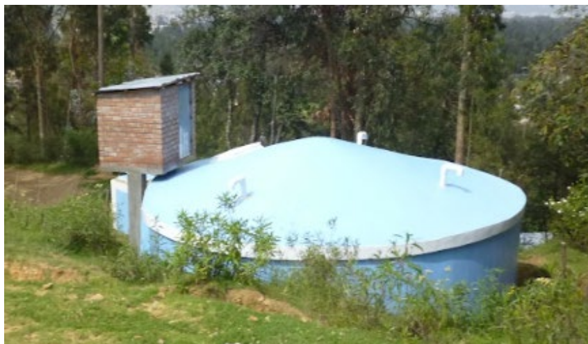
Ilustración 7: Poza de Cloración (Salida del sistema) de la JASS Cullpa Alta
