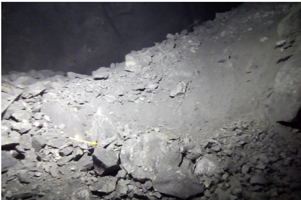
Figura 14. Incremento del tamaño de la granulometría, Tj 9790
