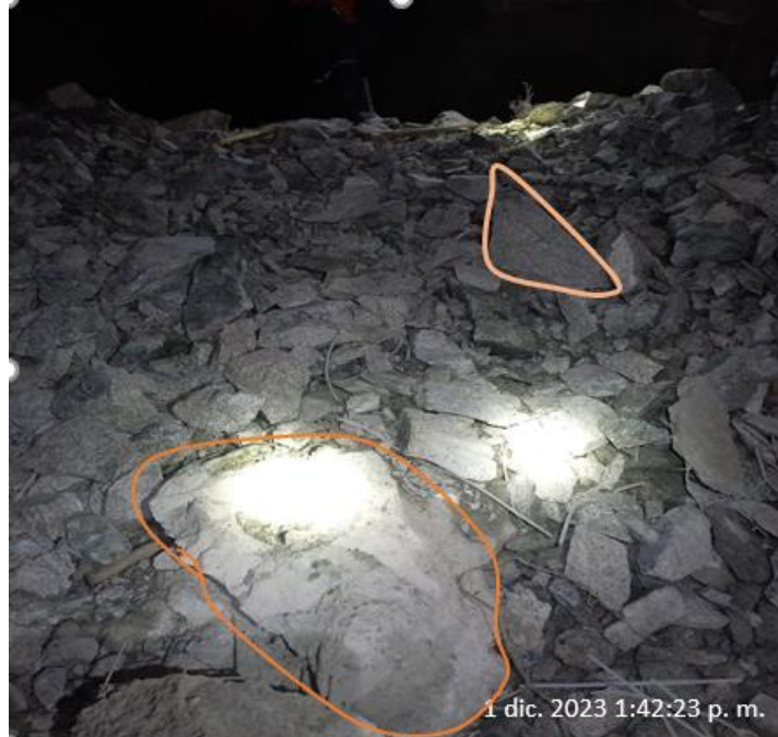
Figura N. 4: Frente de avance después del disparo del Gal 10316-N (Bp 10316-Ne), Zona Valeria IV
