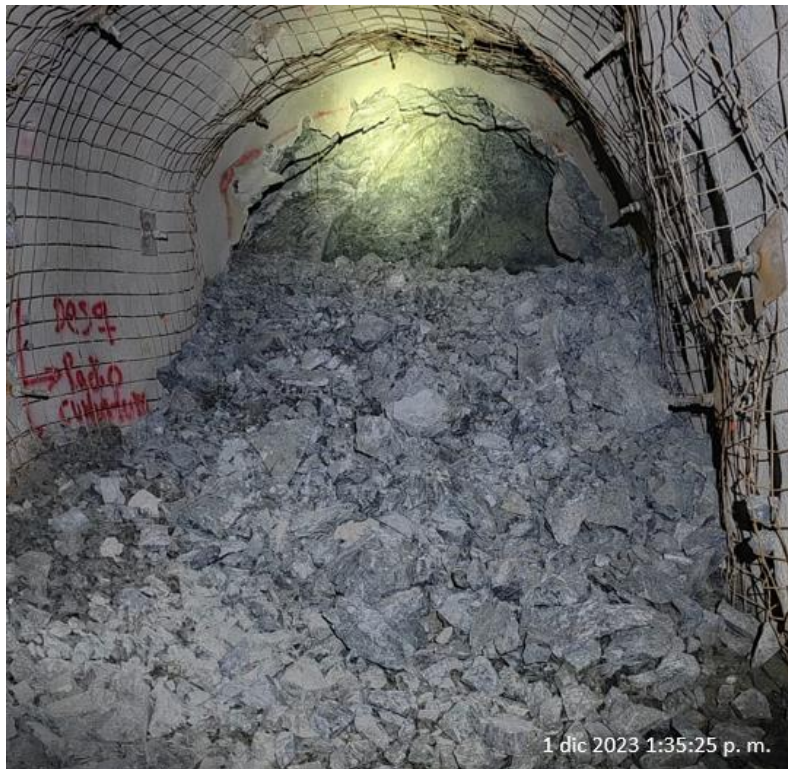
Figura N. 12: Escenario situacional de la fragmentación de la Galería 10316.
