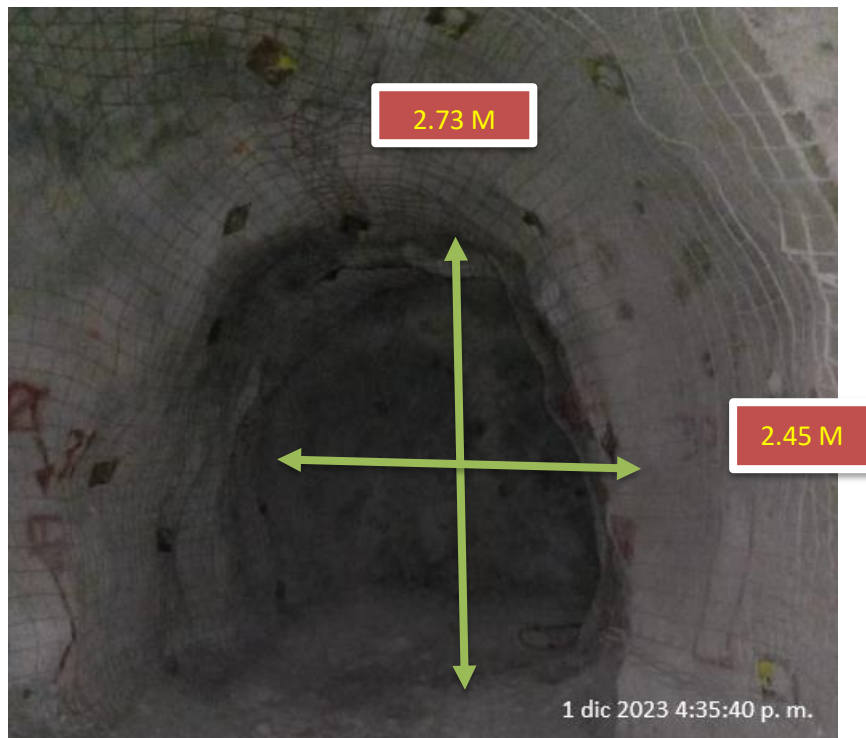
Figura N. 17: Escenario de mejora evaluación de la sobre excavación y dilución de la Galería 10316.
