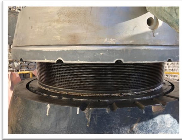
Figura 30. Anillo roscado bajando junto al anillo de sacrificio.
