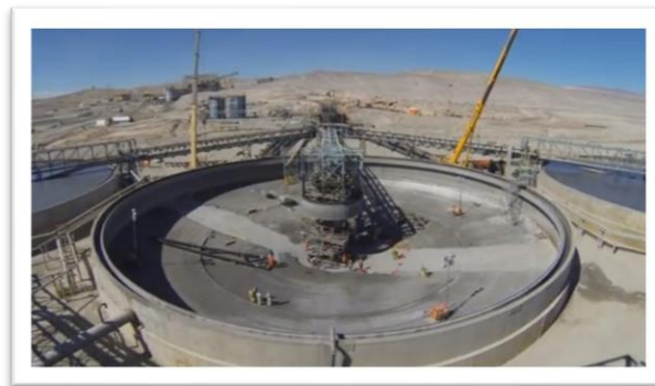
Figura 13. Mantenimiento de espesadores en planta de cobre (Mantenimiento industrial, 2023)
