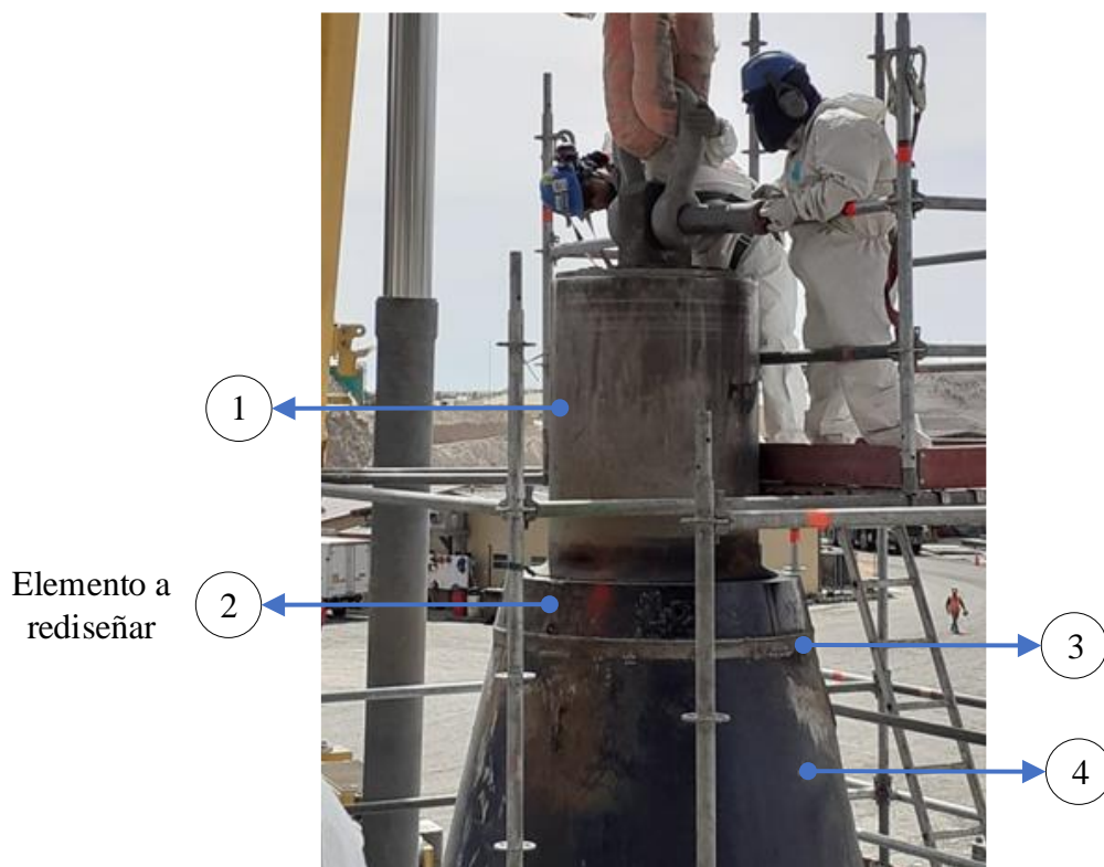
Figura 28. Equipo en pleno proceso de cambio de mantos.
