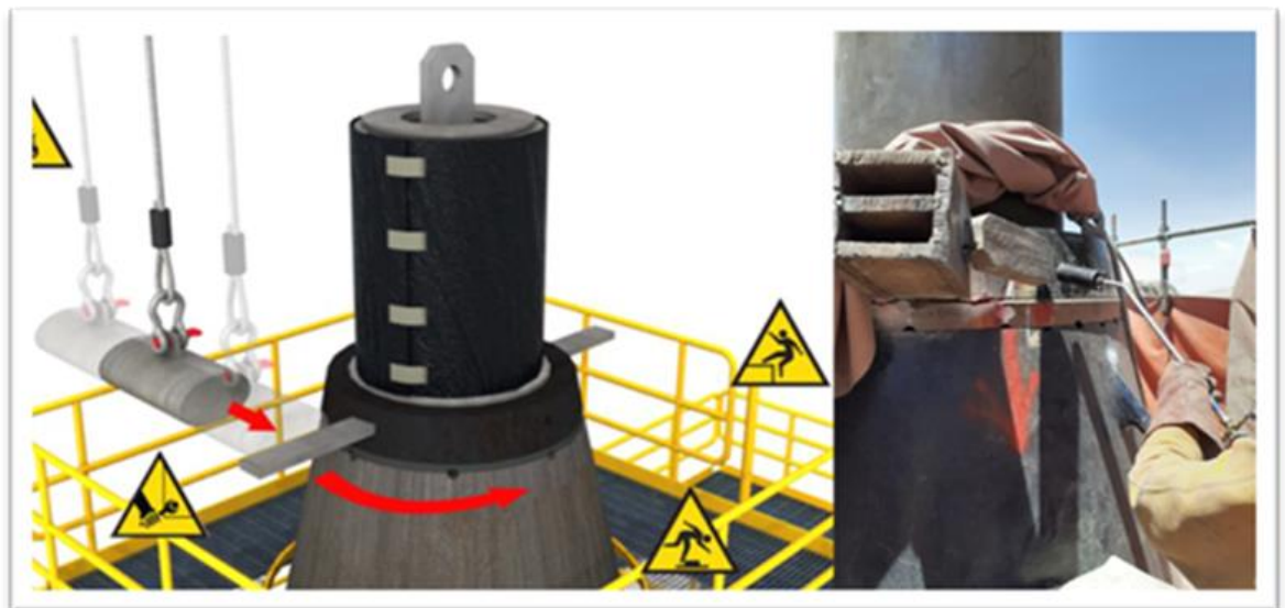
Figura 32. Soldeo de elemento para ajustar el anillo roscado (FLsmith, 2022).
