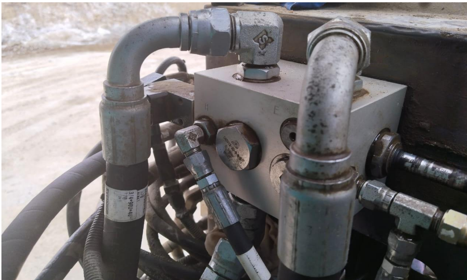
Foto tomada válvula de alivio del sistema de percusión perforadora UG-01 Mina Alampara
